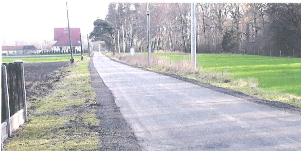
Wyremontowany odcinek drogi w Braszczoku.
