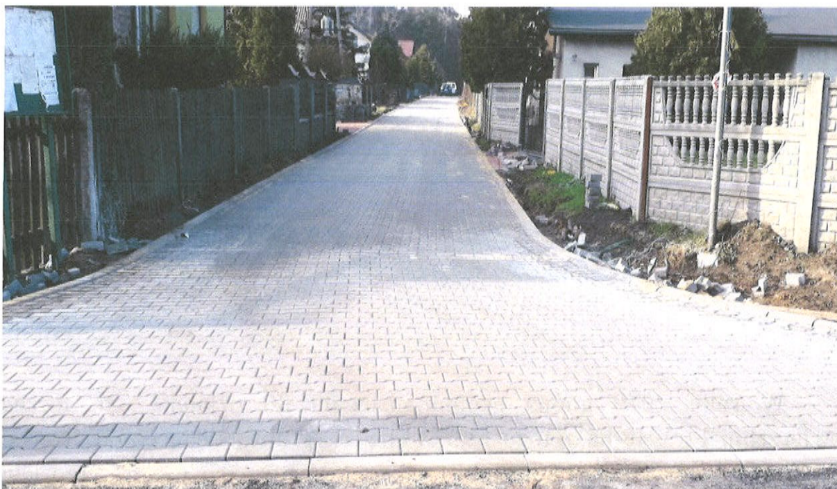
Ulica Słoneczna w Pietrzakach w trakcie modernizacji.
