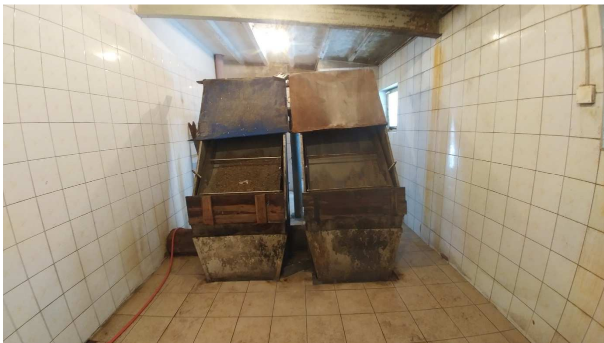
Fot. 2 Sita łukowe kpl. 2 o prześwicie 7,5mm - poz. 4 na schemacie technologicznym
