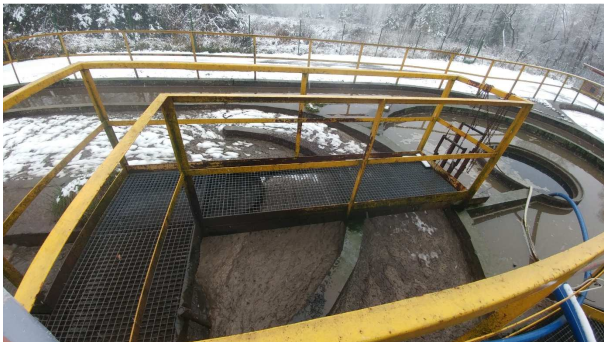
Fot. 9 Pomost do osadnika tlenowej stabilizacji osadów (poz.8 plan zagospodarowania)
