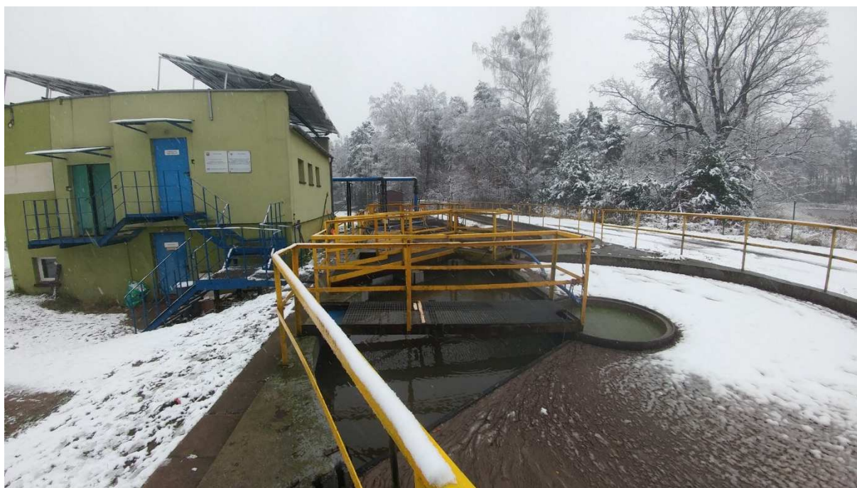
Fot. 7 Widok budynku na oczyszczalni z wejściem do hali sit łukowych, wejściem do części socjalnej oraz wejściem do budynku pompowni (pod schodami)
