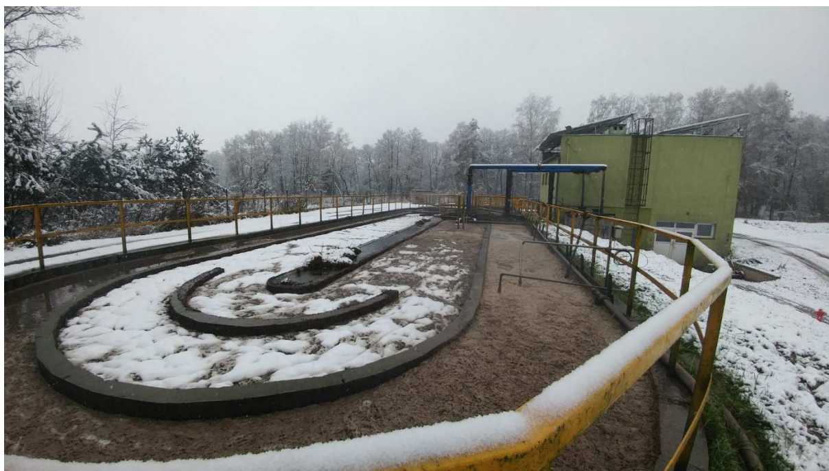
Fot. 10 Widok na komorę osadu czynnego I stopnia (poz.5 plan zagospodarowania) oraz na komorę stabilizacji tlenowej (poz. 7 plan zagospodarowania), powierzchnia rowu cyrkulacyjnego zaśnieżona
