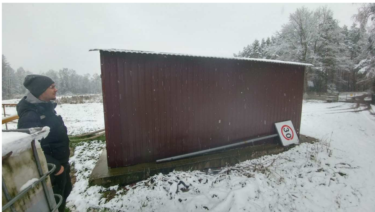
Fot. 11 Budynek stacji dmuchaw wraz z magazynem wapna
