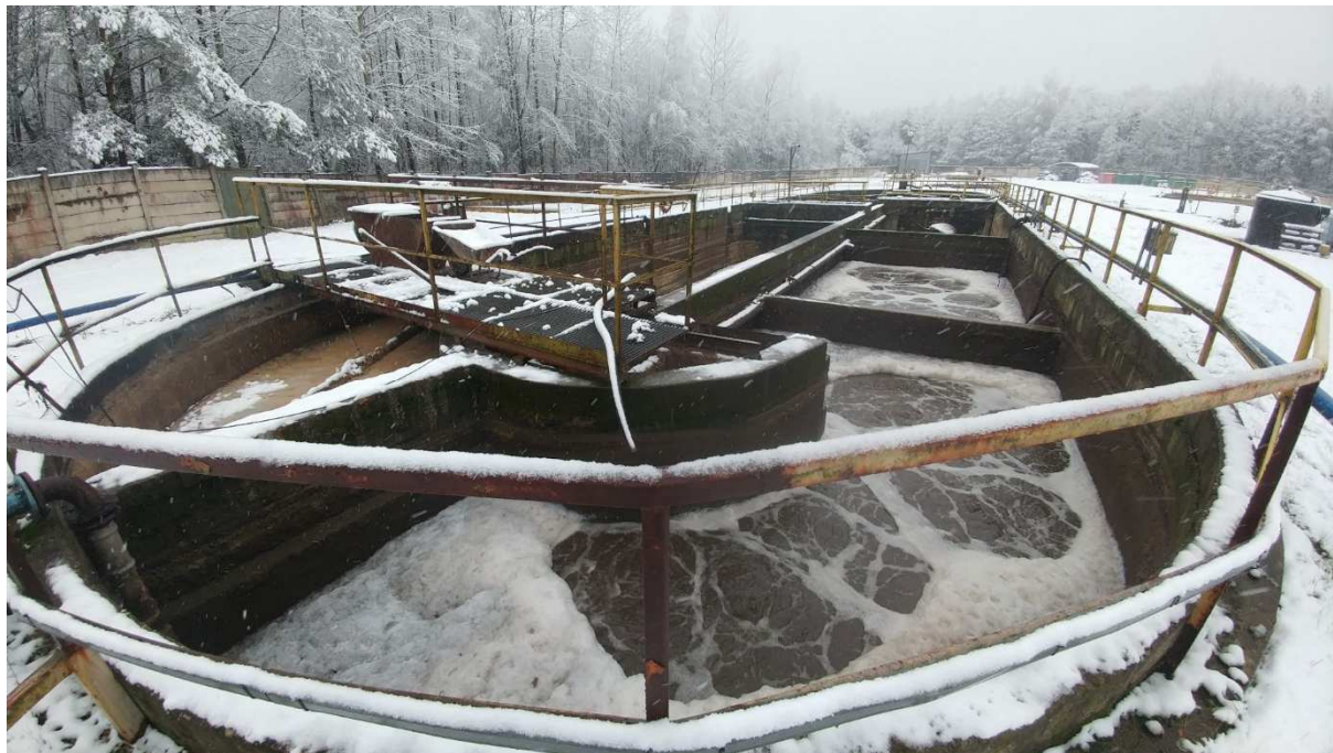
Fot. 1 Rów cyrkulacyjny (reaktor biologiczny) - widok na strefę nitryfikacji (poz.6b)
