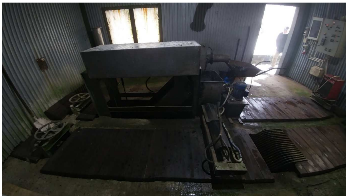
Fot. 5 Budynek krat, na pierwszym planie kanał obejściowy z kratą ręczną, w głębi krata mechaniczna schodkowa (poz.1)
