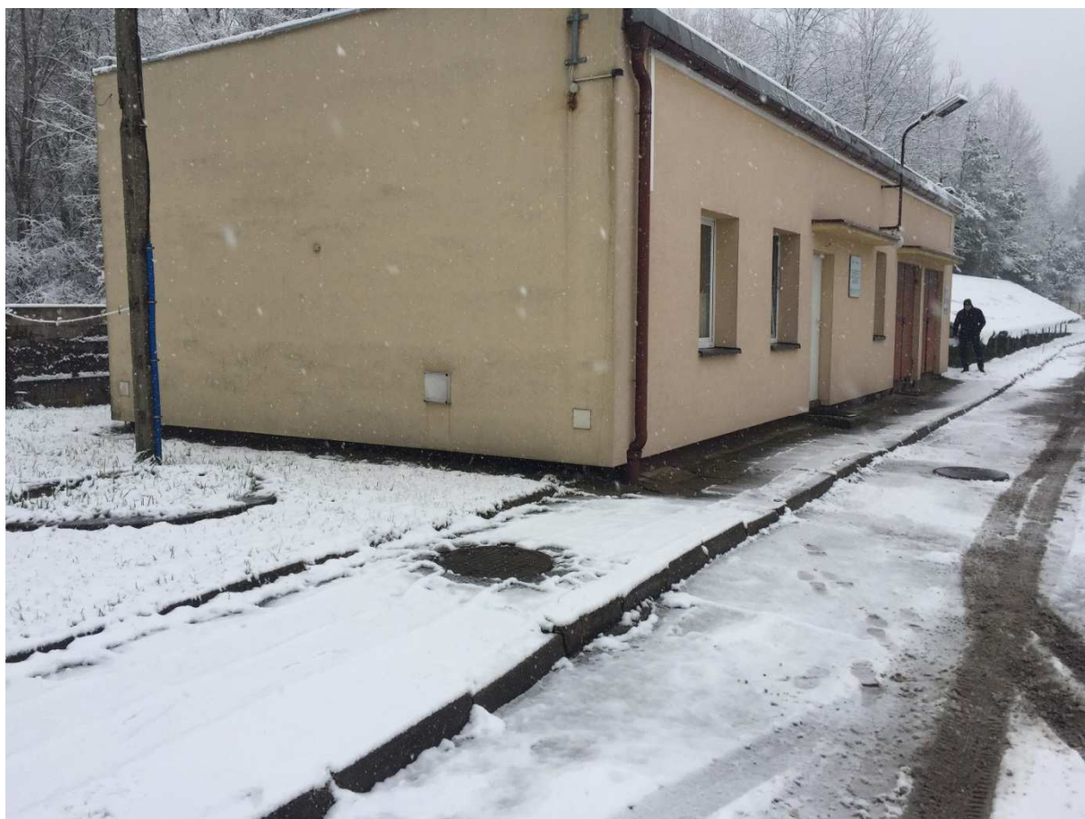
Fot. 13 Budynek socjalno-warsztatowy (poz.11)
