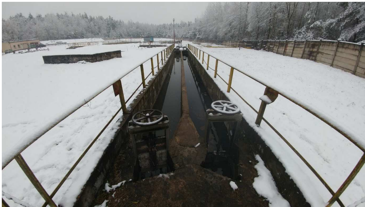
Fot. 3 Piaskownik o przepływie poziomym (poz.3)
