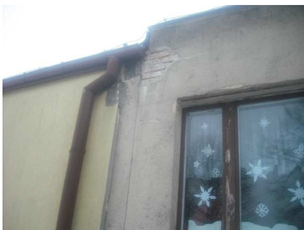
ZDJ. 5 Ściana nieocieplona
