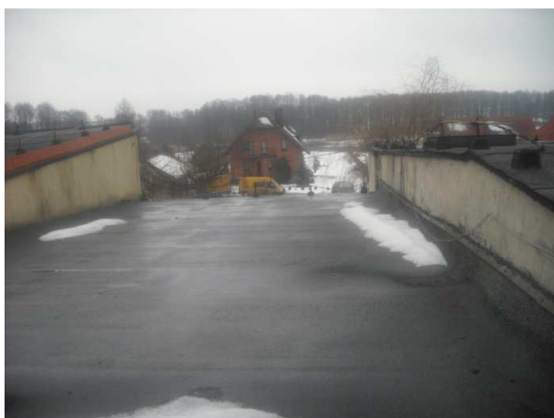
ZDJ. 3 Dach nad klatką schodową. Widoczna nieocieplona ściana segmentu przedszkola
