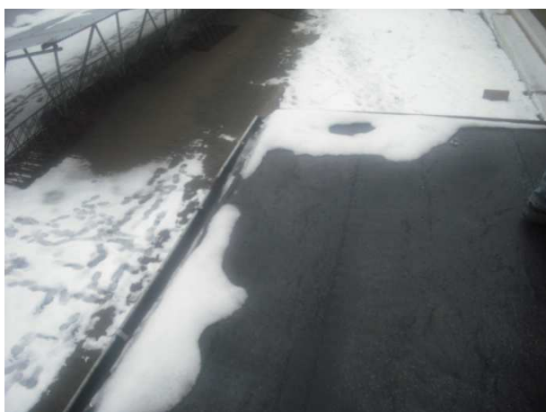
ZDJ. 1 Dach parterowej przebudówki
