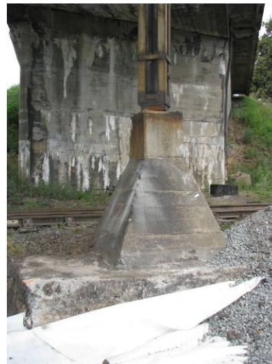
Rys.3.8. Widok na przyczółek oraz filar północny
