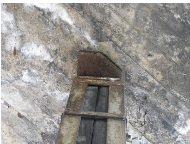
Rys.3.9. Głowica słupa oraz oparcie przęsła
