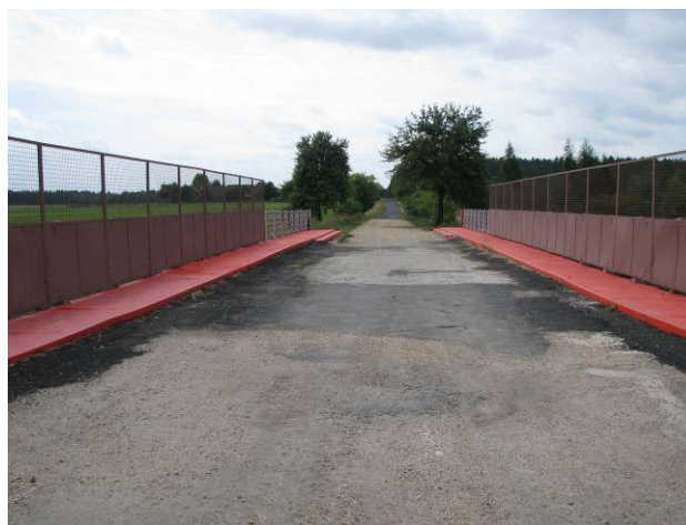
Rys.3.4. Dojazd do wiaduktu od strony Ameryki
