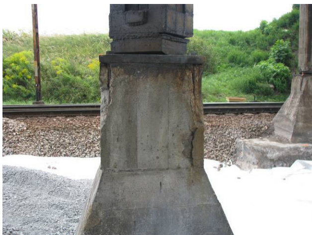
Rys.3.13. Oparcie słupa na bloku żelbetowym
