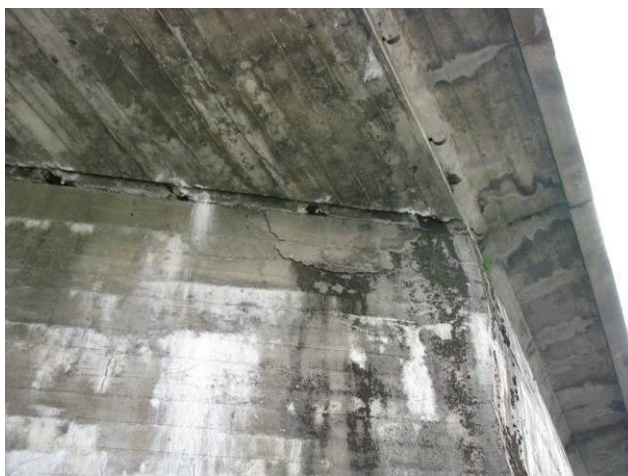
Rys.3.5. Widok na przyczółek i oparcie przęsła
