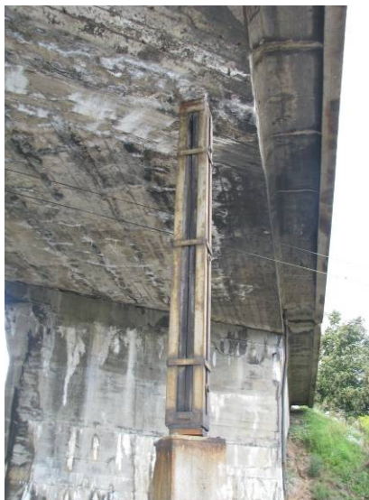
Rys.3.11. Filar północny i widok przęsła od spodu
