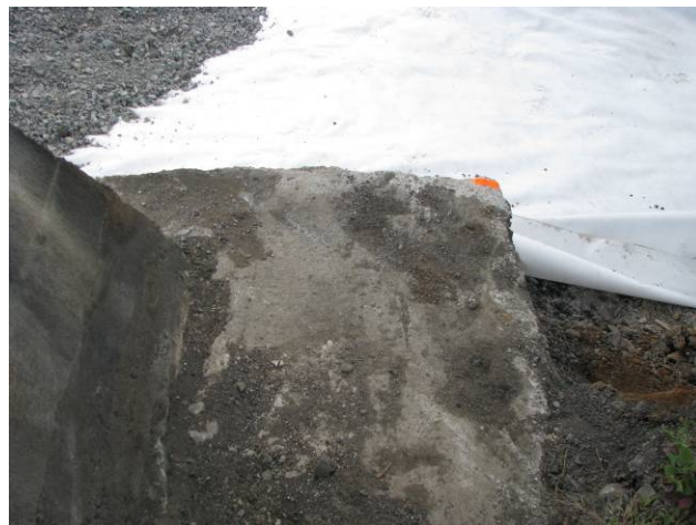
Rys.3.14. Widok na fundament słupów
