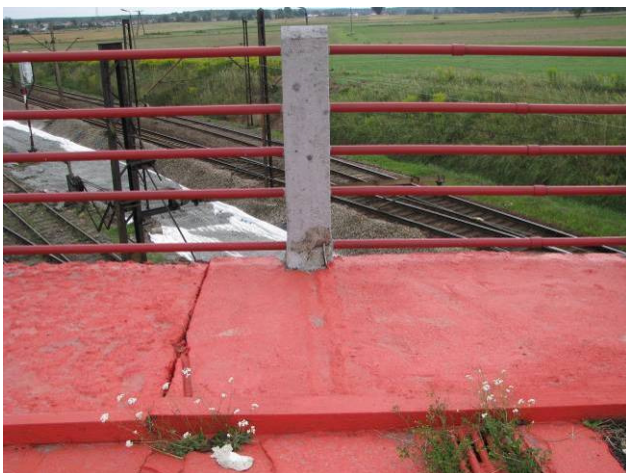
Rys.3.7. Konstrukcja balustrady i widok na chodnik.
