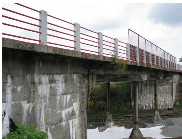
Rys.3.2. Widok wiaduktu od strony zachodniej
