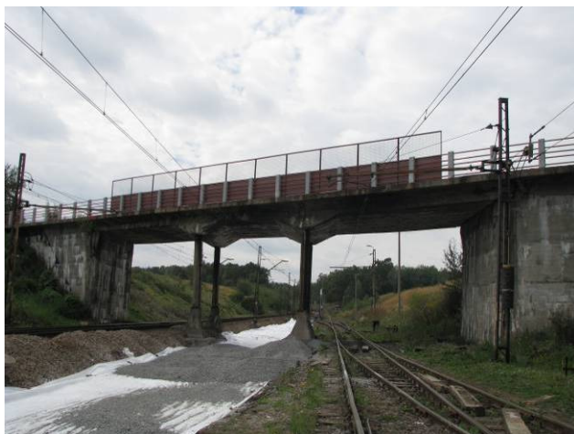
Rys.3.1. Widok wiaduktu od strony wschodniej
