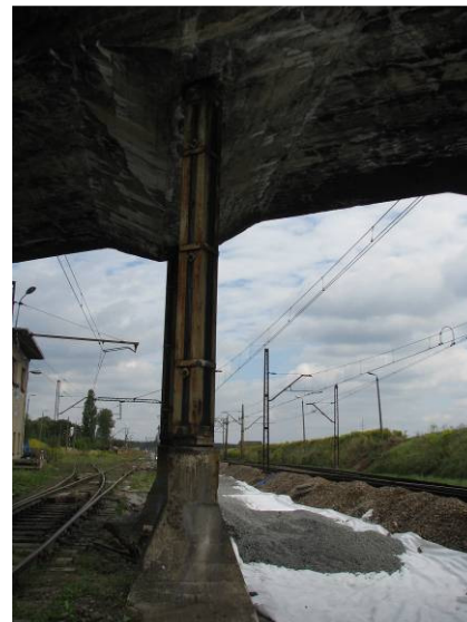
Rys.3.12. Widok na filar północny (remontowany)
