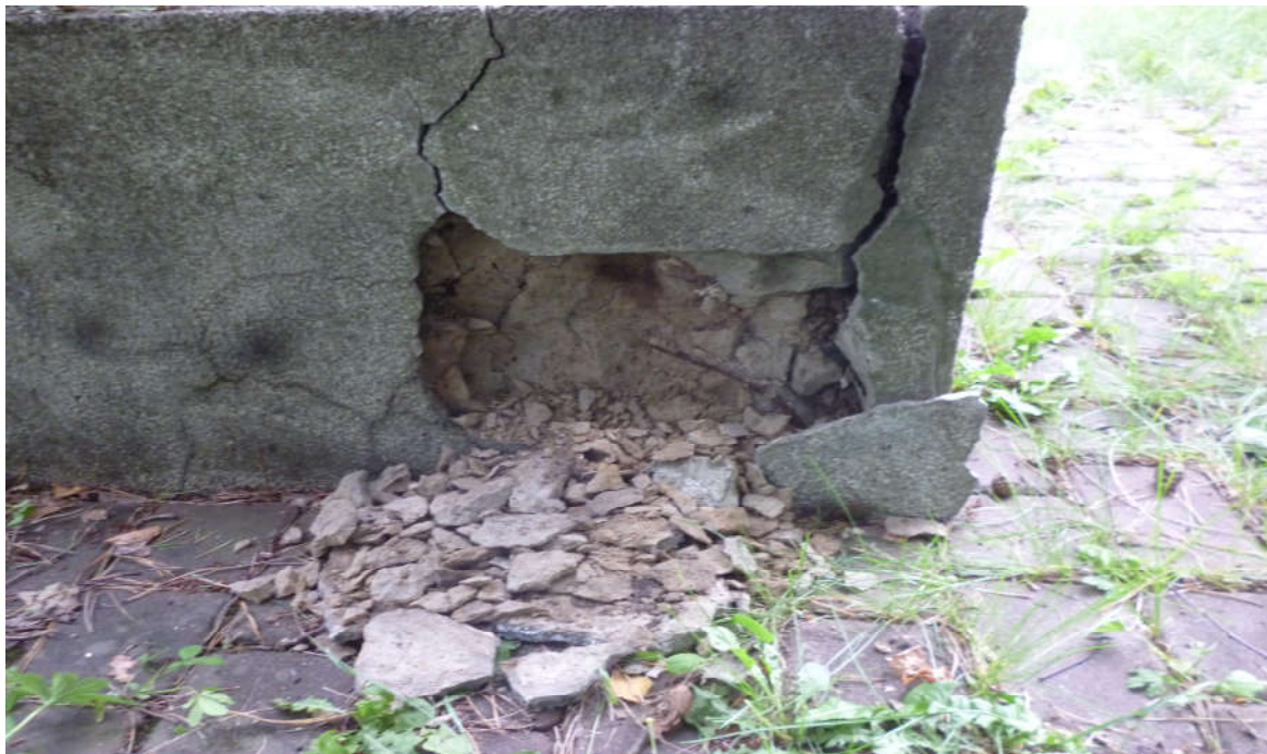
Fot.2 Spękania i ubytki cokołu
