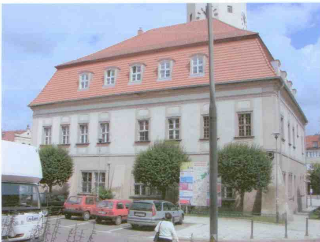
Zdjęcie nr 3: Elewacja południowa
