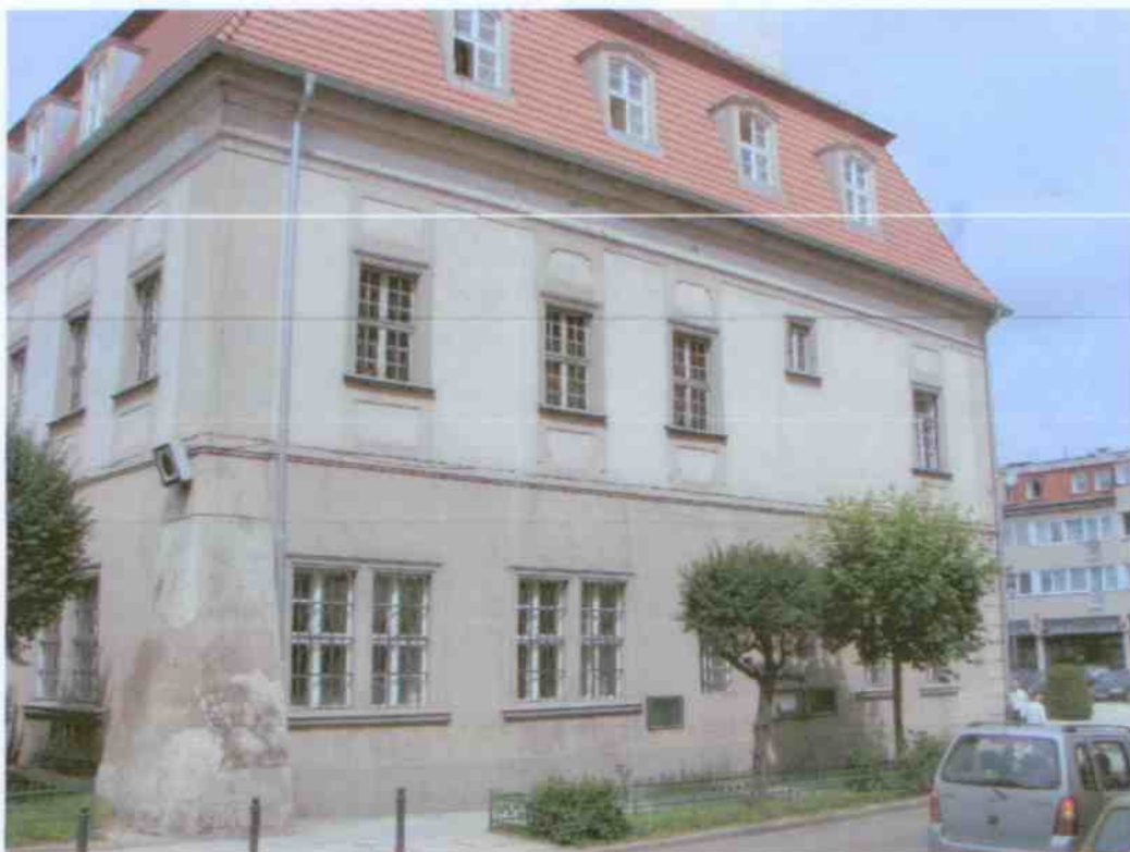
Zdjęcie nr 5: Elewacja wschodnia
