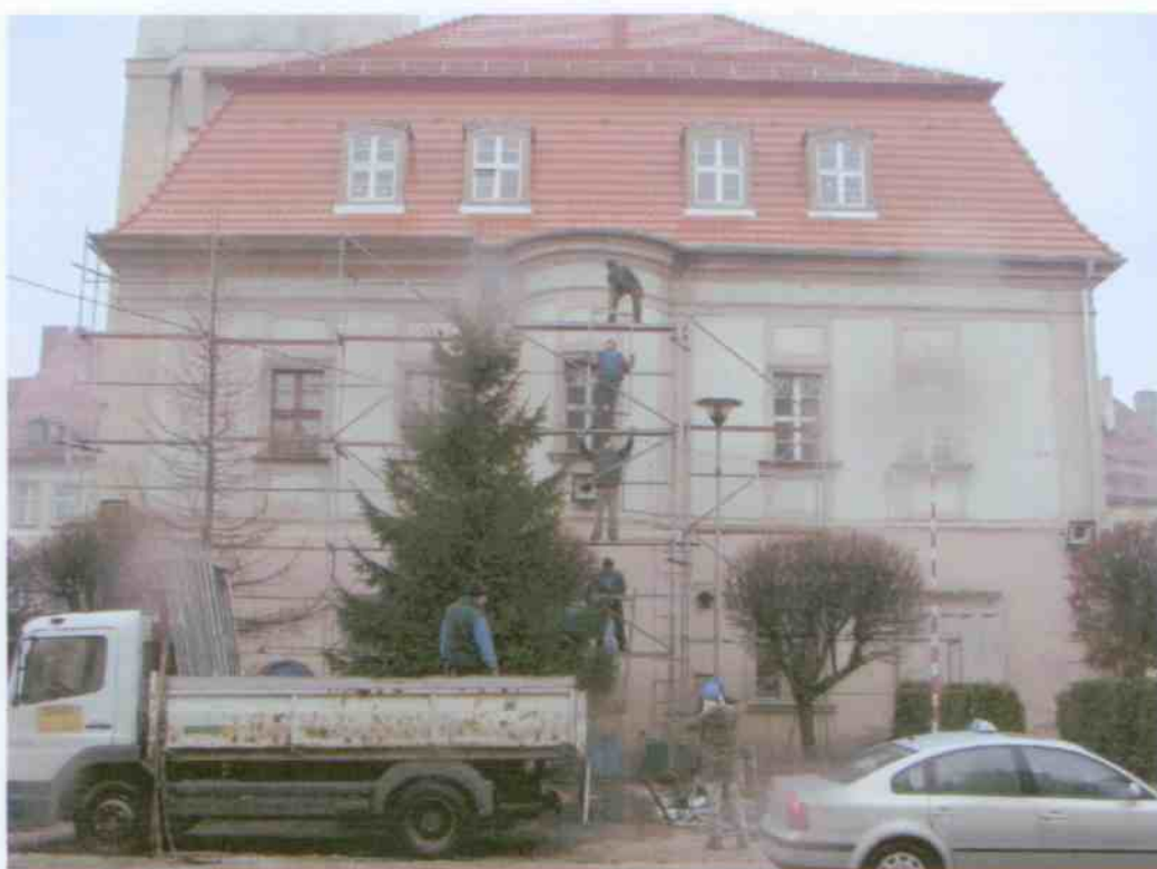
Zdjęcie nr 4: Elewacja zachodnia
