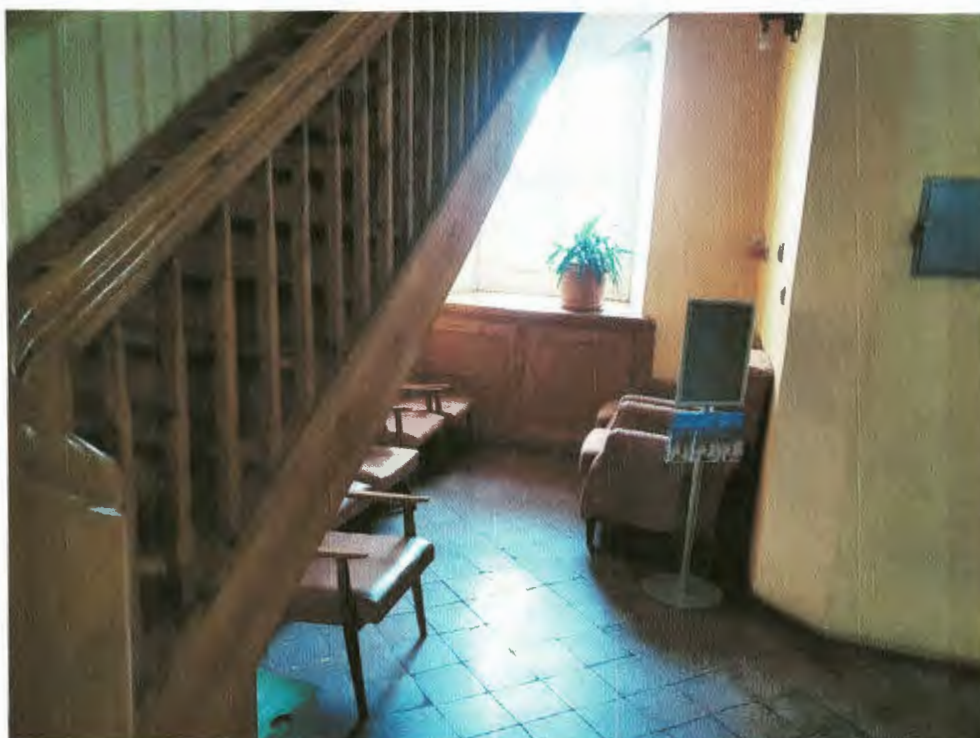
Fot.26. Klatka schodowa A – zejście z II piętra (bieg 1 – widok na okno przeznaczone do napowietrzania instalacji oddymiania – dolna połowa do napowietrzania)
