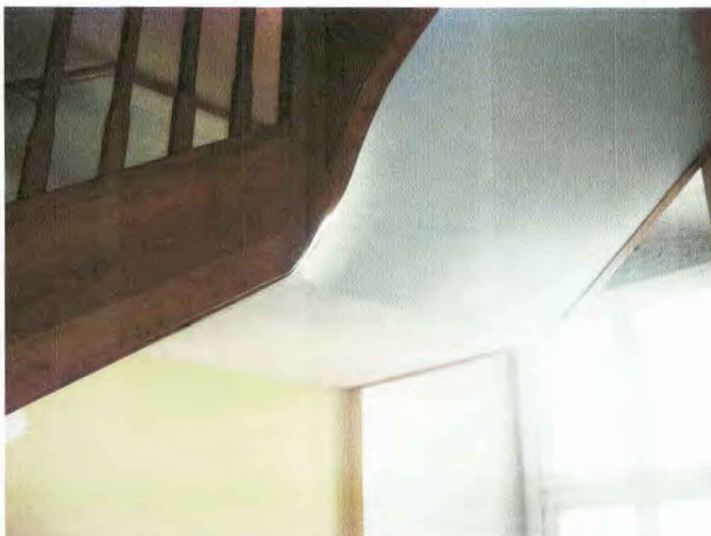
Fot.22. Klatka schodowa – widok biegu od spodu – od spodu klatka schodowa będzie zabezpieczona przegrodą w klasie odporności ogniowej EI60
