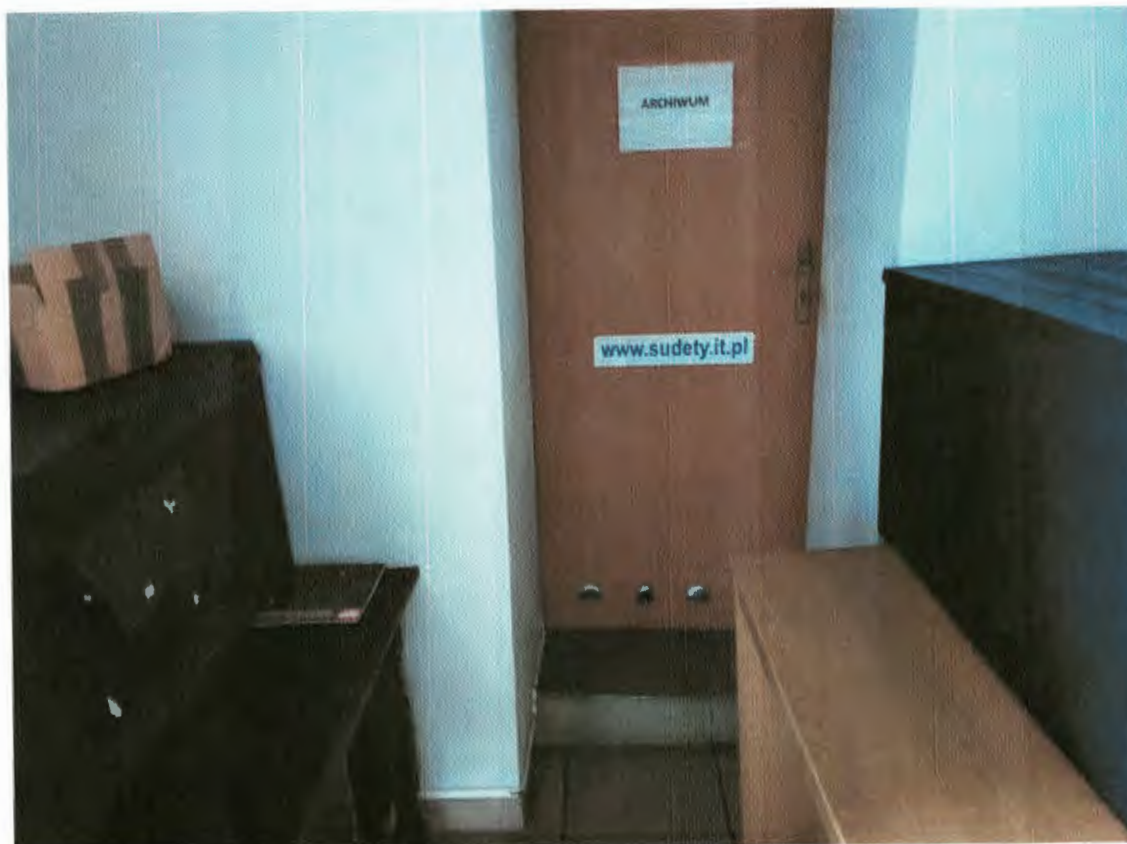
Fot.16. Drzwi wejściowe do archiwum bezklasowe (pom. nr 1.13) zostaną wymienione na przeciwpozarowe w klasie EI30
