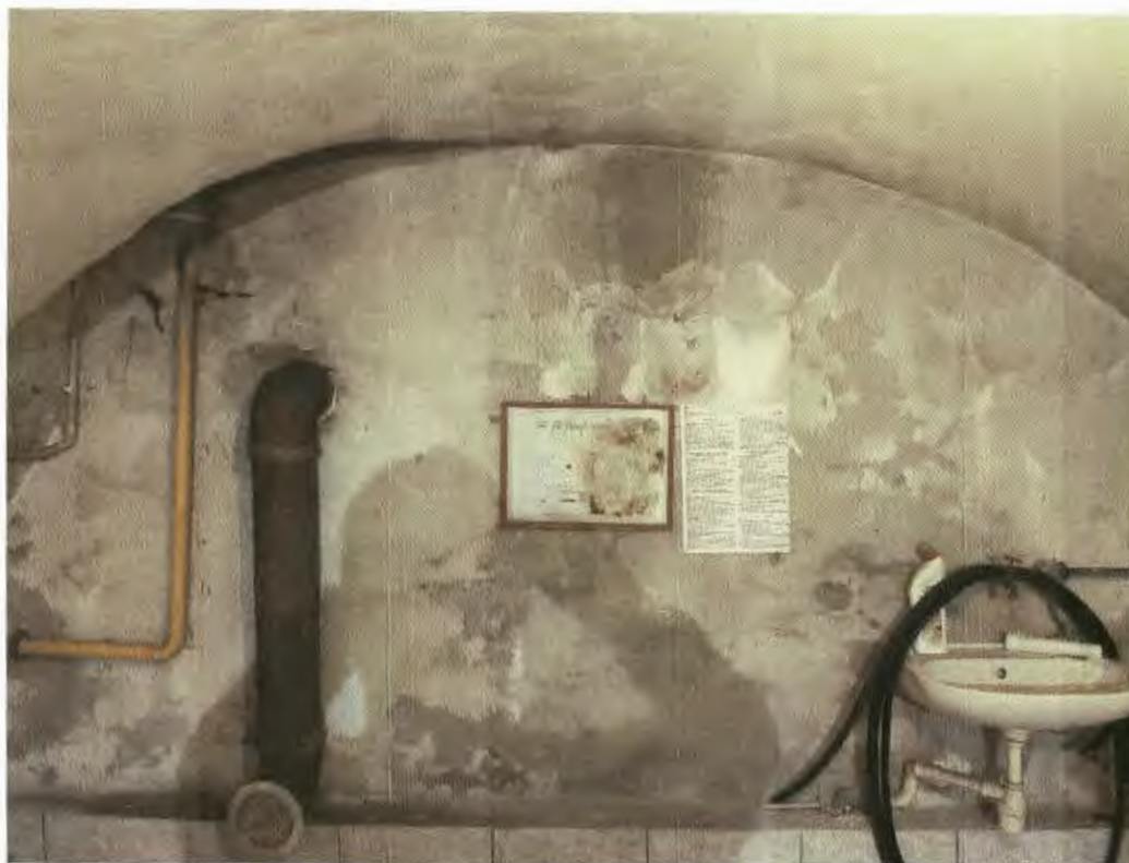
Fot. 7 Widok na ścianę zewnętrzną kotłowni – w ścianie wyprowadzony kanał wentylacji nawiewnej
