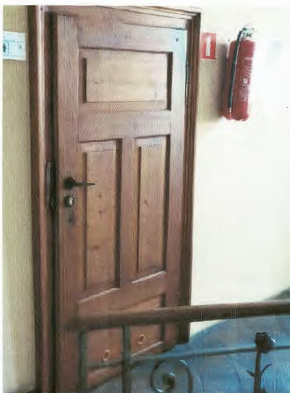
Fot.29. Drzwi bezklasowe do WC [2.15] o wymiarach 105/170 (zaniżenie wysokości o 15%) zostaną wyposażone w samozamykacz oraz uszczelki pęczniące
