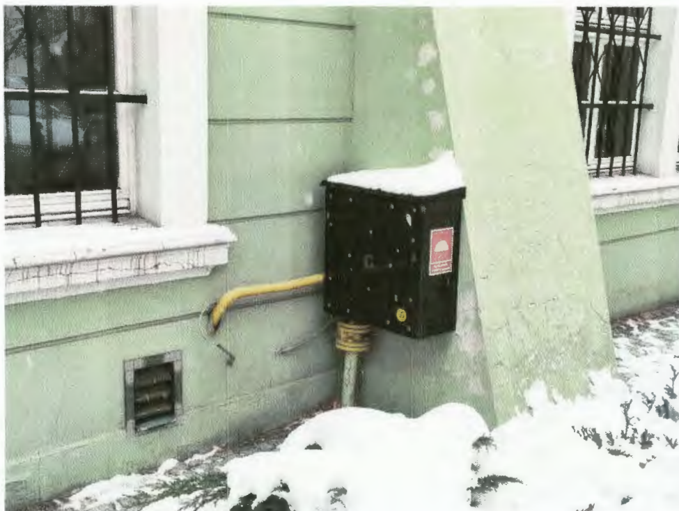
Fot. 8 Widok na ścianę zewnętrzną – elewacja południowa – w tle główny zawór gazowy i krata kanału wentylacji nawiewnej do kotłowni
