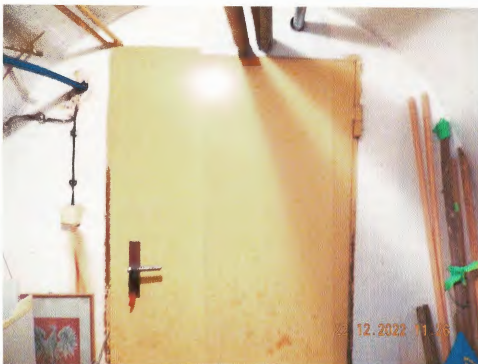
Fot. 9 Drzwi na przejściu w korytarzu do drugiej jego części [0.4] o wymiarach 91/197 cm (zaniżenie o 1,5%). Stanowi to również zaniżenie drogi ewakuacyjnej z piwnicy na długości 79,5 cm. Wysokość przejścia należy oznakować..
