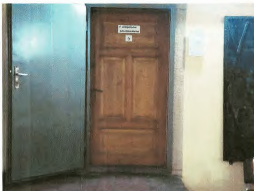
Fot.30. drzwi wejściowe bezklasowe do pom. 2.2 (przedsionek) zostaną wyposażone w samozamykacz oraz uszczelki pęczniące. Należy rozważyć ewentualną likwidację skrzydła zewnętrznego dla zachowania historycznej architektury holu
