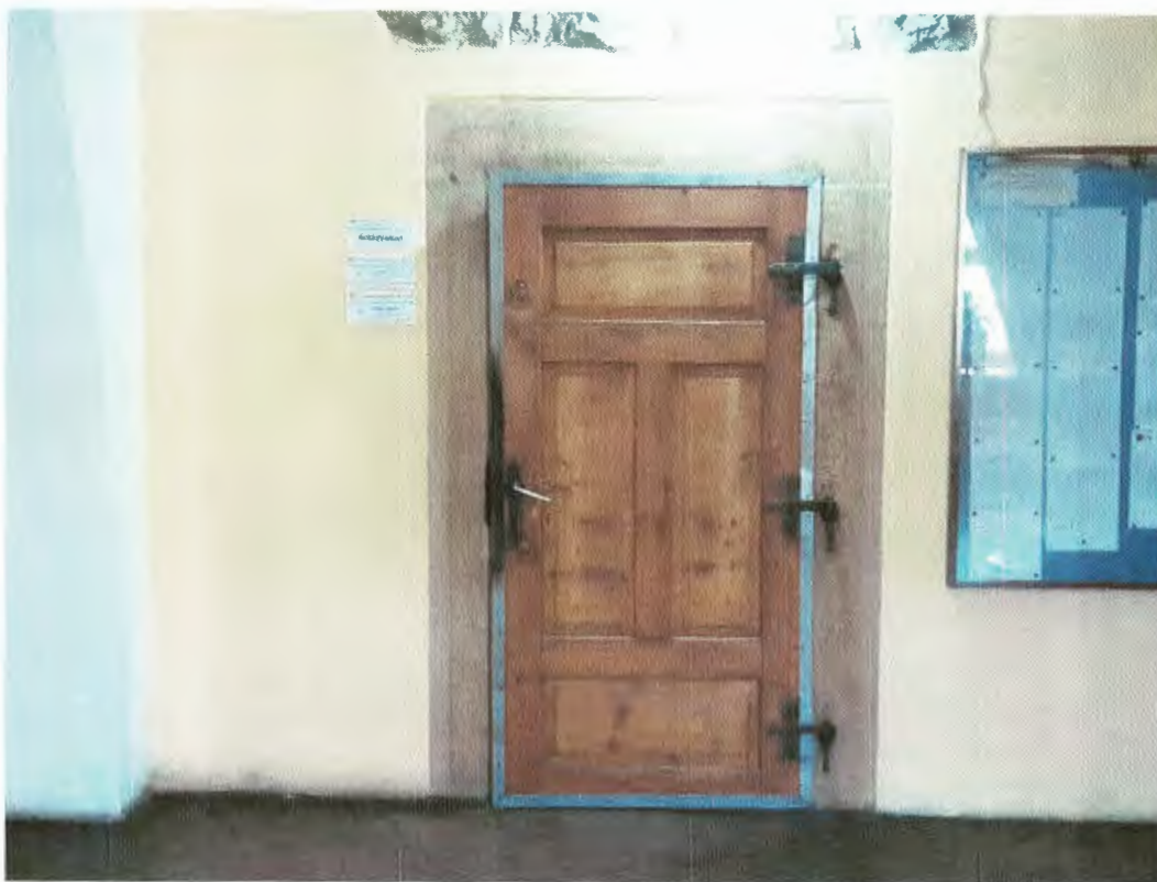
Fot.33. Drzwi wejściowe bezklasowe do pom. 2.9 (sekretariat) zostaną wyposażone w samozamykacz oraz uszczelki pęczniejące
