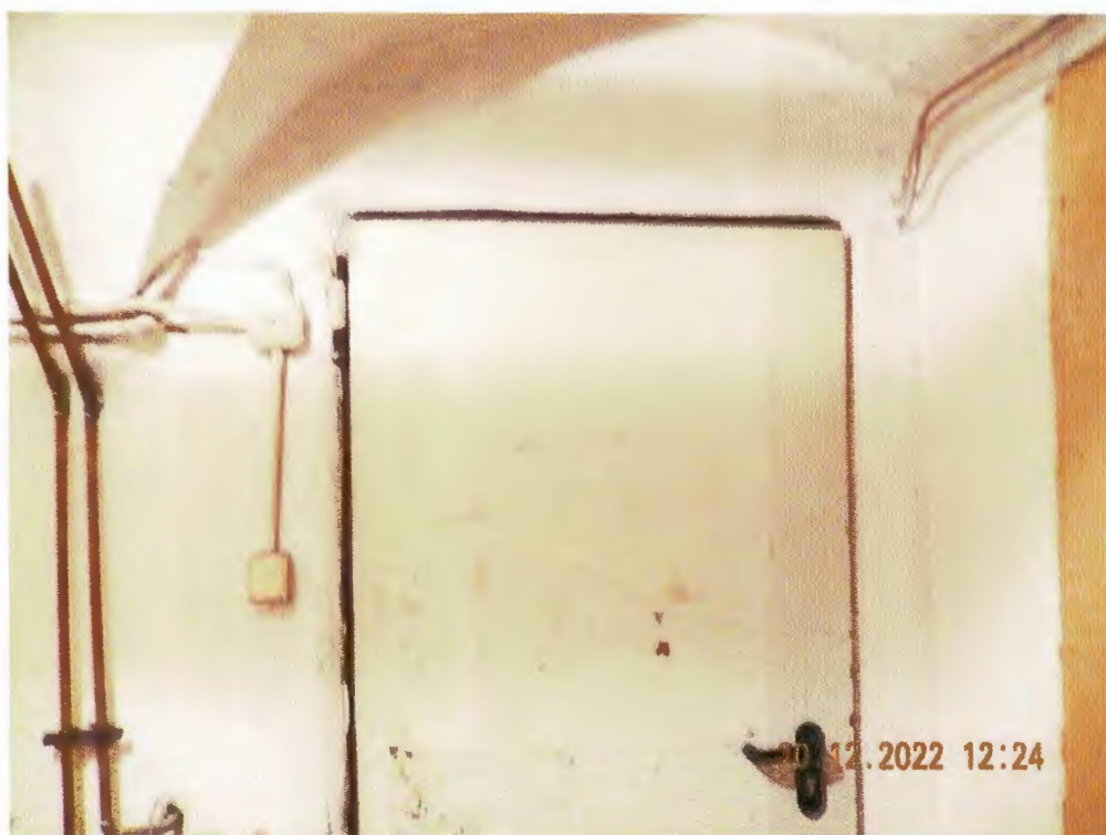
Fot. 4 Drzwi do magazynu (dawny magazyn oleju opałowego) [0.6] o wymiarach 91/197 cm (zaniżenie wysokości o 1,5%).
