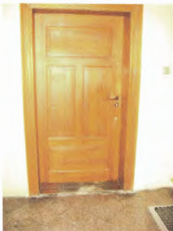
Fot. 35. Drzwi wejściowe bezklasowe do pom. i 2.13 (biurowe) zostaną poddane renowacji i wyposażone w samozamykacz i uszczelki pęczniące.
