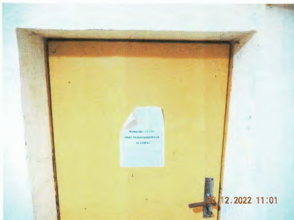
Fot.10 Drzwi do magazynu [0.5] materiałów przeciwpowodziowych o wymiarach 84/171 cm (zaniżenie o 14,5%)
