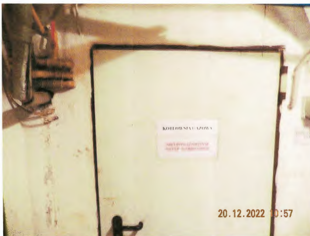
Fot. 5 Drzwi do kotłowni gazowej [0.2] o wymiarach 91/188 cm (zaniżenie wysokości o 6%)
