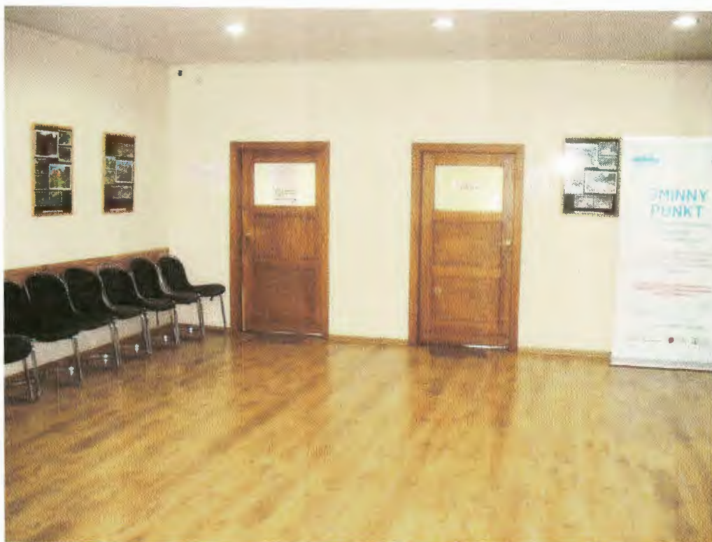
Fot.39. Drzwi wejściowe bezklasowe do pom. 3.11 i 3.12 zostaną wymienione na przeciwpożarowe w klasie EIS30
