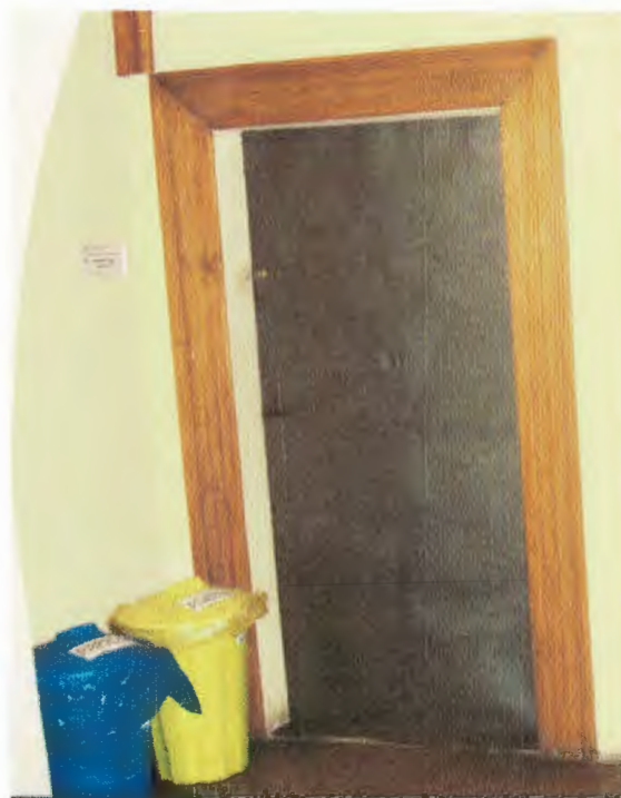
Fot.34. Drzwi wejściowe bezklasowe do pom. 2.12 (gospodarcze) do likwidacji i odtworzenia w stylu pozostałych drzwi zabytkowych zamykających pomieszczenia i wyposażeniu ich w samozamykacz i uszczelki pęczniejące.
