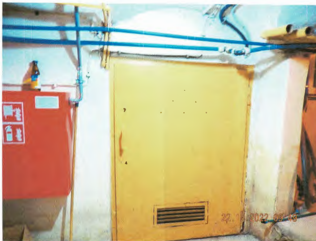
Fot. 11 Drzwi do archiwum [0.3] o wymiarach 120/161 cm (zaniżenie o 19,5%);
