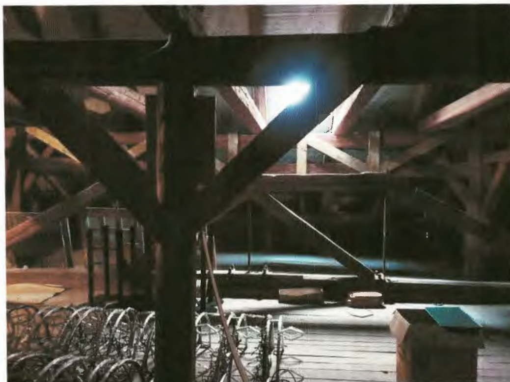
Fot. 44 Konstrukcja wsporcza dachu
