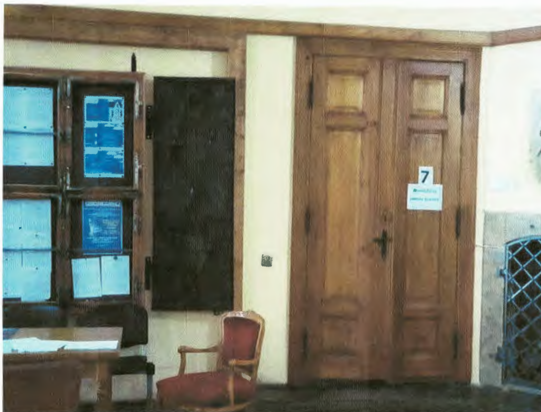
Fot.31. Drzwi wejściowe bezklasowe do pom. 2.7 (przedsiónek sali narad 2.8) zostaną wyposażone w samozamykacz oraz uszczelki pęczniące
