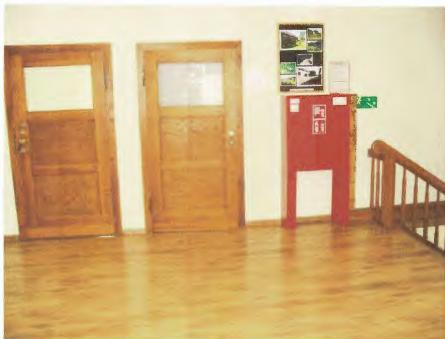
Fot. 41. Drzwi wejściowe bezklasowe do pomieszczeń 3.17 i 3.19 – zostaną wymienione na przeciwpożarowe w klasie EIS30
