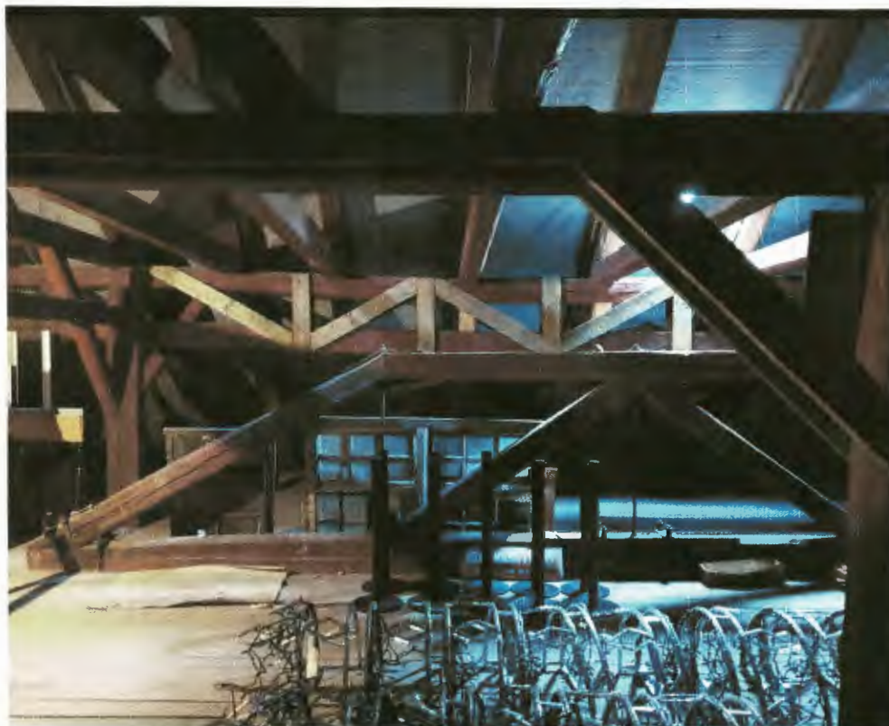
Fot. 46 Konstrukcja wsporcza dachu
