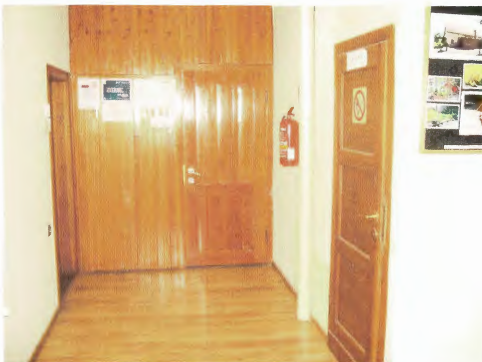
Fot.40. Drzwi wejściowe bezklasowe do pomieszczeń (od lewej strony) 3.13, 3.16 i na strych – zostaną wymienione na przeciwpożarowe w klasie EIS30 – boazeria zlikwidowana
