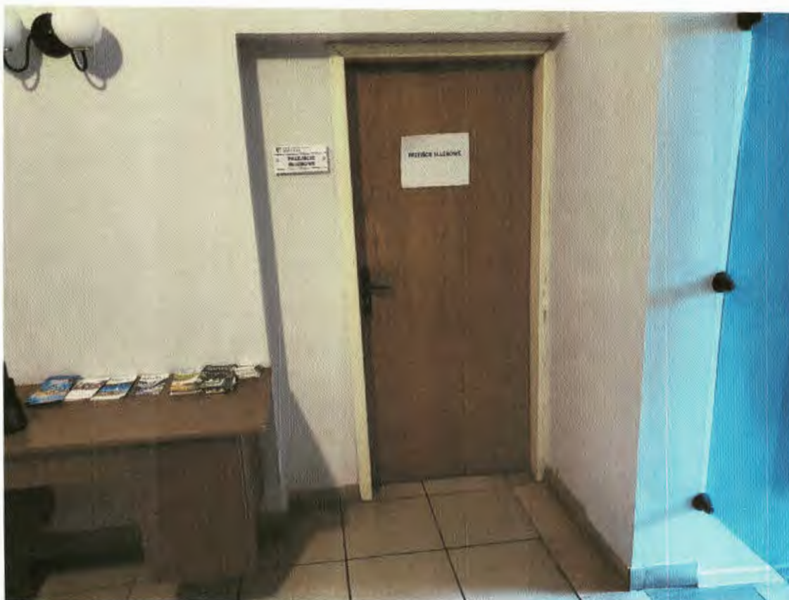
Fot.19. Drzwi prowadzące na schody komunikacyjne do przejścia służbowego bezklasowe zostaną wymienione na przeciwpożarowe w klasie EI30
