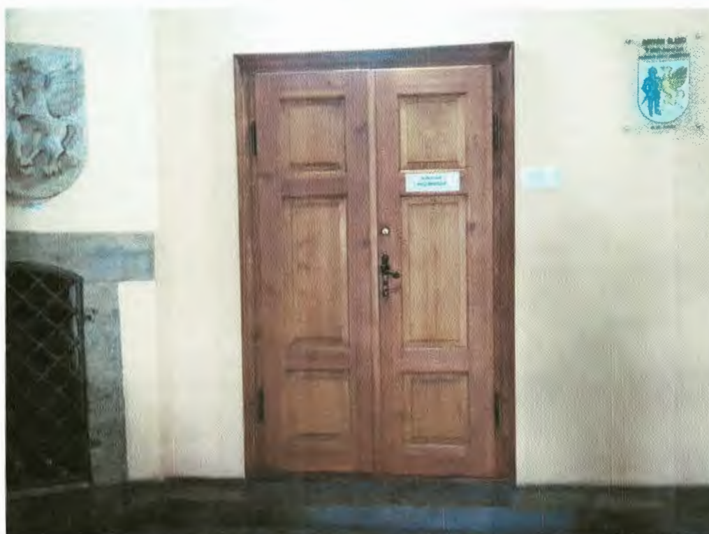
Fot.32. Drzwi wejściowe bezklasowe do pom. 2.9 (Gabinet Burmistrza) zostaną wyposażone w samozamykacz oraz uszczelki pęczniące
