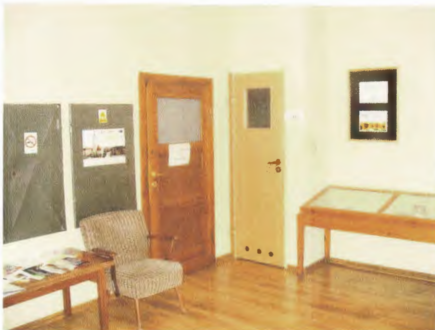
Fot.37. Drzwi wejściowe bezklasowe na wieżę oraz do WC. Drzwi wejściowe na wieżę zostaną wymienione na przeciwpożarowe w klasie EI60 jako jednocześnie zamknięcie strefy pożarowej – drzwi do WC zostaną wymienione na bezklasowe i wyposażone w uszczelki pęczniące i samozamykacz
