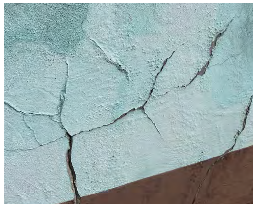
Pęknięcia ścian
