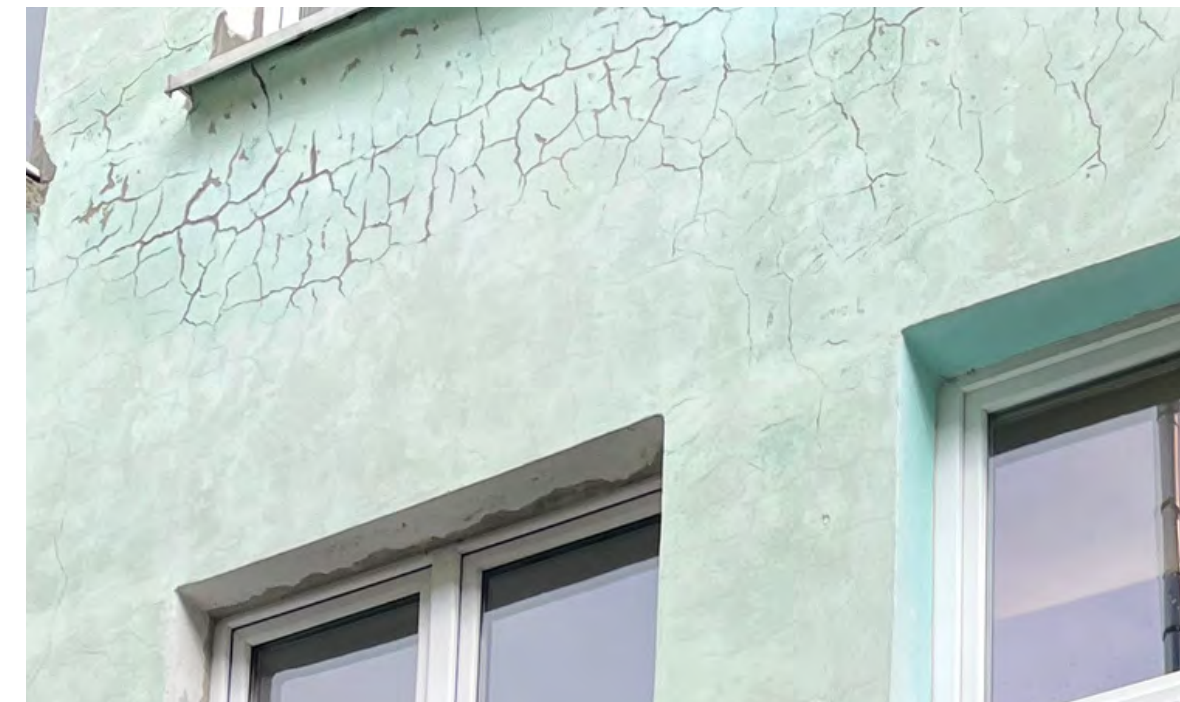
Zawilgocenia ścian
