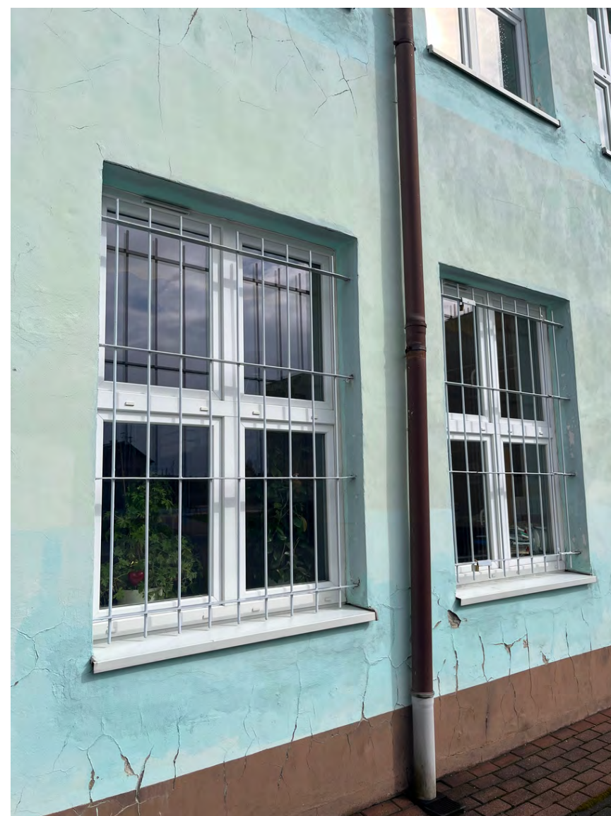
Kraty w oknach do usunięcia
