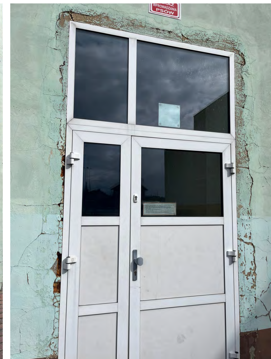
Drzwi wejściowe od strony boiska
