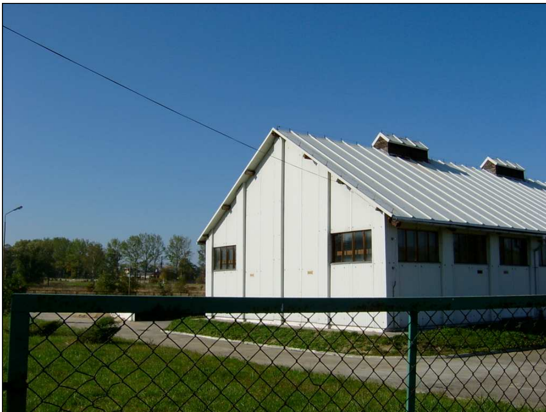
Rys. 3.1. Oczyszczalnia ścieków w Gryfowie Śląskim
