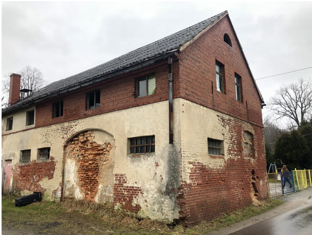
Fot. nr 1: Elewacja boczna i frontowa – od strony południowo zachodniej
