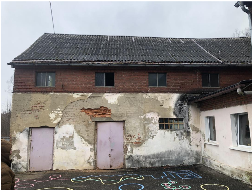
Fot. nr 2: Elewacja boczna – od strony wschodniej
