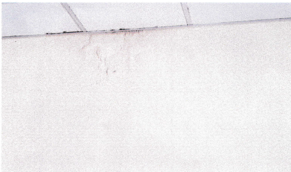
Ilustracja 1: Zalany sufit, przejście piętrem
