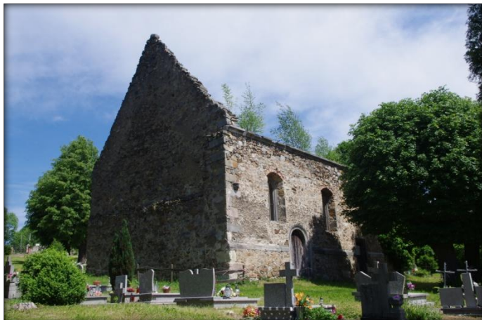
Ruiny dawnego kościoła katolickiego
