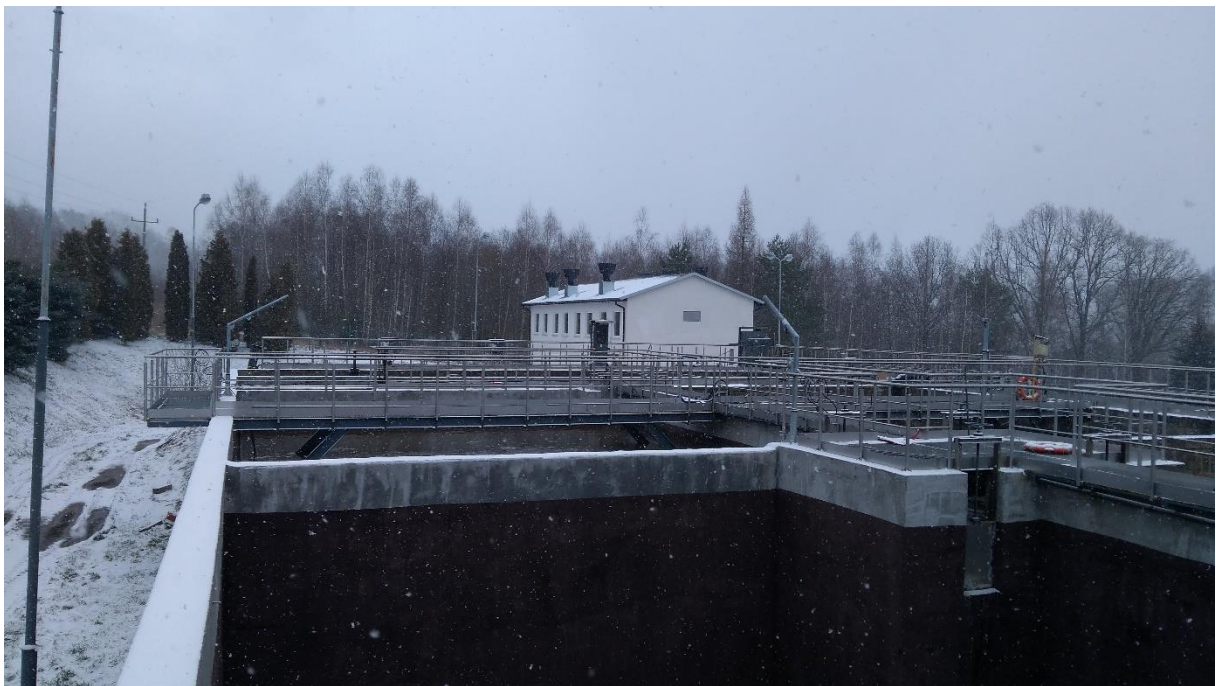
Reaktor biologiczny z nowym budynkiem sitopiaskownika.
