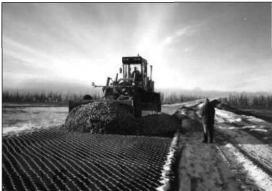
Rys. 8. Zasypywanie kruszywem komórek geosiatki za pomocą ładowarki
