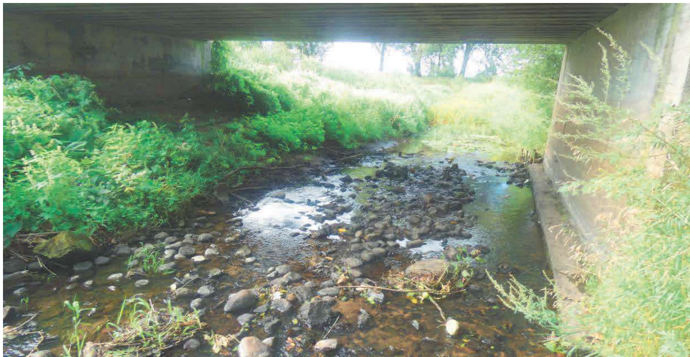
Fot. 6 Widok przestrzeni podmostowej
