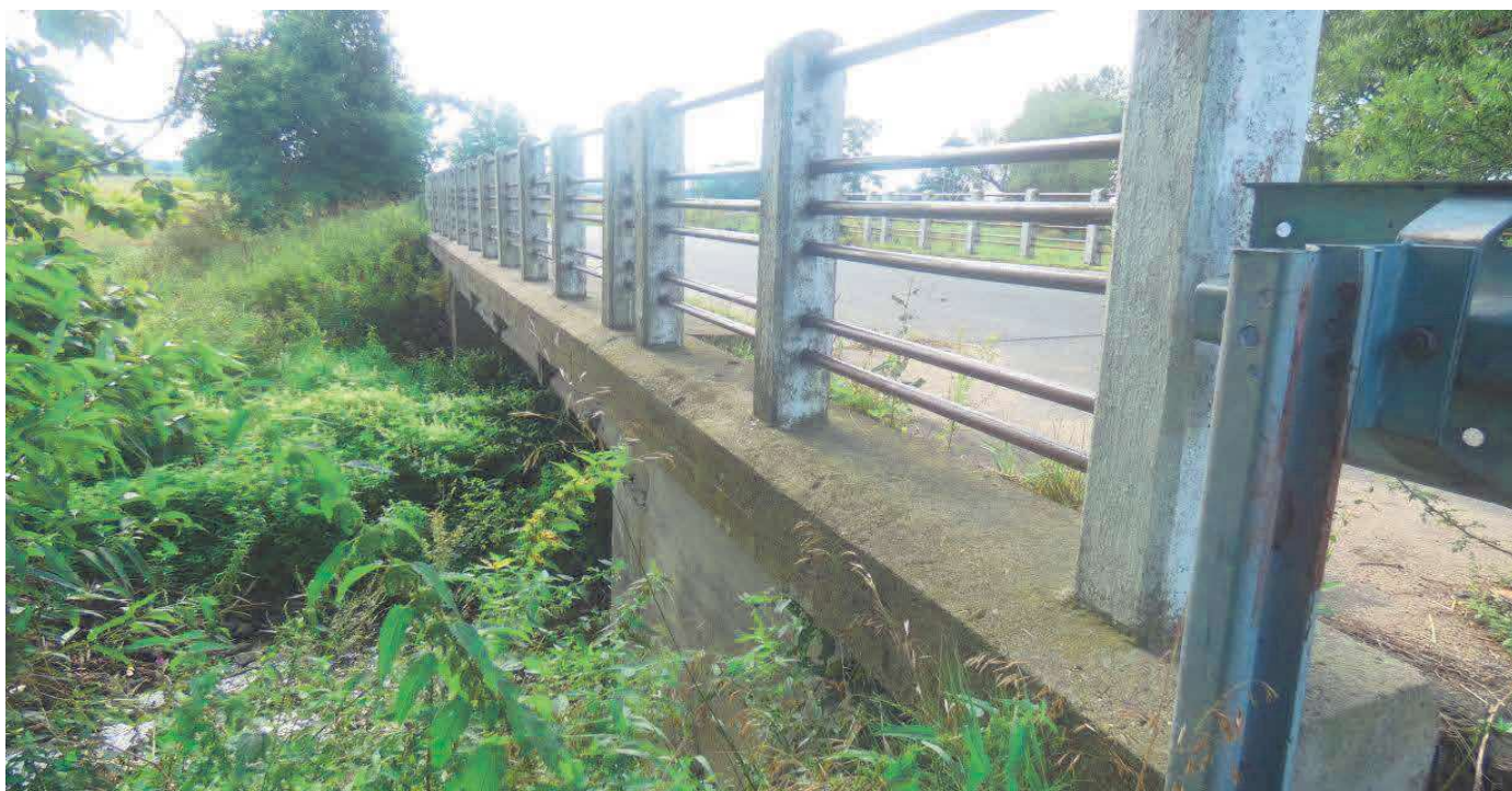
Fot. 3 Widok mostu z boku
