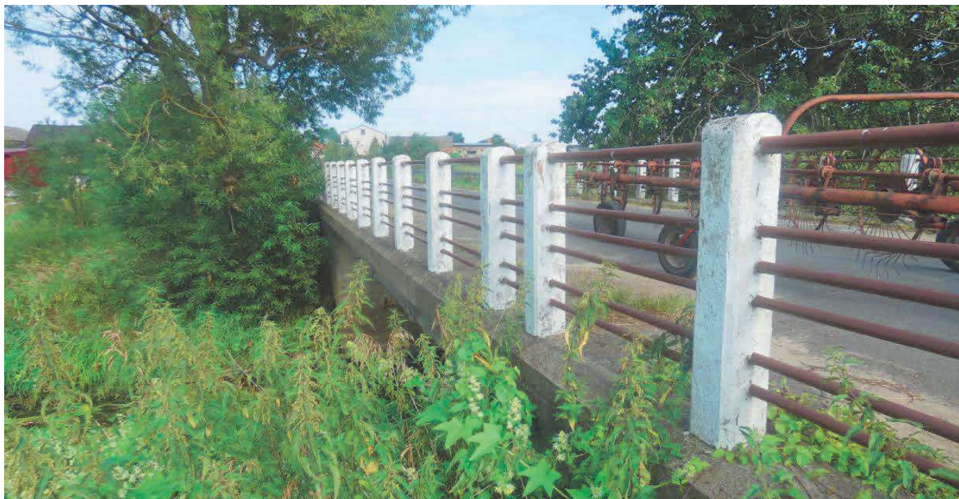
Fot. 4 Widok mostu z boku
