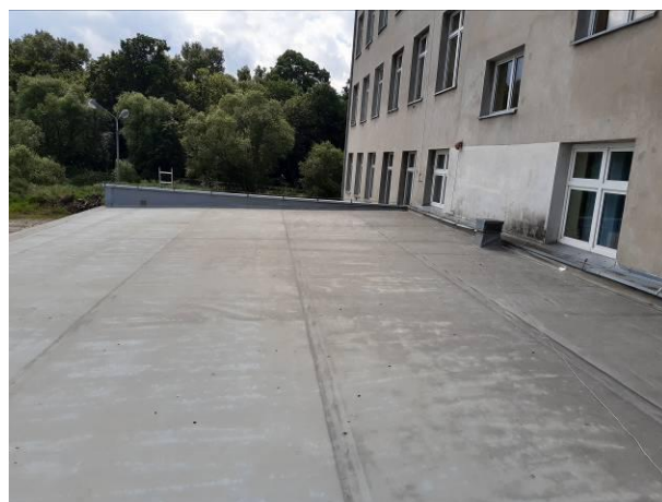
dach łącznika – część południowa
