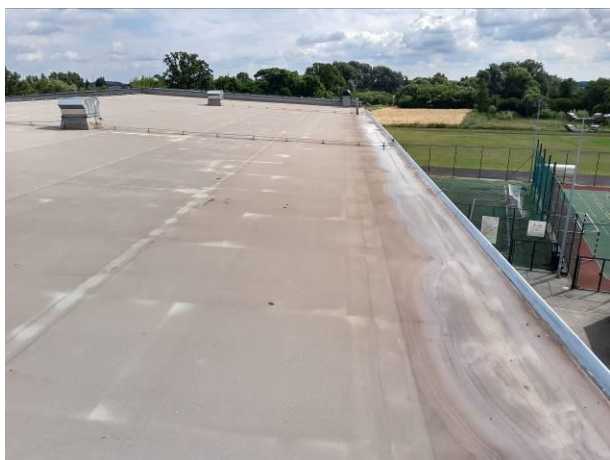
dach hali sportowej – połąć południowa
