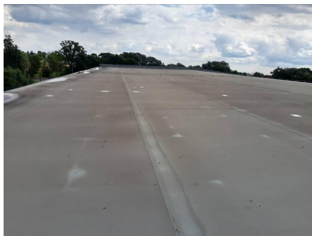
dach hali sportowej – połąć północna
