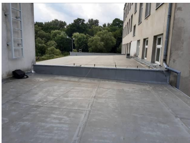
dach łącznika – część północna
