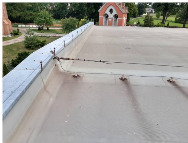
dach hali sportowej – ścianka attykowa
