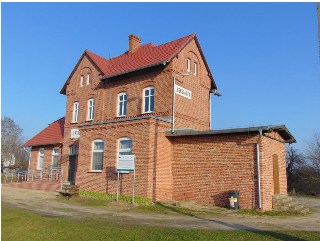
Ryc. 43. Odnowiony dworzec kolejowy w Laskownicy Małej, fot. J. Linetty (2024).
