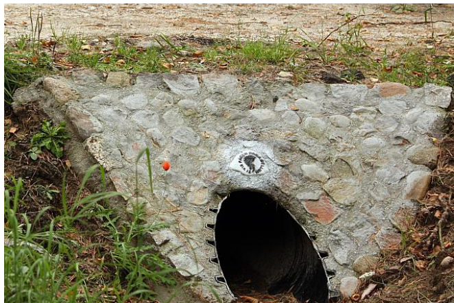
Rys. 8. Przykład umocnienia skarpy przy wlocie i wylocie za pomocą kamienia polnego na zaprawie betonowej.
