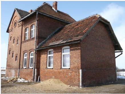
2) Budynek byłej stacji PKP- świetlica wiejska
