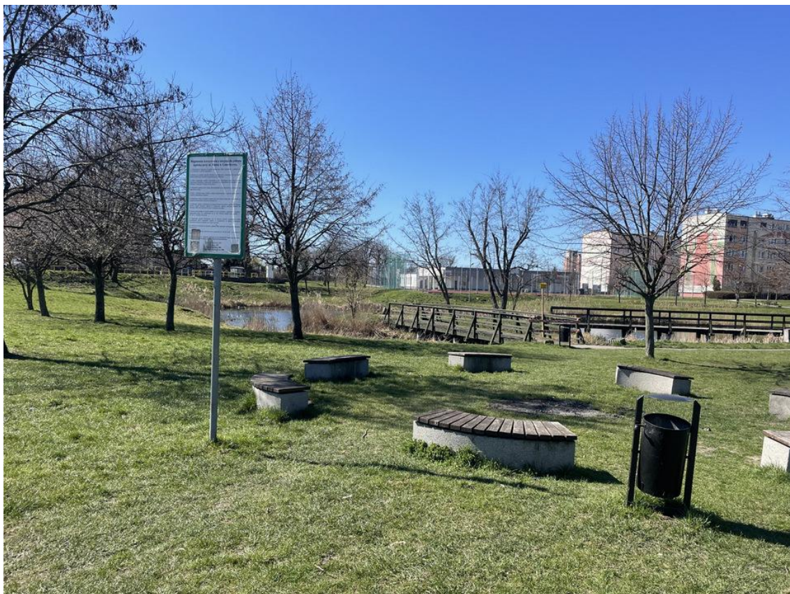
Fot.7. Modernizacja miejsca grillowego.
