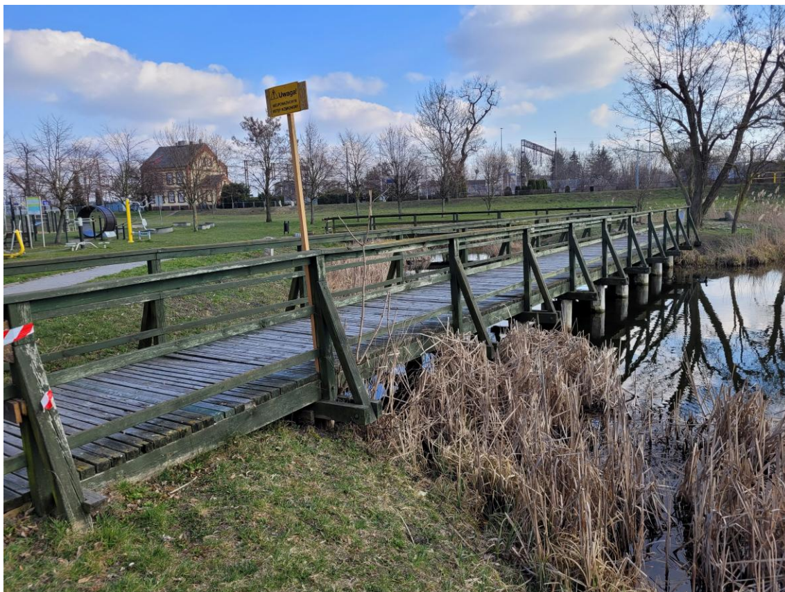
Fot. 8. Miejsce po starym pomoście, gdzie będzie zamontowany nowy.
