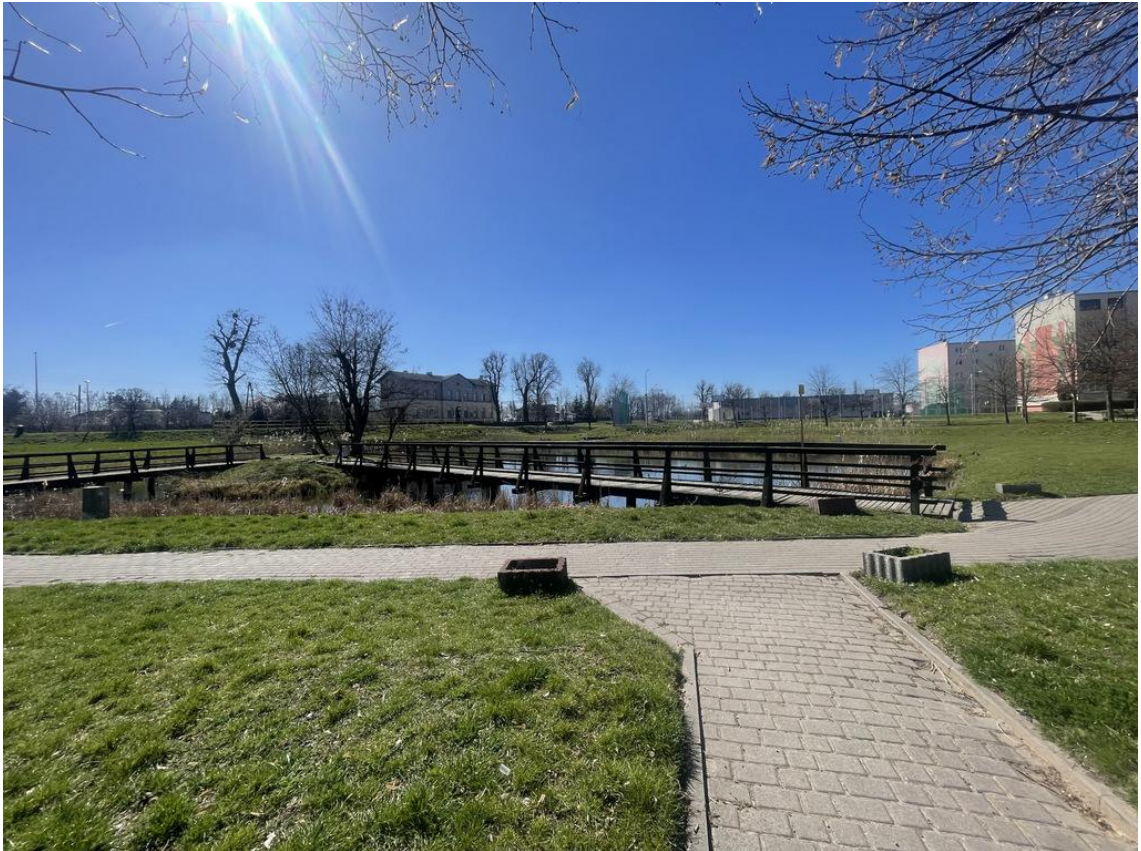
Fot.3. Dwa pomosty podlegające rozbiórce.
