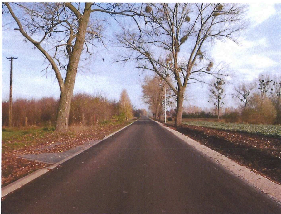
Zdjęcie 5 Przebudowa ul. Cegielnej w Gniewkowie
