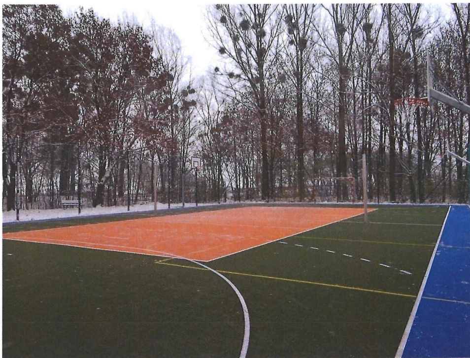
Zdjęcie 10 Boisko wielofunkcyjne w Lipiu
