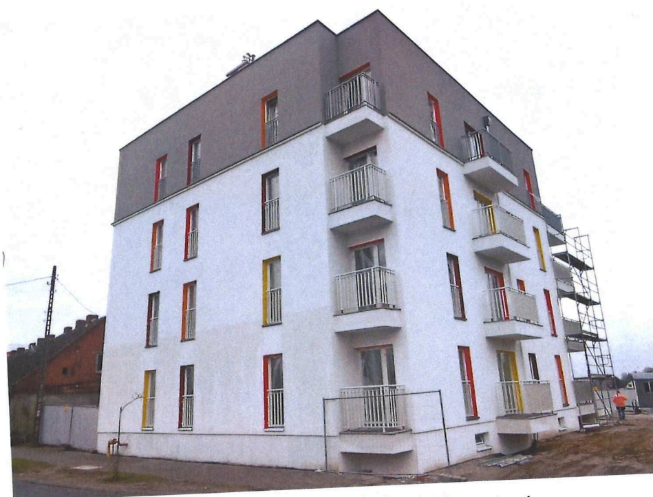
Zdjęcie 15 Budowa bloku komunalnego w Gniewkowie
