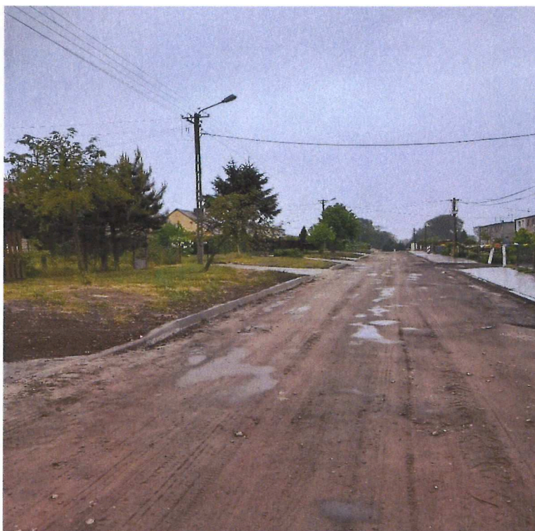
Zdjęcie 1 Przebudowa drogi gminnej w Lipiu
