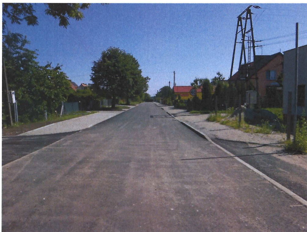
Zdjęcie 2 Przebudowa drogi gminnej w Lipiu
