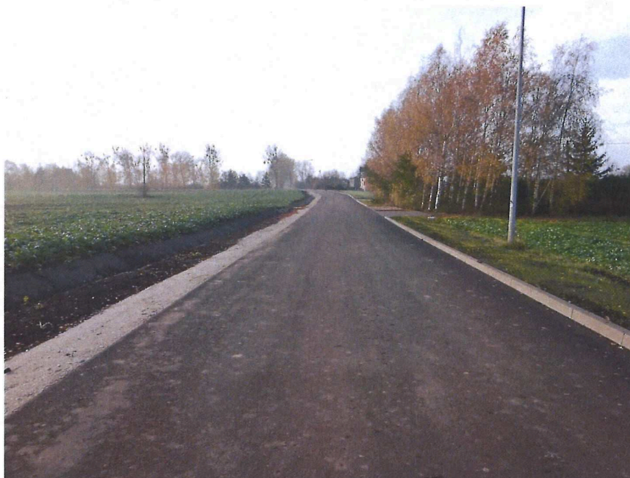
Zdjęcie 4 Przebudowa ul. Cegielnej w Gniewkowie
