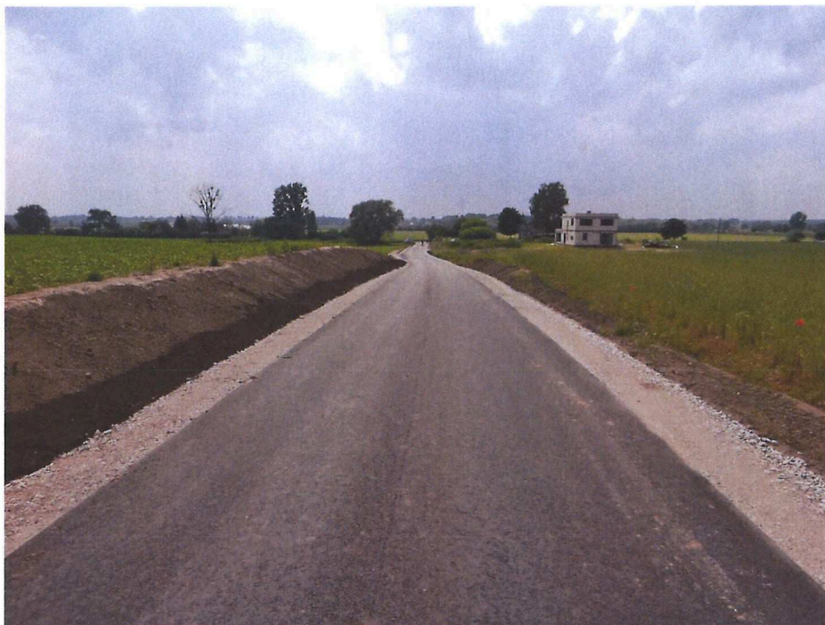
Zdjęcie 3 Przebudowa drogi w Suchatówce
