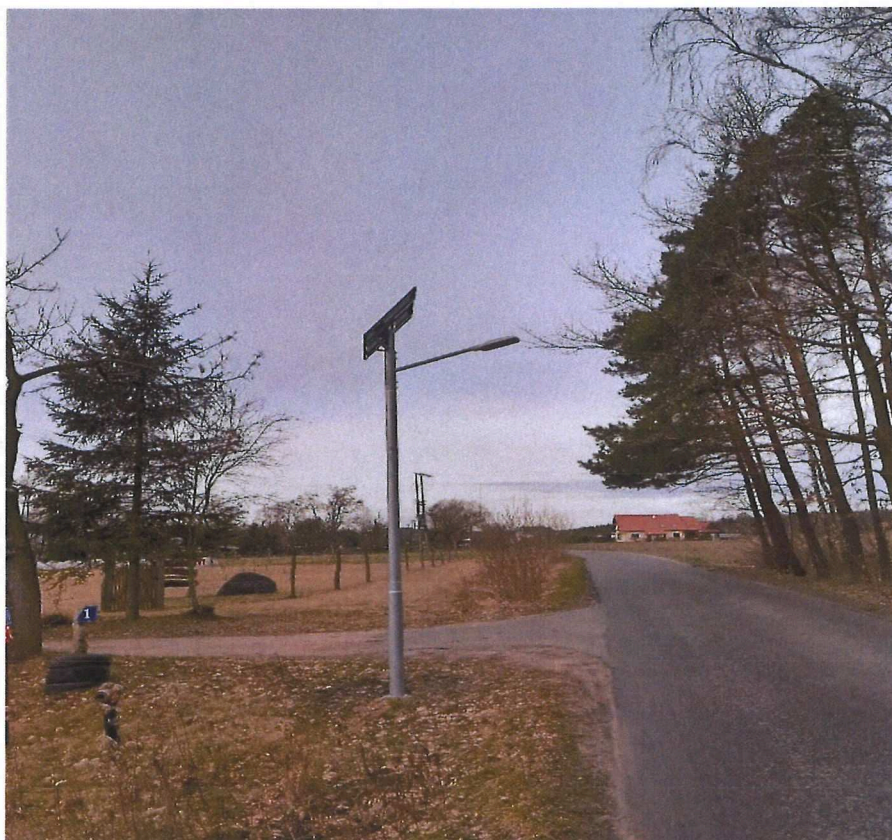
Zdjęcie 7 Latarnie solarne
