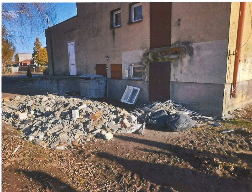
Zdjęcie 11 Remont świetlicy w Wielosiu
