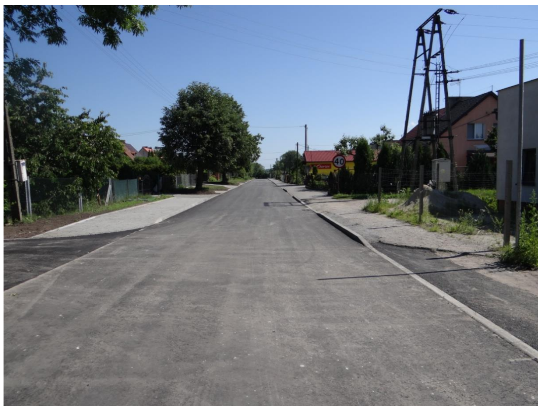
Zdjęcie 2 Przebudowa drogi gminnej w Lipiu
