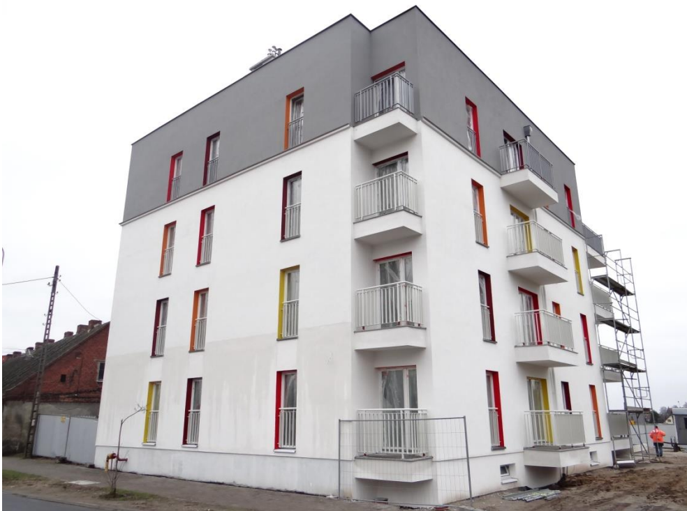
Zdjęcie 15 Budowa bloku komunalnego w Gniewkowie
