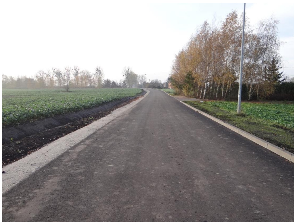
Zdjęcie 4 Przebudowa ul. Cegielnej w Gniewkowie
