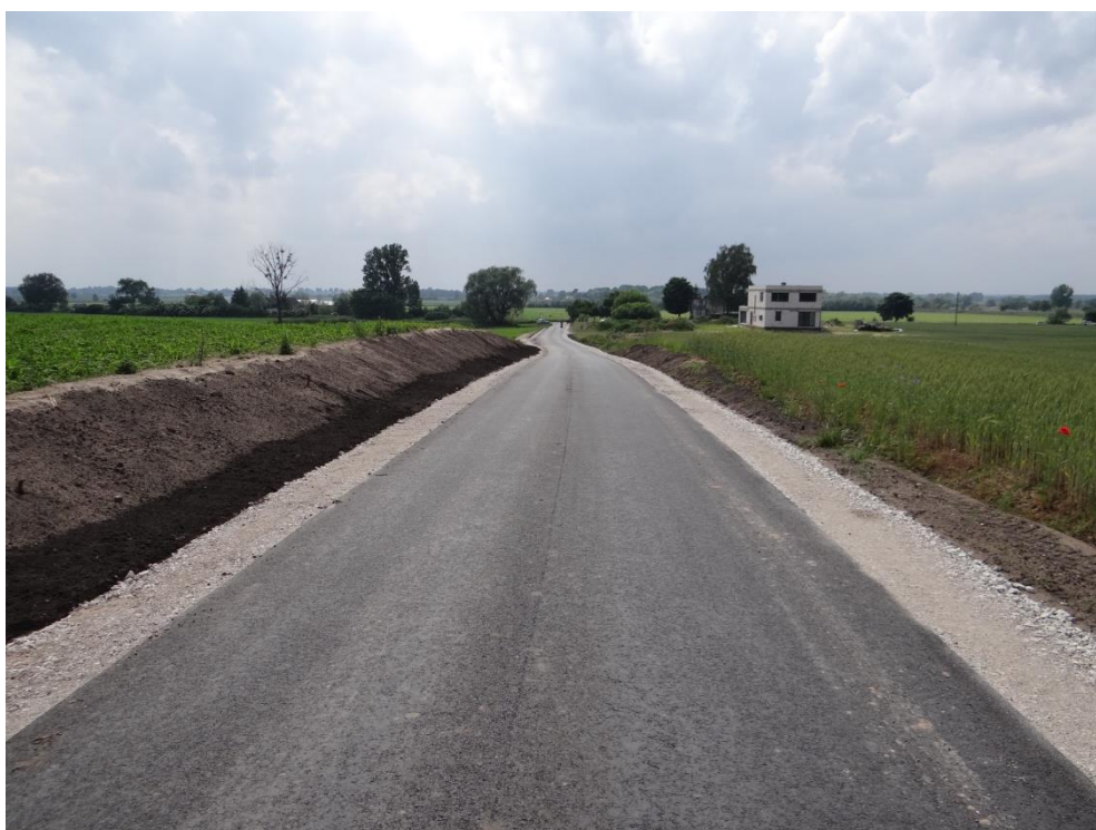
Zdjęcie 3 Przebudowa drogi w Suchatówce
