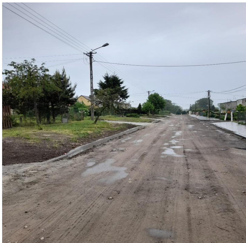
Zdjęcie 1 Przebudowa drogi gminnej w Lipiu
