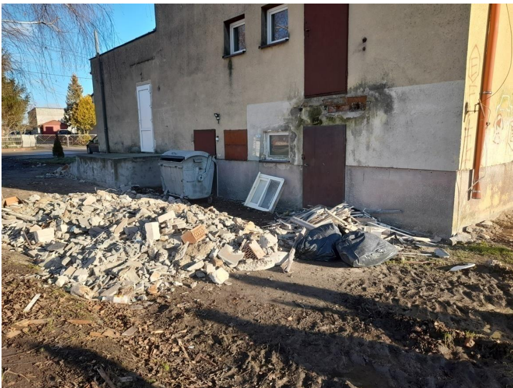
Zdjęcie 11 Remont świetlicy w Wielosiu
