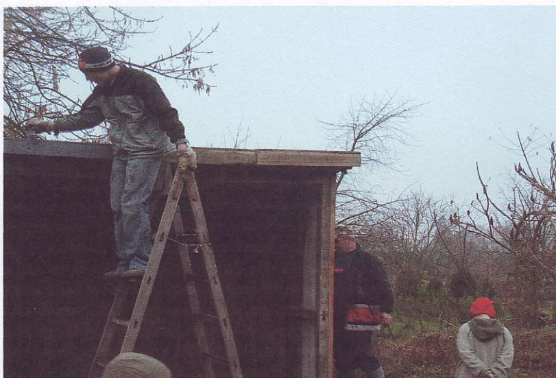
Fot. Remont przystanku autobusowego
