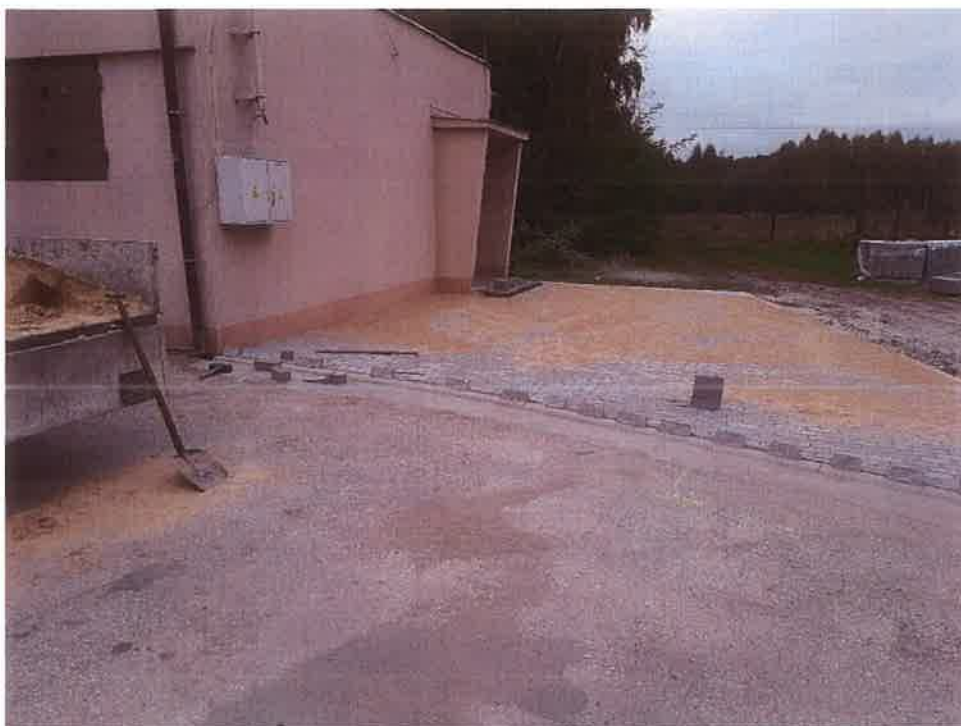
Zdjęcie 7 Utwardzenie terenu przy świetlicy w Godzienie
