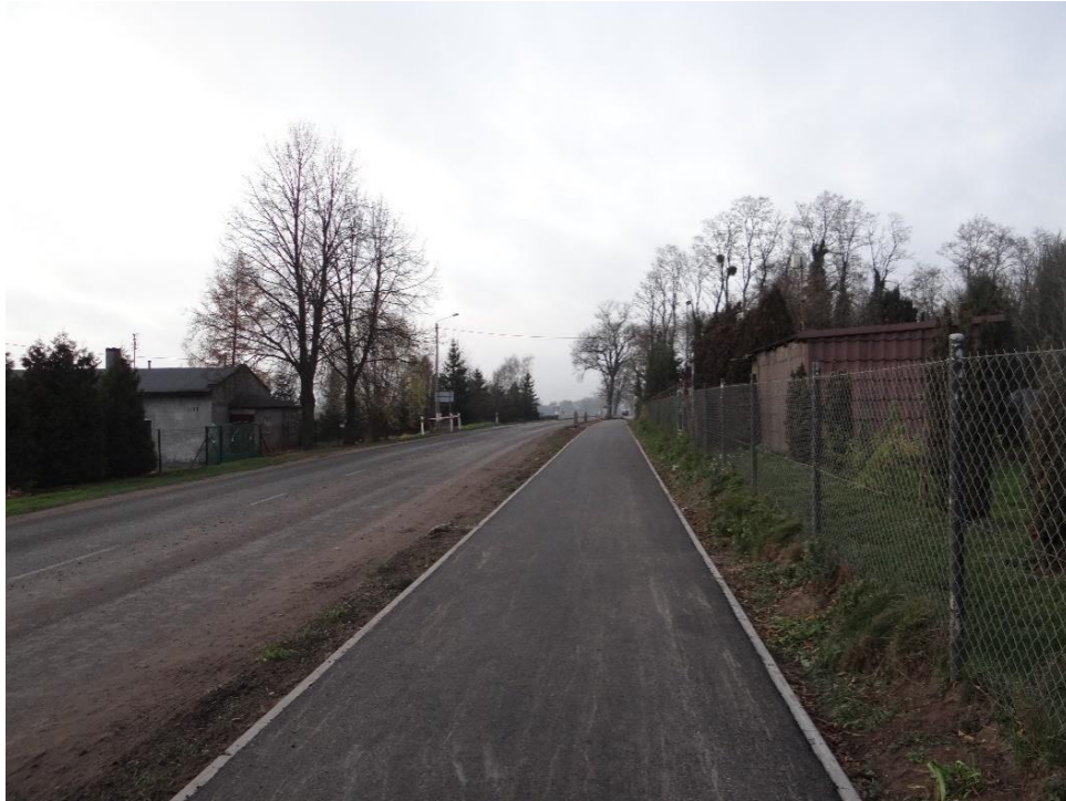
Zdjęcie 11 Ścieżka rowerowa Lipie-Murzynko
