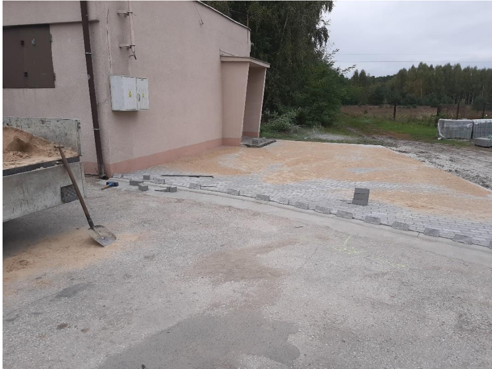
Zdjęcie 7 Utwardzenie terenu przy świetlicy w Godziewie
