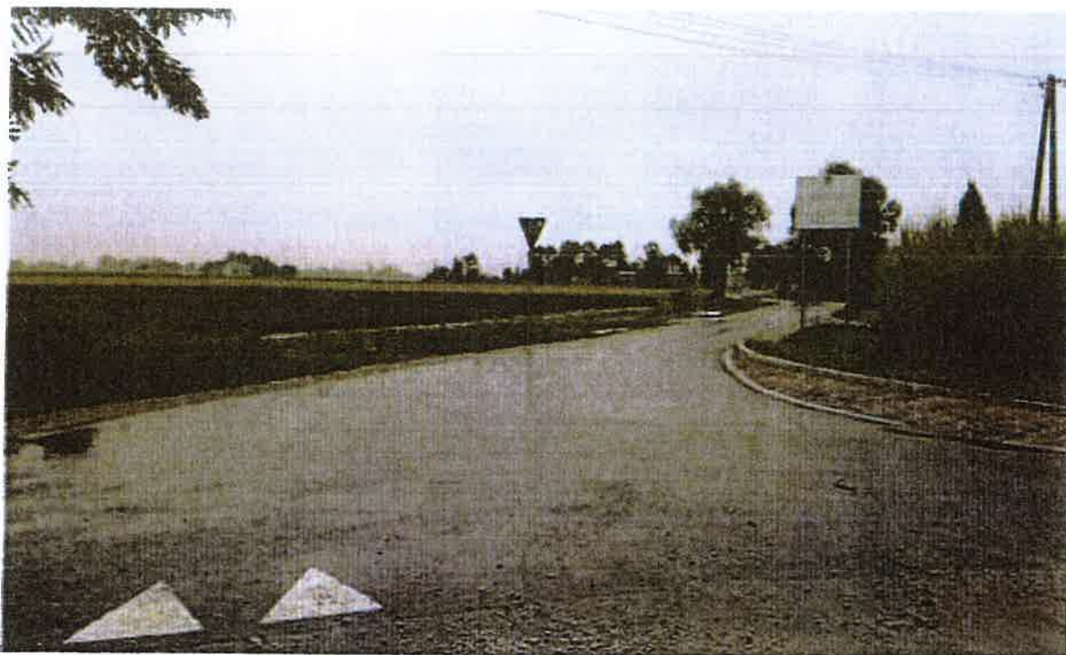
Zdjęcie 3 Przebudowa drogi gminnej w Kawęczynie
