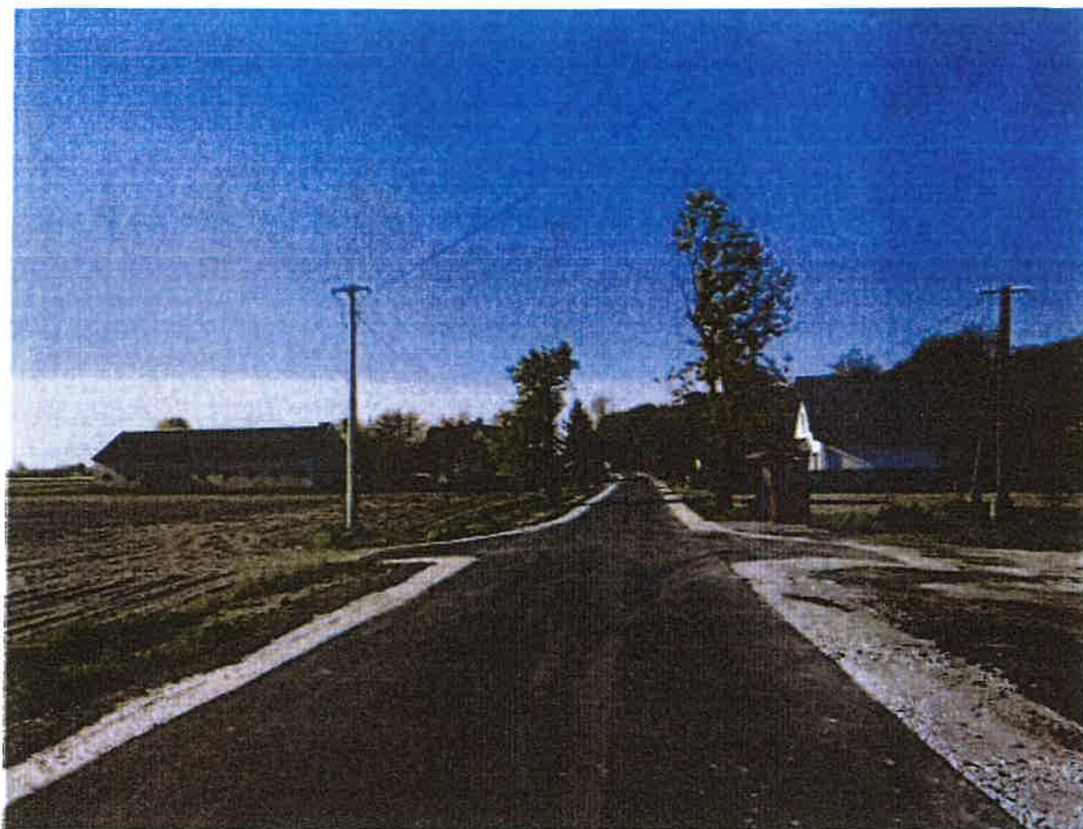
Zdjęcie 1 Droga gminna w Buczkowie
