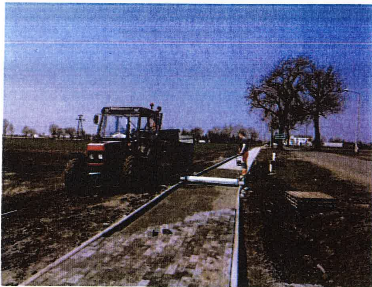
Zdjęcie 4 Rozbudowa drogi powiatowej 2534C - ciąg pieszo-rowerowy w Ostrowie
