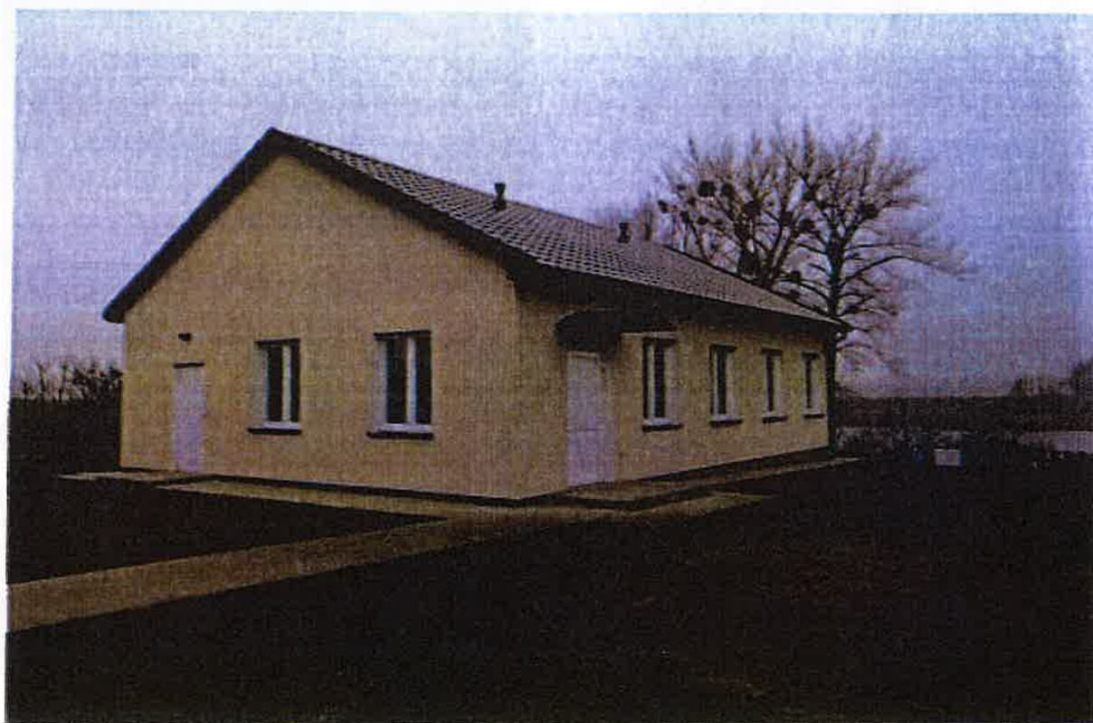
Zdjęcie 8 Świetlica wiejska w Kaczkowie
