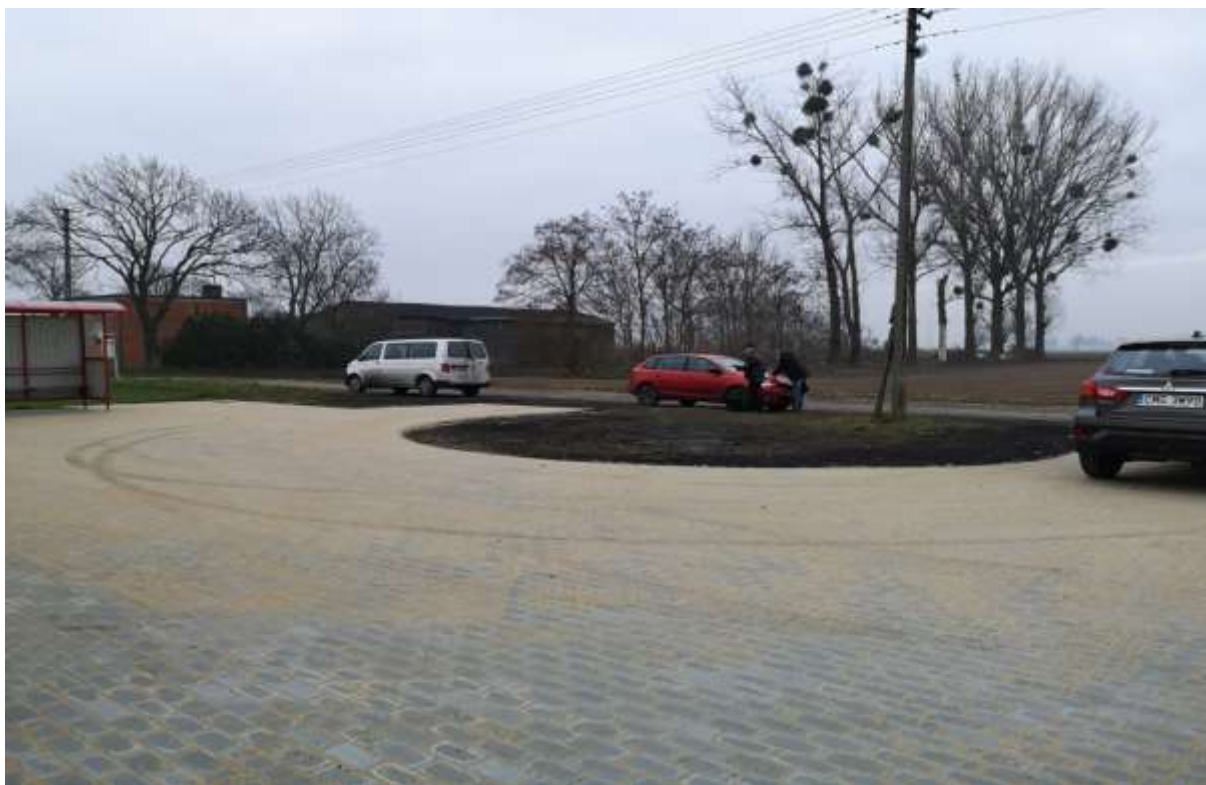
Zdjęcie 5 Utwardzenie terenu przed świetlicą wiejską w Kleparach
