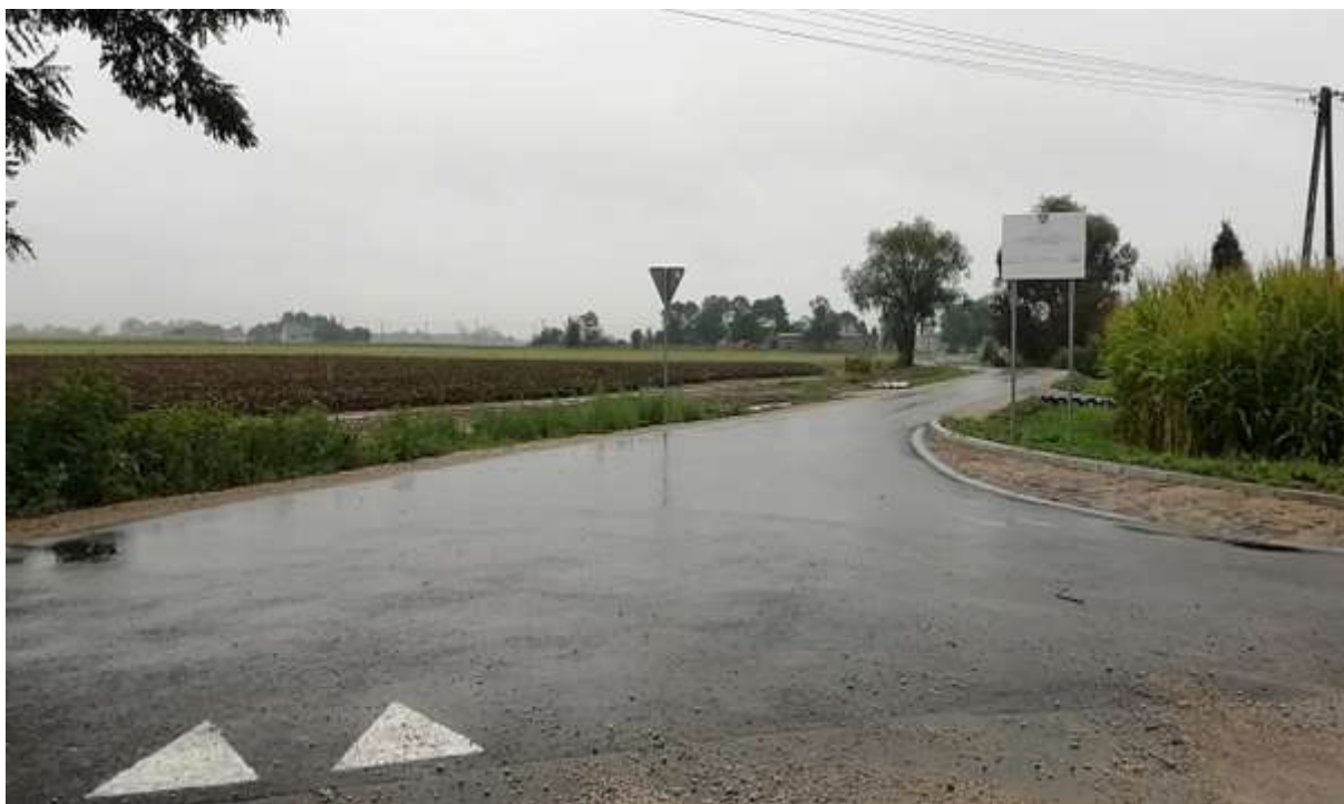
Zdjęcie 3 Przebudowa drogi gminnej w Kawęczynie
