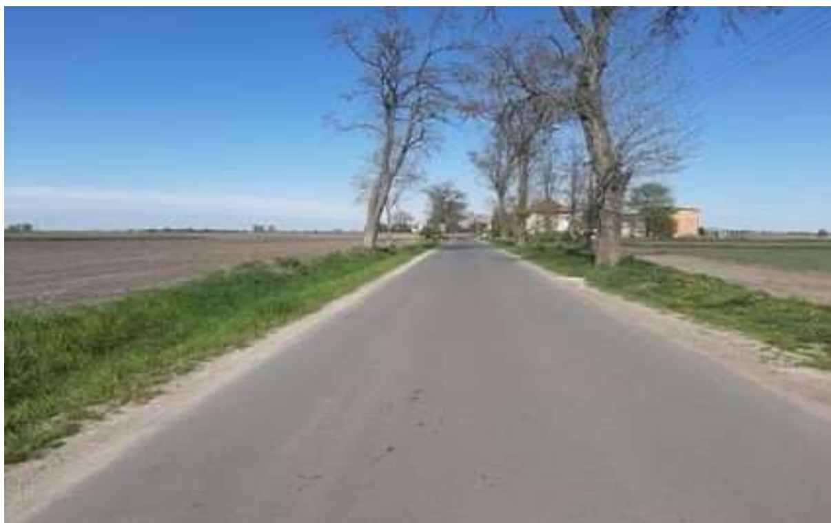
Zdjęcie 2 Przebudowa drogi gminnej w Gąskach
