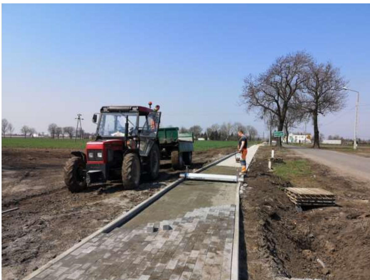
Zdjęcie 4 Rozbudowa drogi powiatowej 2534C - ciąg pieszo-rowerowy w Ostrowie
