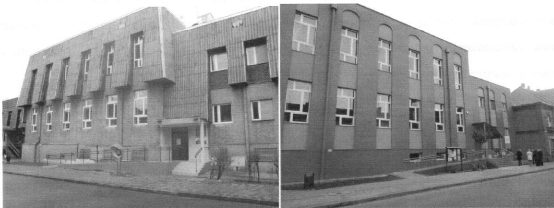
MGOKSiR przed modernizacją
