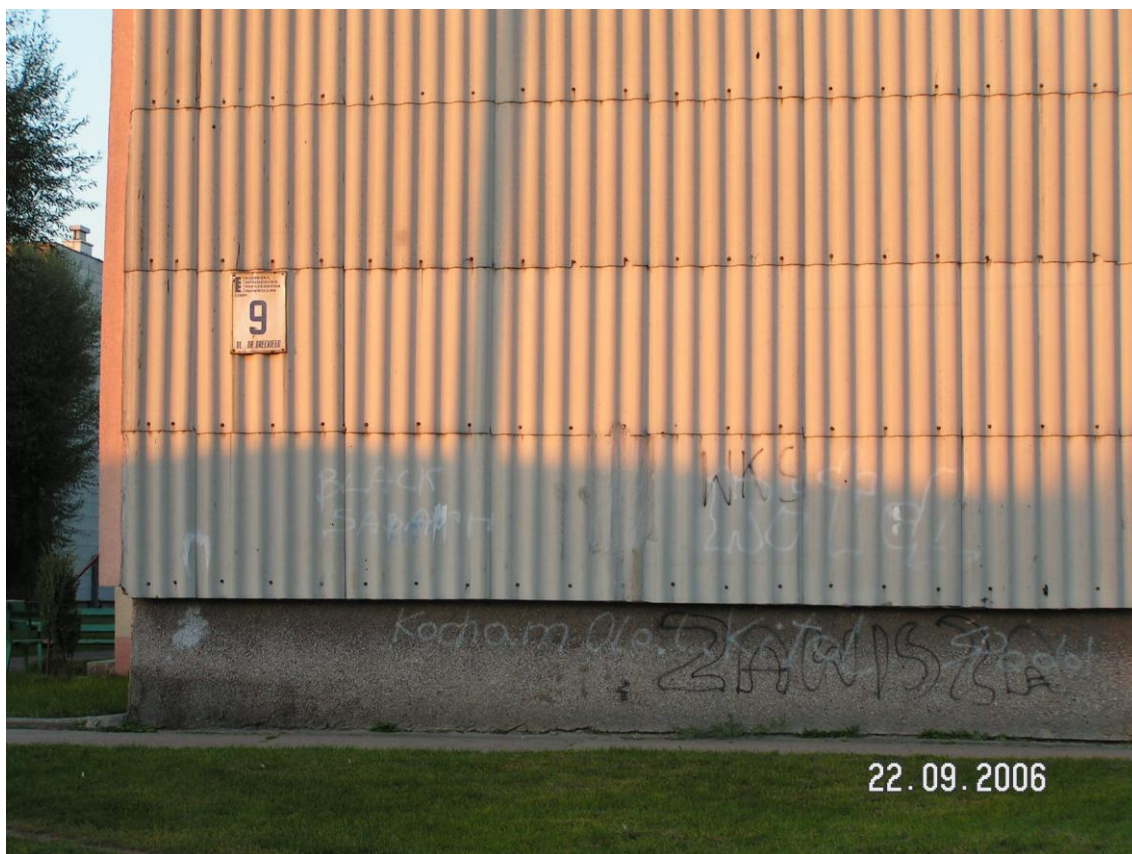
Zdjęcie nr 4 Elewacja budynku - płyta falista
