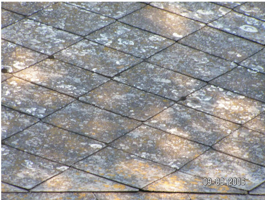
Zdjęcie nr 2. Pokrycie dachowe - płyty azbestowo – cementowe typu „CARO”
