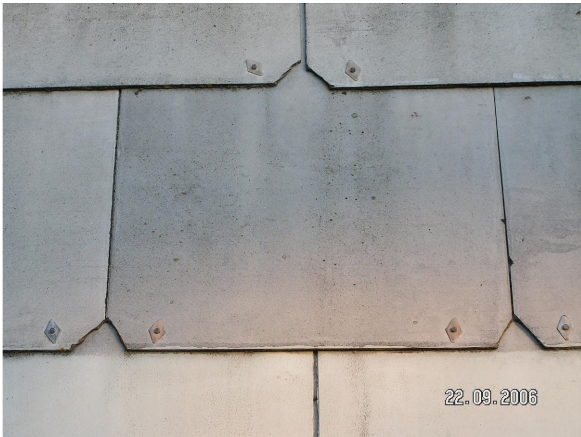
Zdjęcie nr 3. Elewacja budynku - płyta płaska
