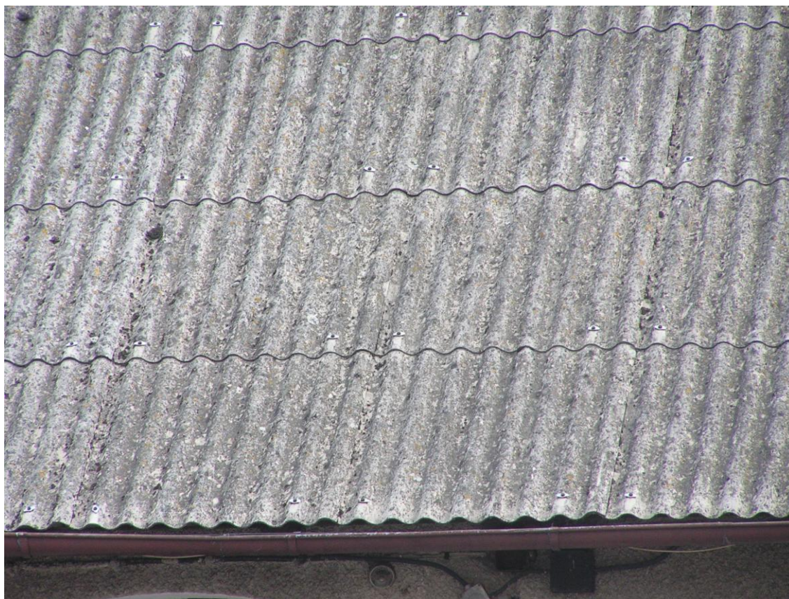
Zdjęcie nr 1. Pokrycie dachowe - płyta azbestowo – cementowa falista
