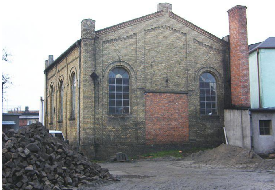
FOT. 8. BUDYNEK BOŻNICY
