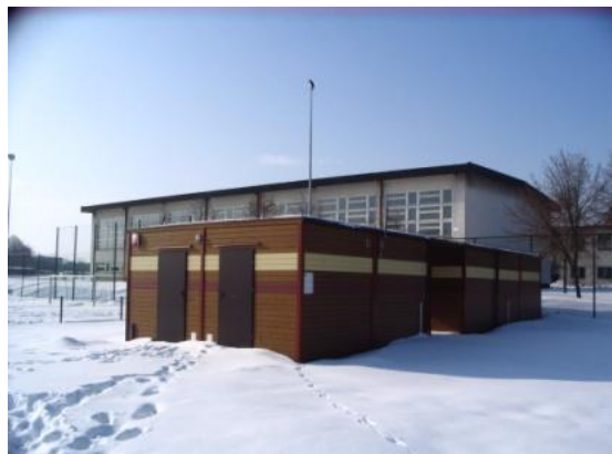
FOT.7. ORLIK – BUDYNEK SANITARNO-SZATNIOWY
