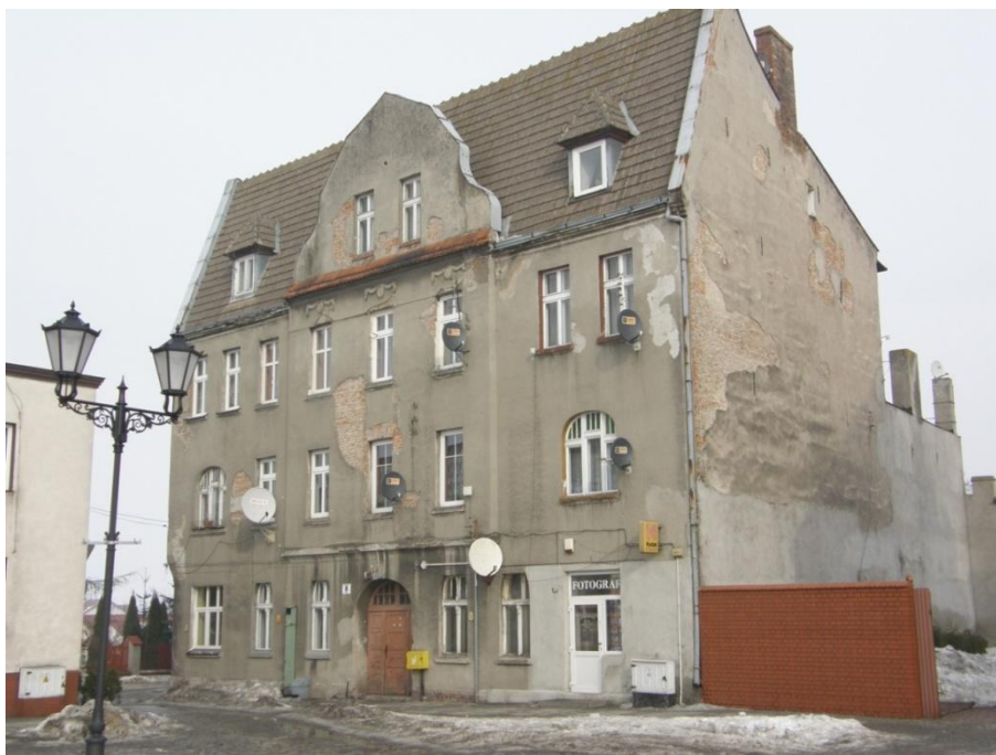
Fot. 13. WIDOK NA BUDYNEK KOMUNALNY – RYNEK 8
