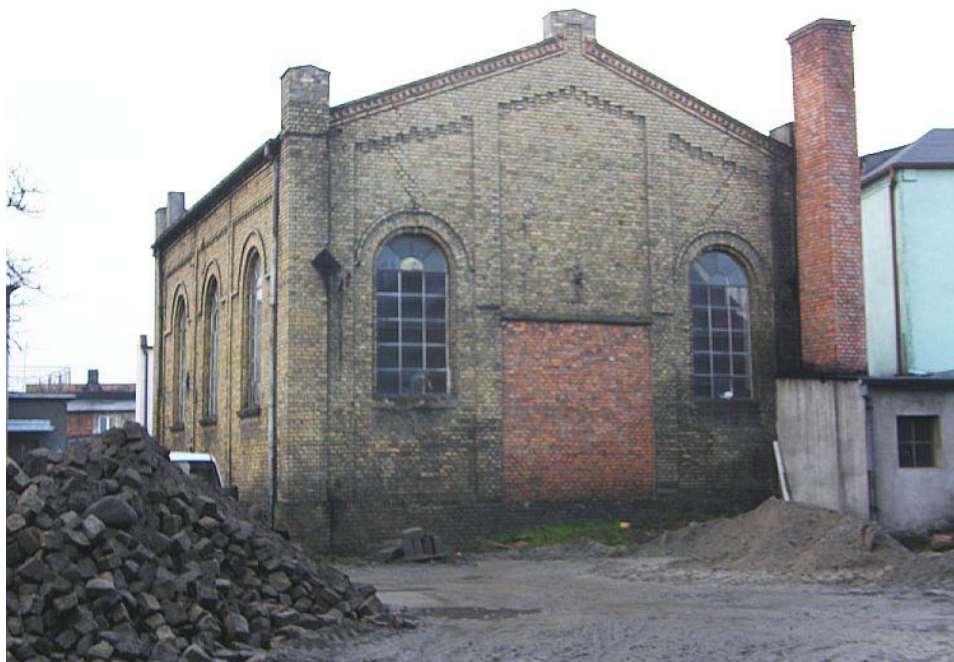
FOT. 8. BUDYNEK BOŻNICY
