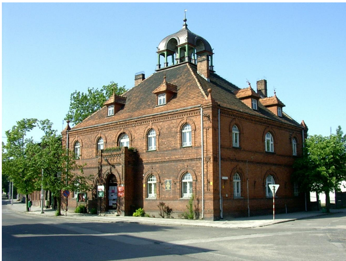
FOT. 10. BUDYNEK RATUSZA.
