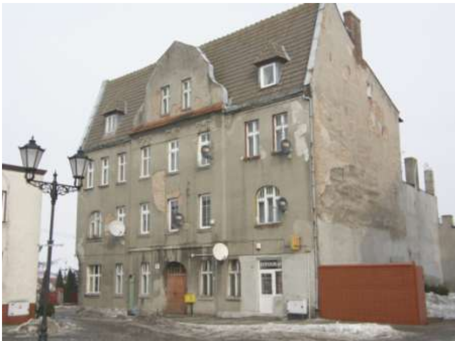
Fot. 20. WIDOK NA BUDYNEK KOMUNALNY – RYNEK 8
