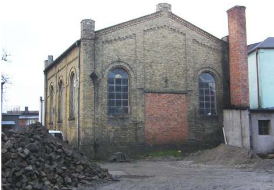
FOT. 14. BUDYNEK BOŻNICY
