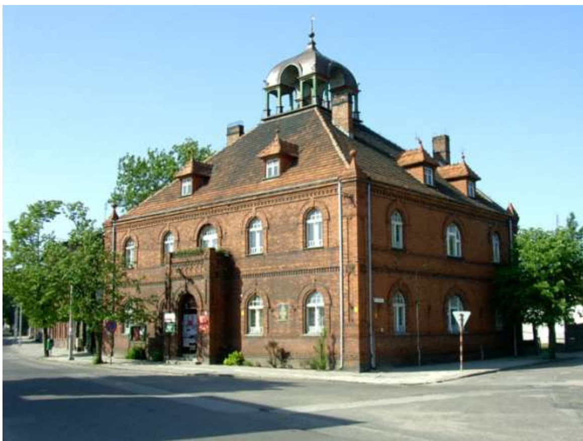
FOT. 16. BUDYNEK RATUSZA.
