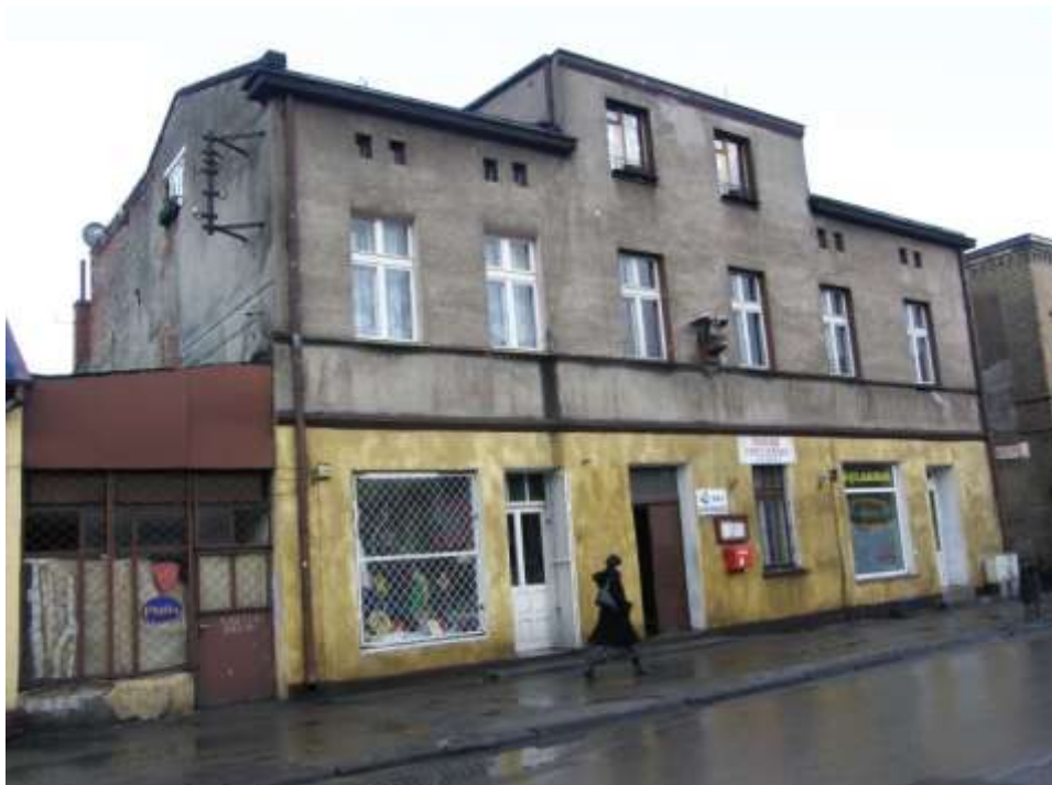
Fot. 21. BUDYNEK KOMUNALNY – UL. SOBIESKIEGO 11
