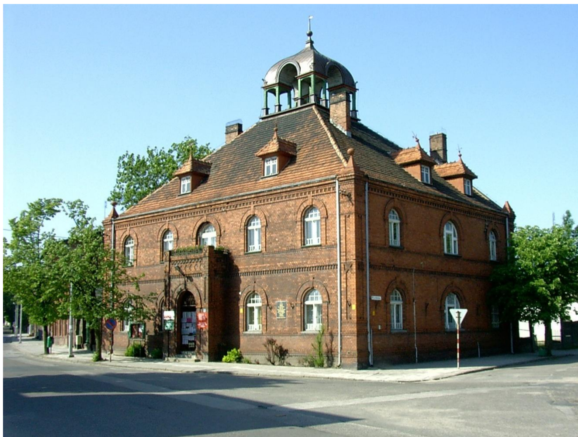
FOT. 10. BUDYNEK RATUSZA.
