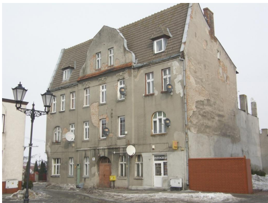
Fot. 13. WIDOK NA BUDYNEK KOMUNALNY – RYNEK 8
