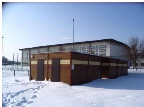
FOT.7. ORLIK – BUDYNEK SANITARNO-SZATNIOWY
