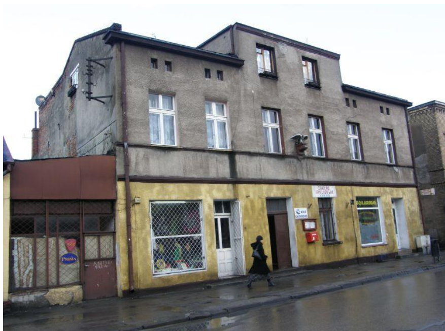
Fot. 14. BUDYNEK KOMUNALNY – UL. SOBIESKIEGO 11
