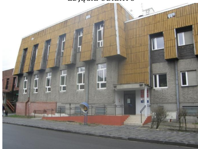
FOT. 9. BUDYNEK MGOKSiR.
