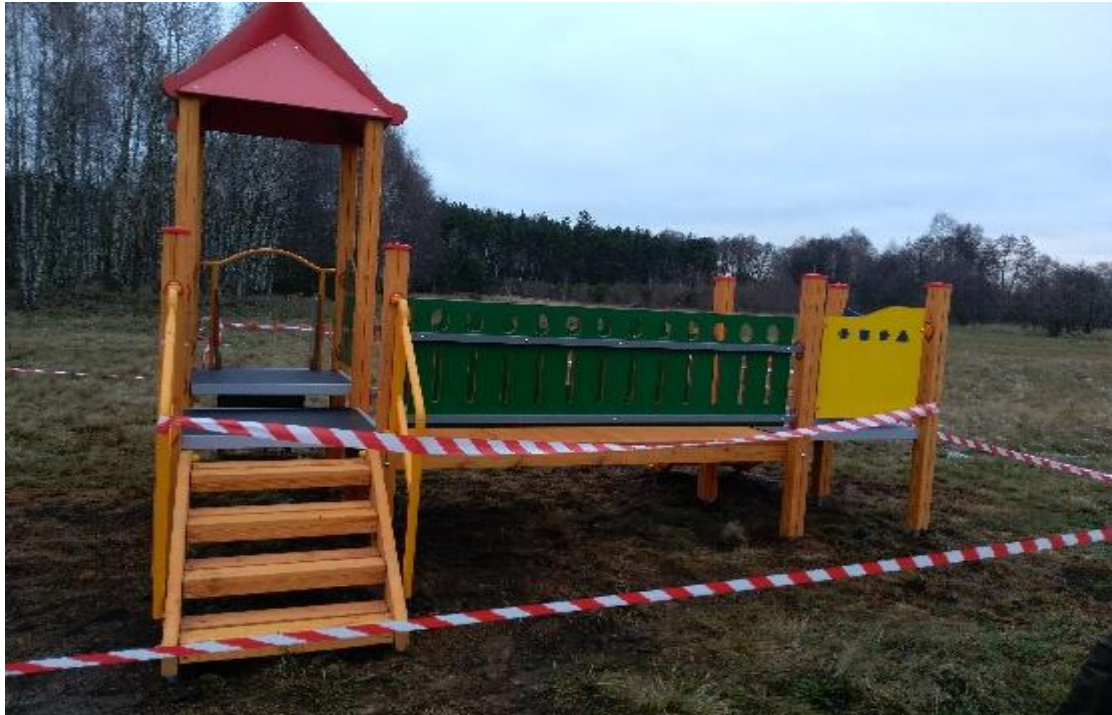
Budowa placu zabaw w miejscowości Faustynowo
