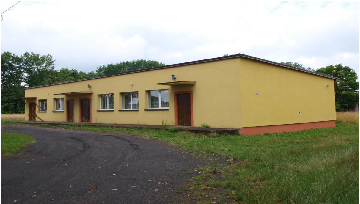
Nowa elewacja na budynku świetlicy wiejskiej w Płaciszewie
