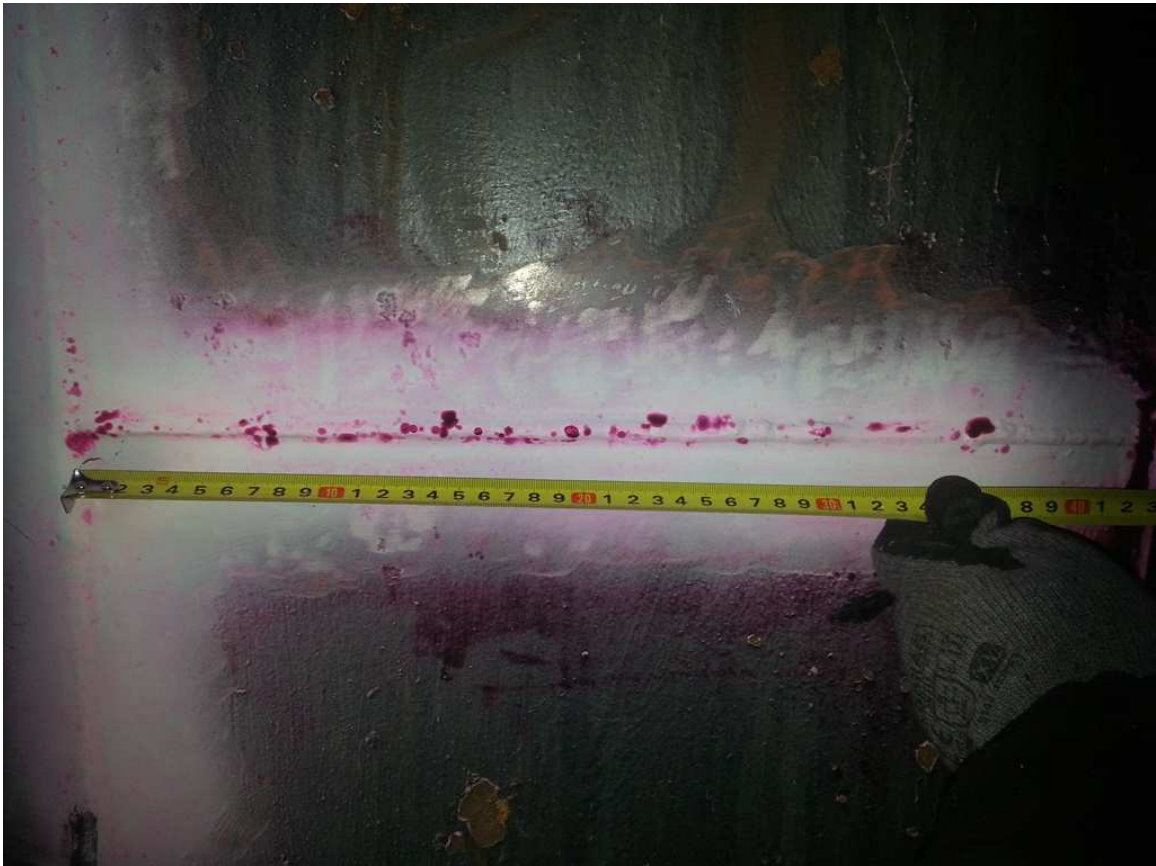
Fot. 18 Przebieg badania penetracyjnego PT połączenia spawanego ściany stalowej zbiornika
