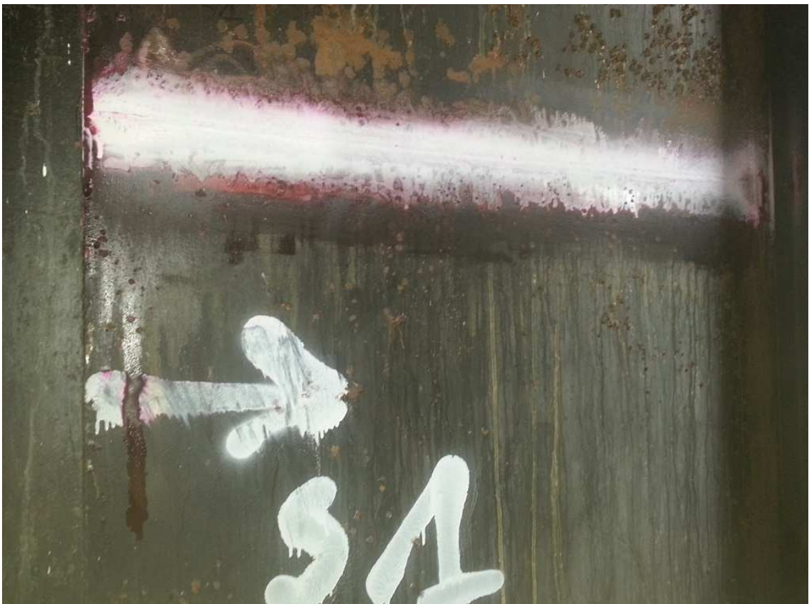
Fot. 11 Przebieg badania penetracyjnego PT połączenia spawanego ściany stalowej zbiornika
