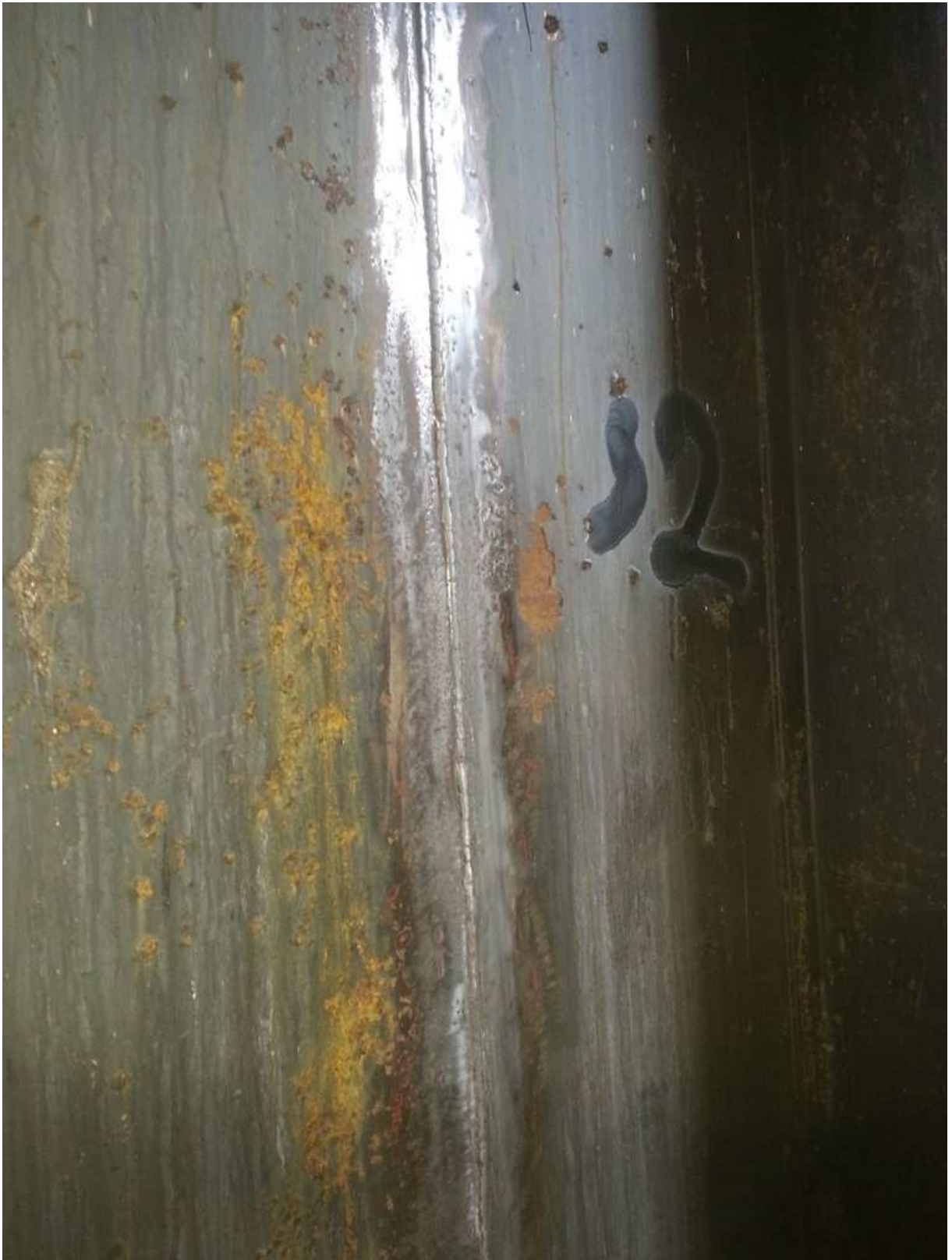
Fot. 7 Przygotowanie powierzchni połączenia spawanego ściany zbiornika
