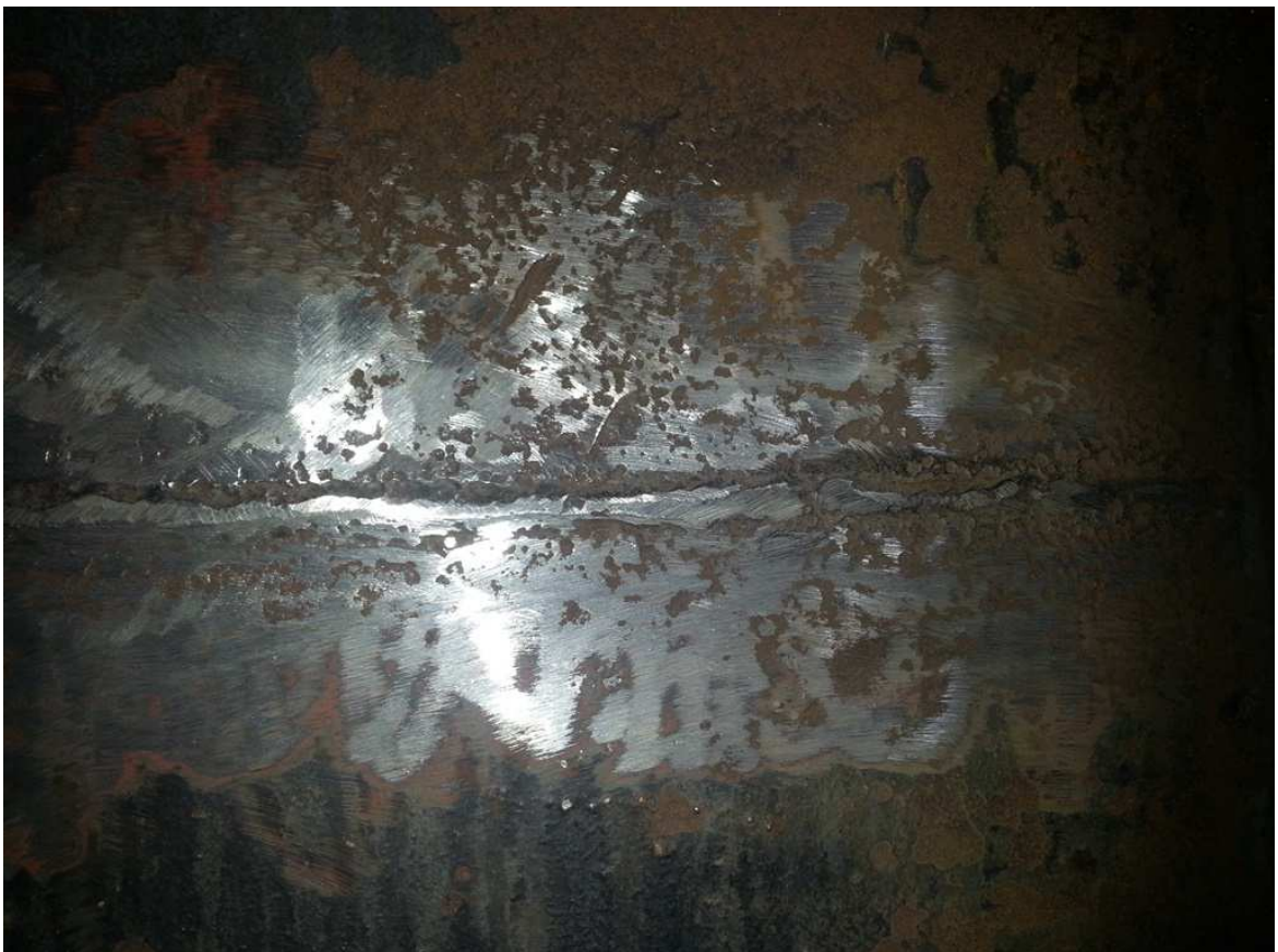
Fot. 5 Przygotowanie powierzchni połączenia spawanego ściany zbiornika
