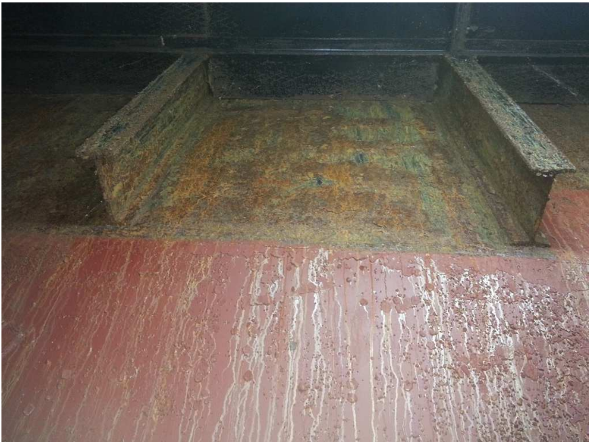
Fot. 1 Powierzchnia ściany zewnętrznej zbiornika poddana badaniom
