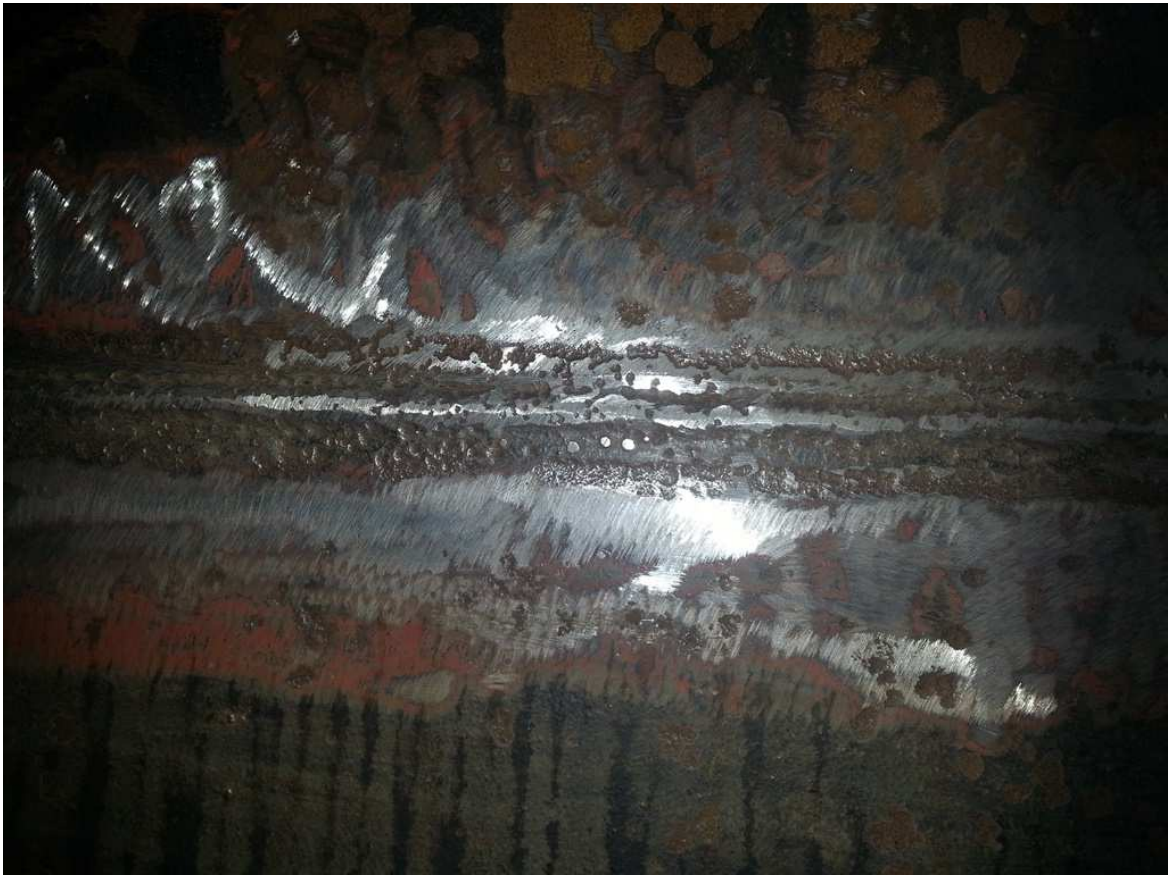
Fot. 4 Przygotowanie powierzchni połączenia spawanego ściany zbiornika
