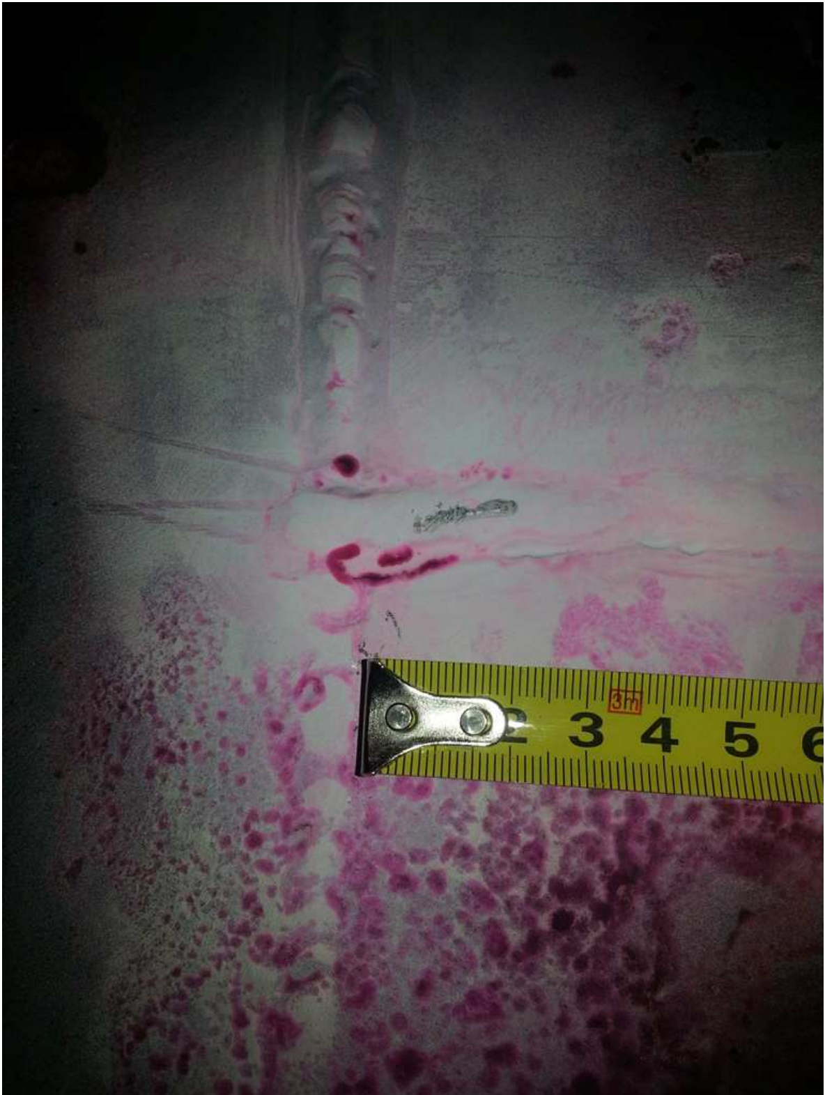
Fot. 14 Przebieg badania penetracyjnego PT połączenia spawanego ściany stalowej zbiornika
