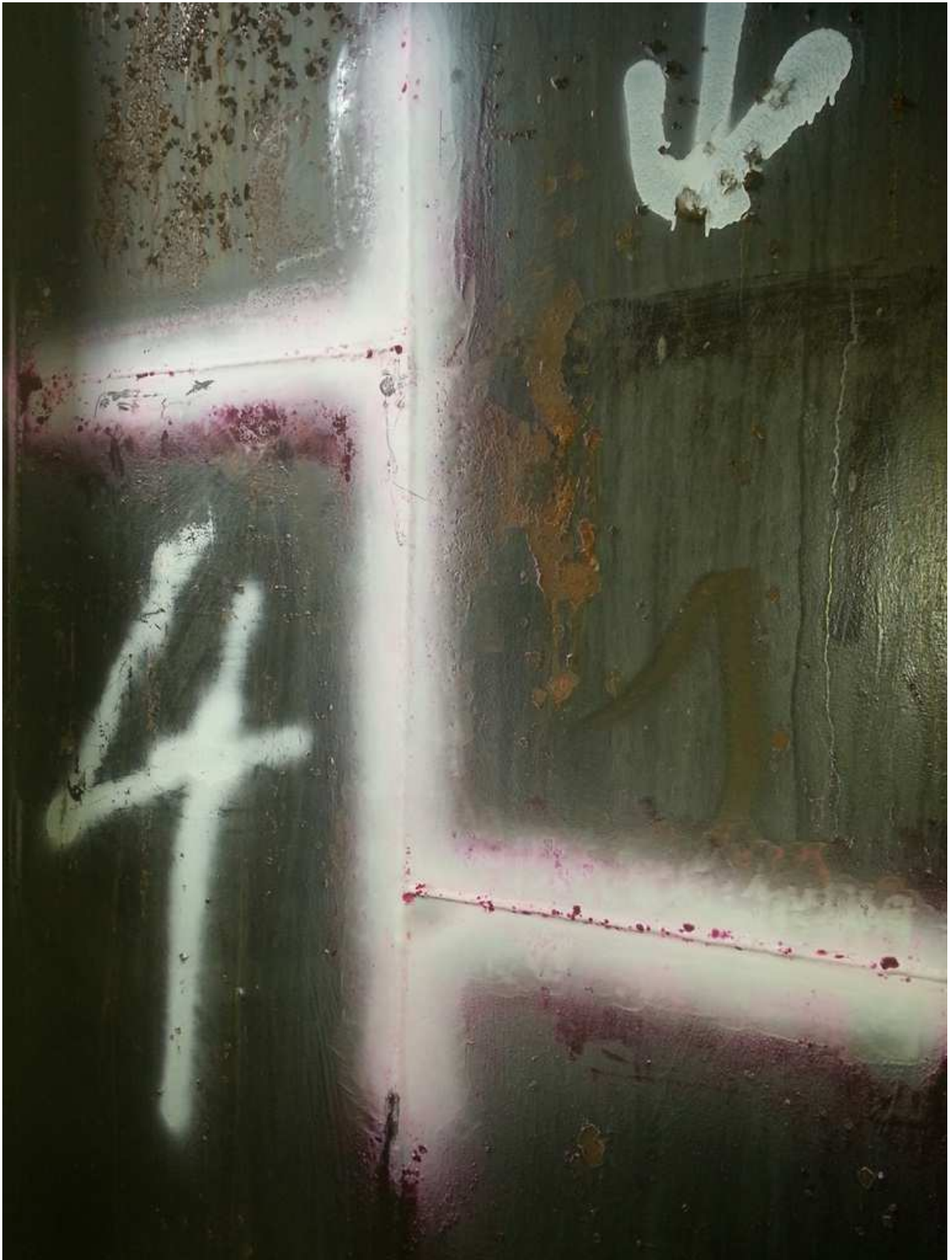
Fot. 17 Przebieg badania penetracyjnego PT połączenia spawanego ściany stalowej zbiornika
