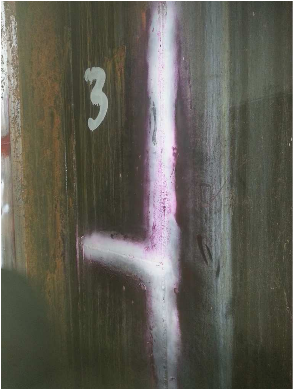
Fot. 15 Przebieg badania penetracyjnego PT połączenia spawanego ściany stalowej zbiornika
