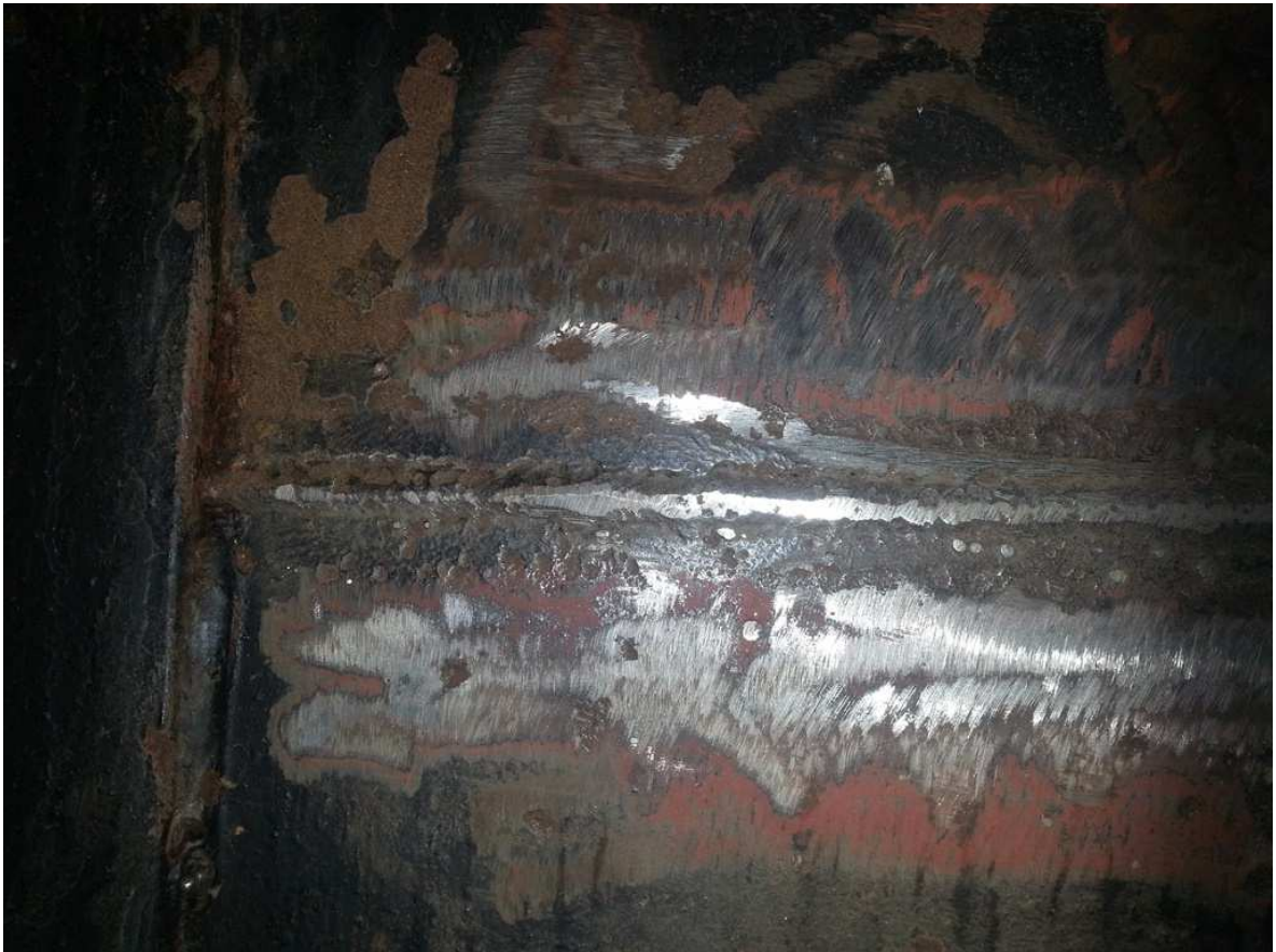
Fot. 6 Przygotowanie powierzchni połączenia spawanego ściany zbiornika
