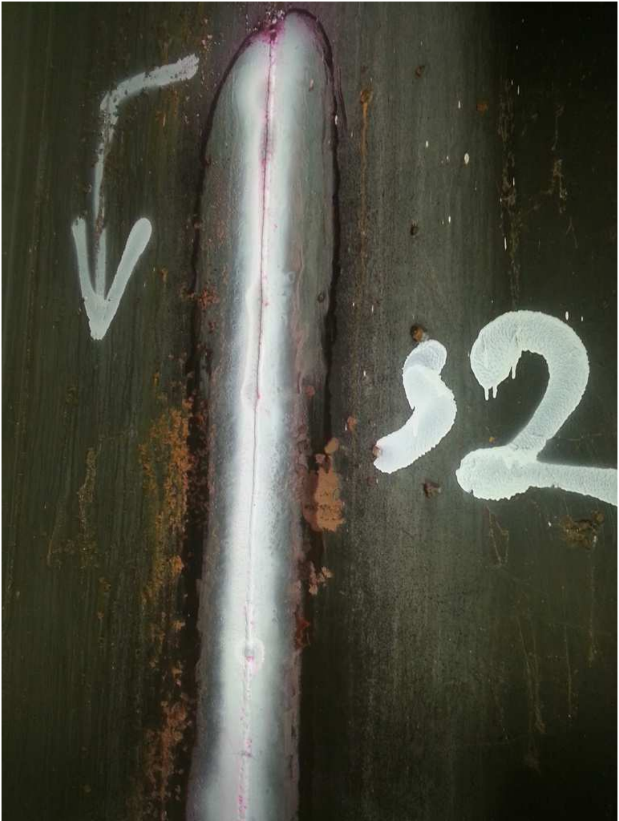
Fot. 12 Przebieg badania penetracyjnego PT połączenia spawanego ściany stalowej zbiornika
