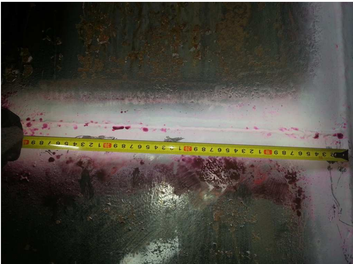
Fot. 19 Przebieg badania penetracyjnego PT połączenia spawanego ściany stalowej zbiornika
