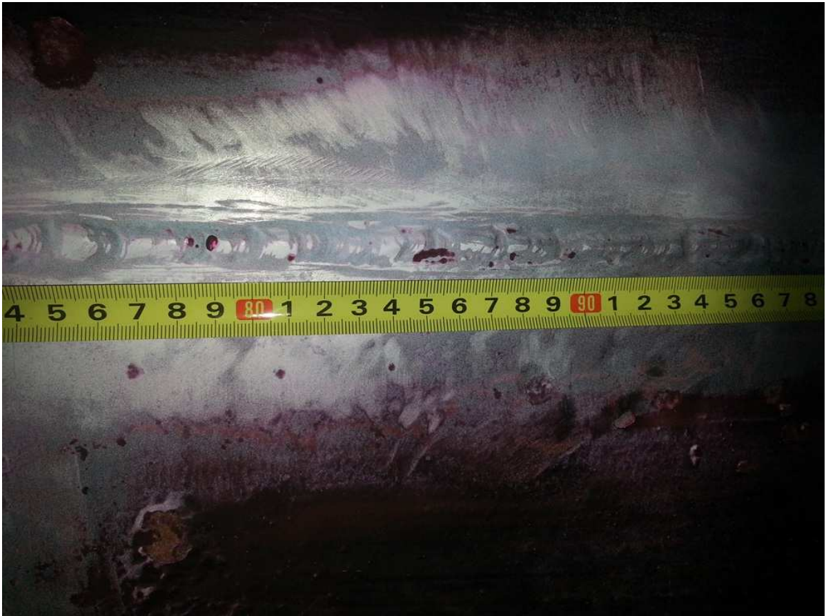
Fot. 13 Przebieg badania penetracyjnego PT połączenia spawanego ściany stalowej zbiornika
