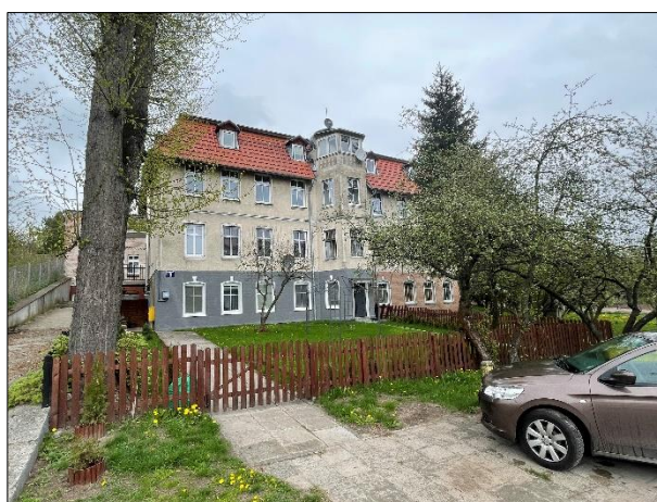
Fot. 9 Budynek mieszkalny o wysokich walorach historyczno-kulturowych przy ul. Suwalskiej 9 Źródło: archiwum własne
