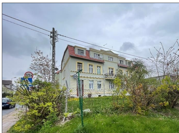
Fot. 8 Budynek mieszkalny przy ul. Staszica 2, ujęty w WEZ Źródło: archiwum własne
