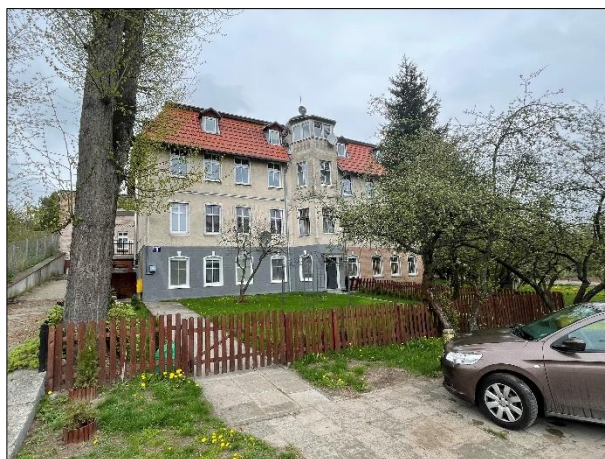
Fot. 9 Budynek mieszkalny o wysokich walorach historyczno-kulturowych przy ul. Suwalskiej 9 Źródło: archiwum własne
