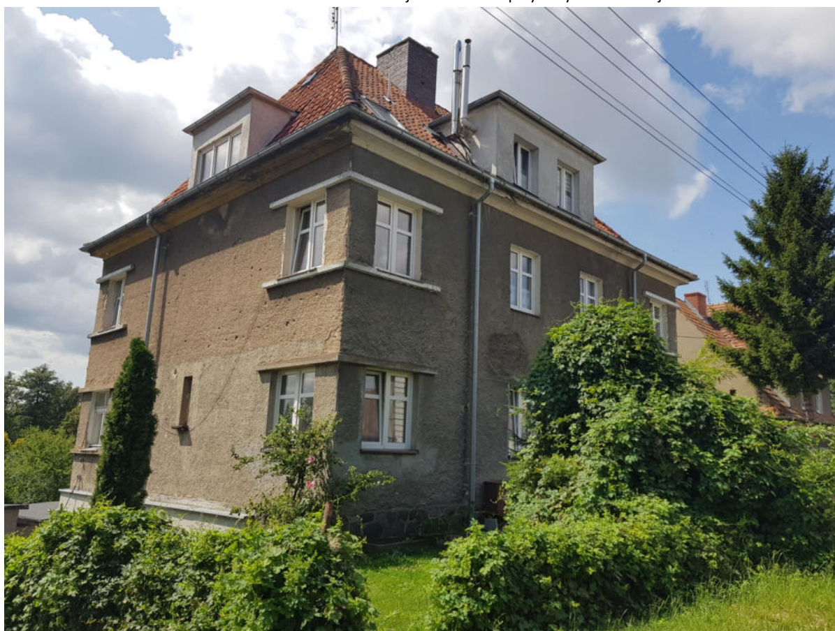
Fot. 10. Zabudowa mieszkaniowa jednorodzinna przy ulicy Białostockiej.
