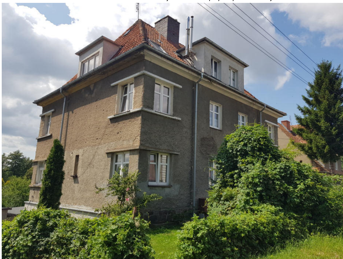
Fot. 10. Zabudowa mieszkaniowa jednorodzinna przy ulicy Białostockiej.
