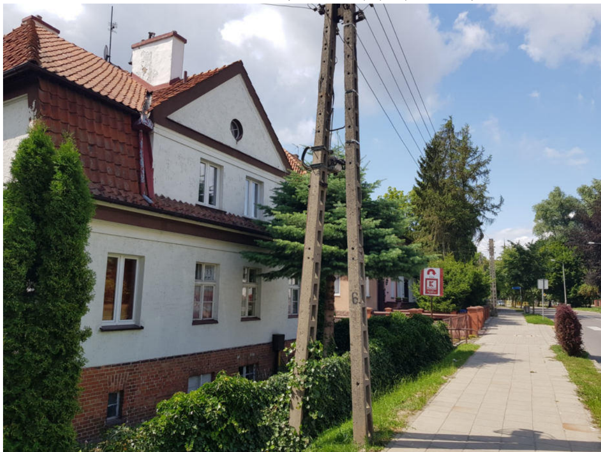
Fot. 9. Zabudowa mieszkaniowa jednorodzinna przy ulicy Białostockiej.
