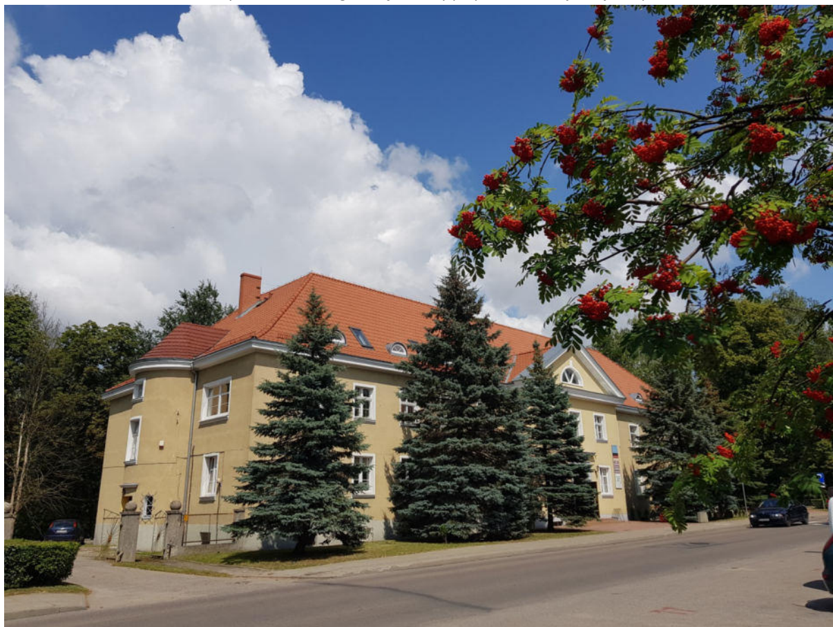
Fot. 5. Budynek Powiatowego Urzędu Pracy przy ul. Gdańskiej w rejonie parku.
