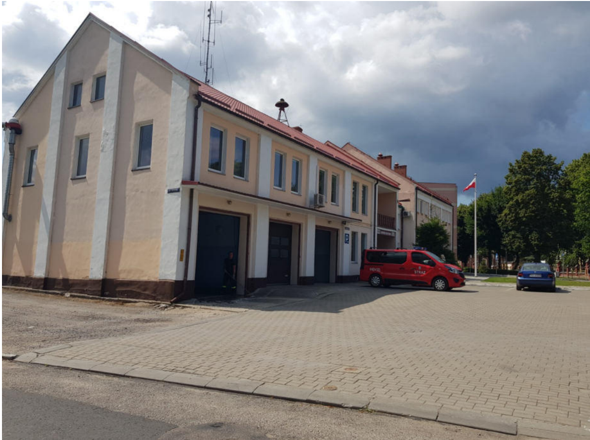
Fot. 7. Budynek Straży Pożarnej w rejonie skrzyżowania ulicy Białostockiej i Górnej.
