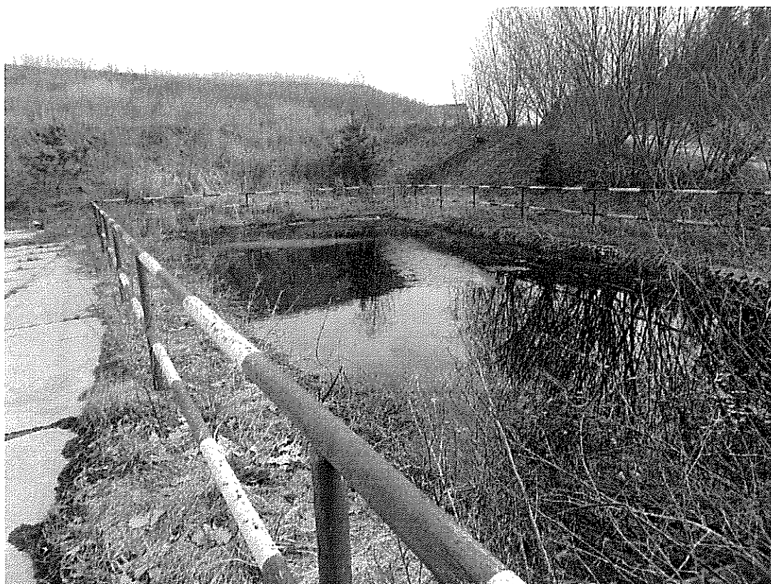
Fot. 5. Zbiornik na odcieki.
