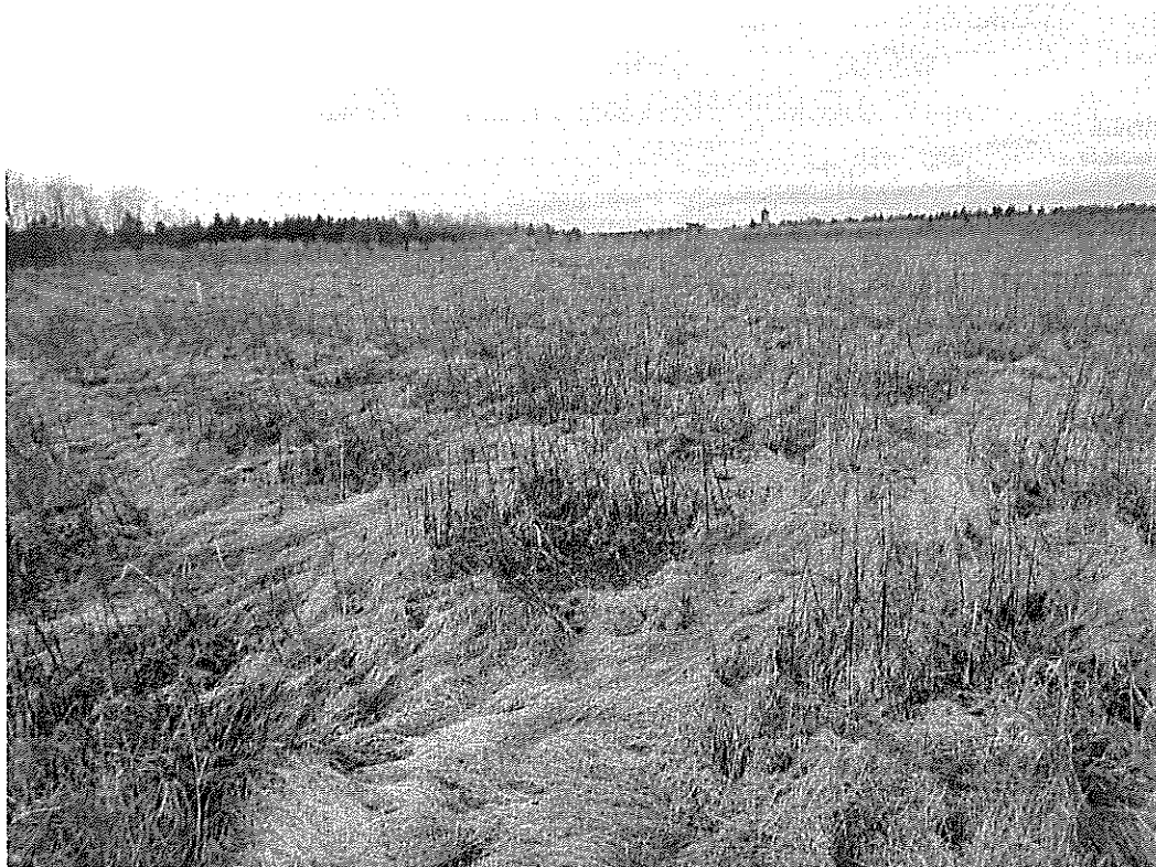
Fot. 1. Widok na zrehabilitowaną kwaterę składowiska z uwidoczną studnią odgazowującą w oddali.
