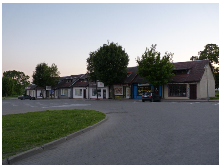
Zdjęcie. Budynki usługowe zlokalizowane w części centralnej obszaru objętego projektem planu.
