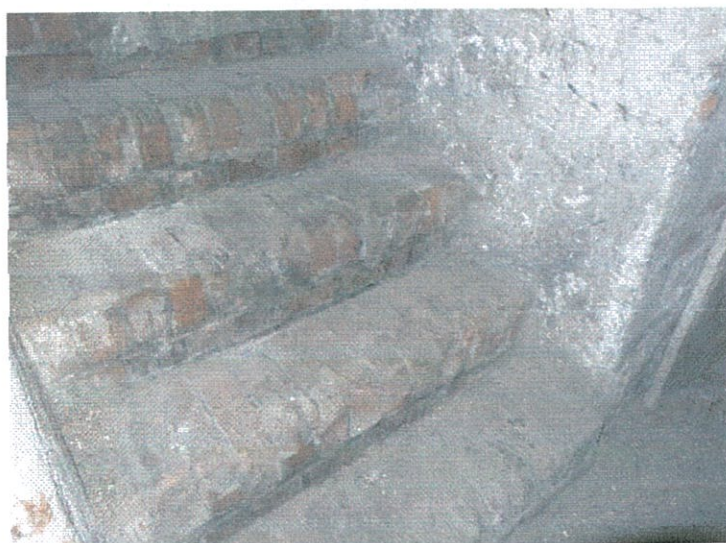
Rysunek 38 Schody do piwnicy
