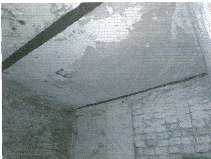
Rysunek 34 Strop nad piwnicą
