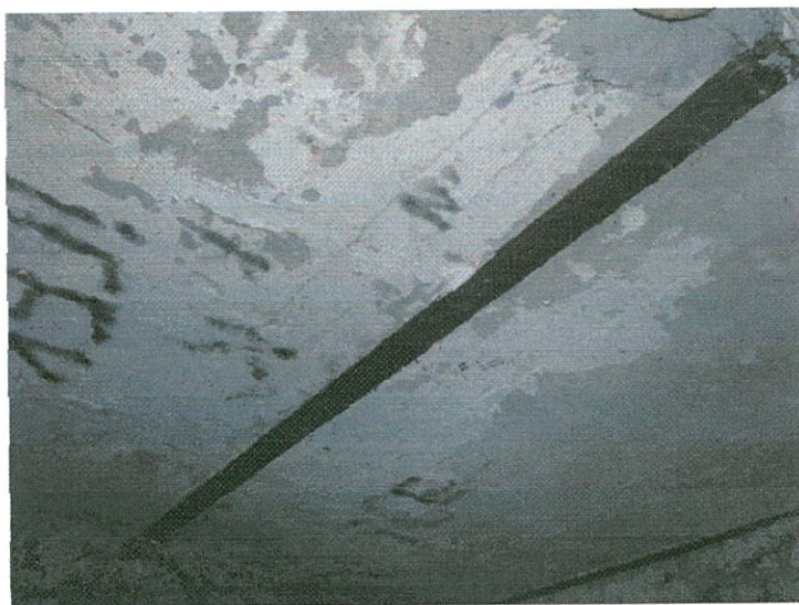
Rysunek 33 Strop nad piwnicą
