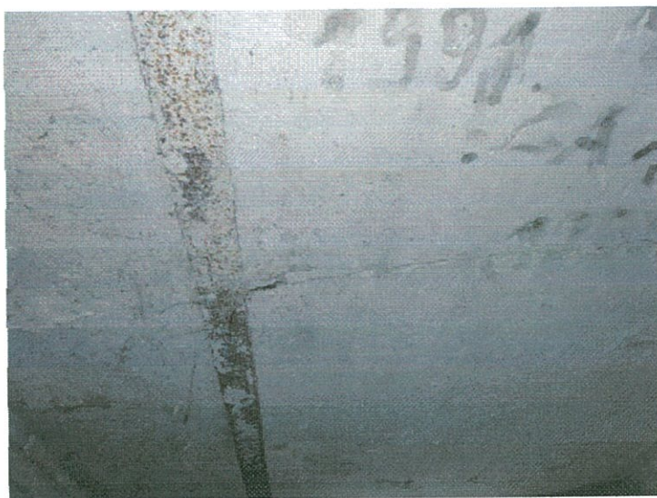
Rysunek 36 Strop nad piwnicą
