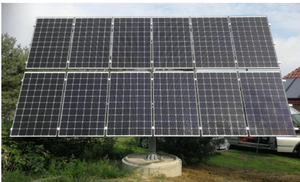
Rys.16 Tracker po montażu.
