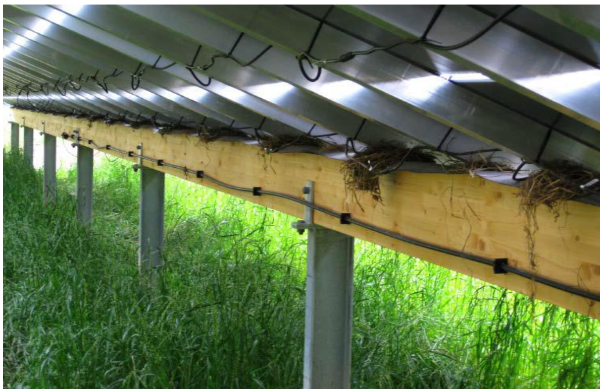
Rys.28 Podpory modułu służą jako miejsca gniazdowania ptaków. Foto: BELECTRIC.
