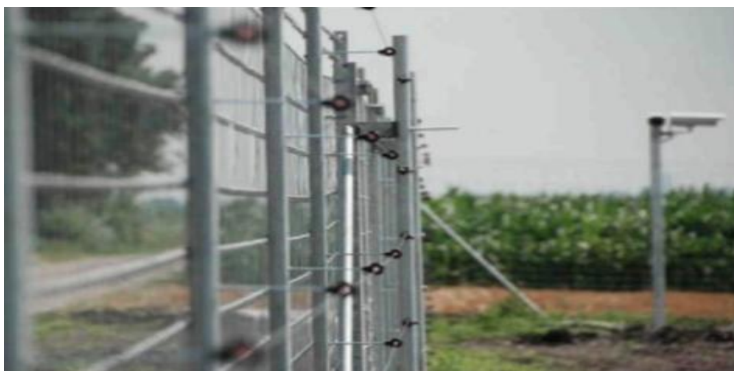
Rys.8 Przykładowe ogrodzenie wraz z systemem alarmowo – monitoringowym
