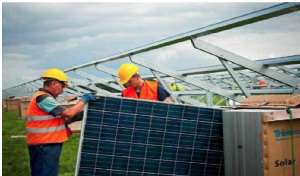
Rys.5 Montaż paneli EPV Bautzen przez Remor Solar- Recz
