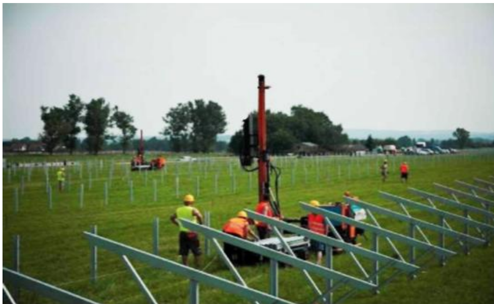
Rys.4 Wiertnica wykorzystywana podczas procesu osadzania konstrukcji montażowej (Remor Solar)
