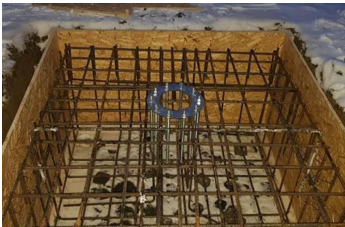
Rys.14 Fundamentowanie konstrukcji Trackera.
