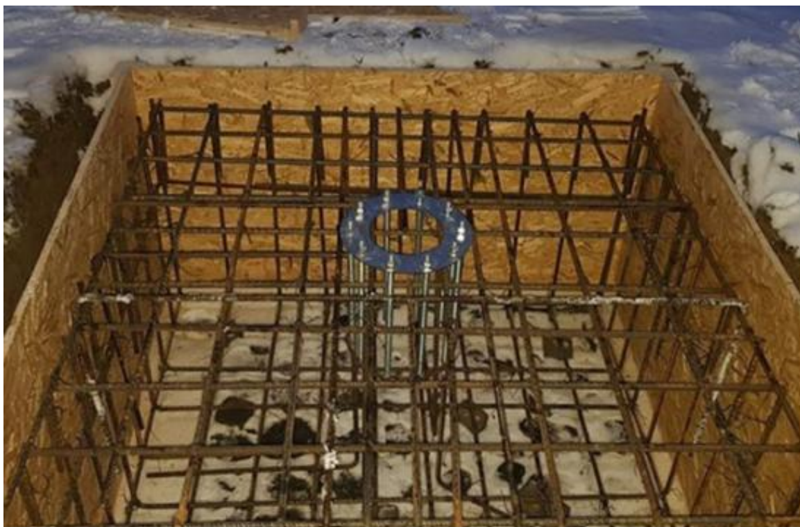
Rys.14 Fundamentowanie konstrukcji Trackera.
