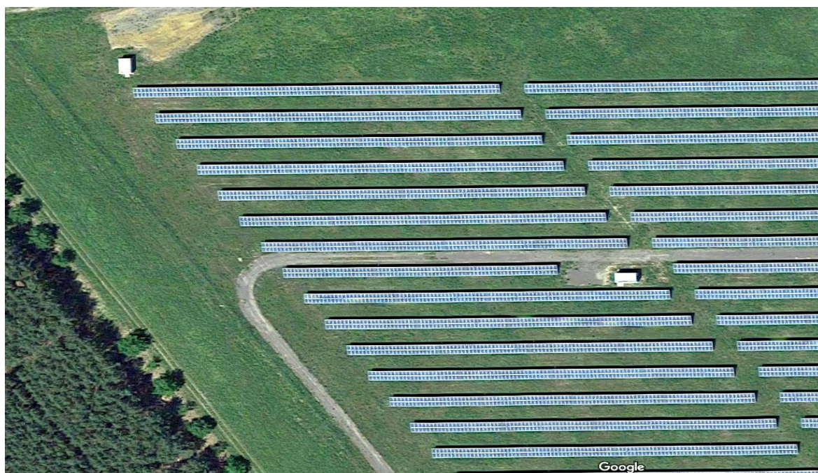
Rys.18 Sposób zagospodarowania terenu elektrowni fotowoltaicznej w m. Seftengberg, Niemcy. Źródło: Google.pl/maps
