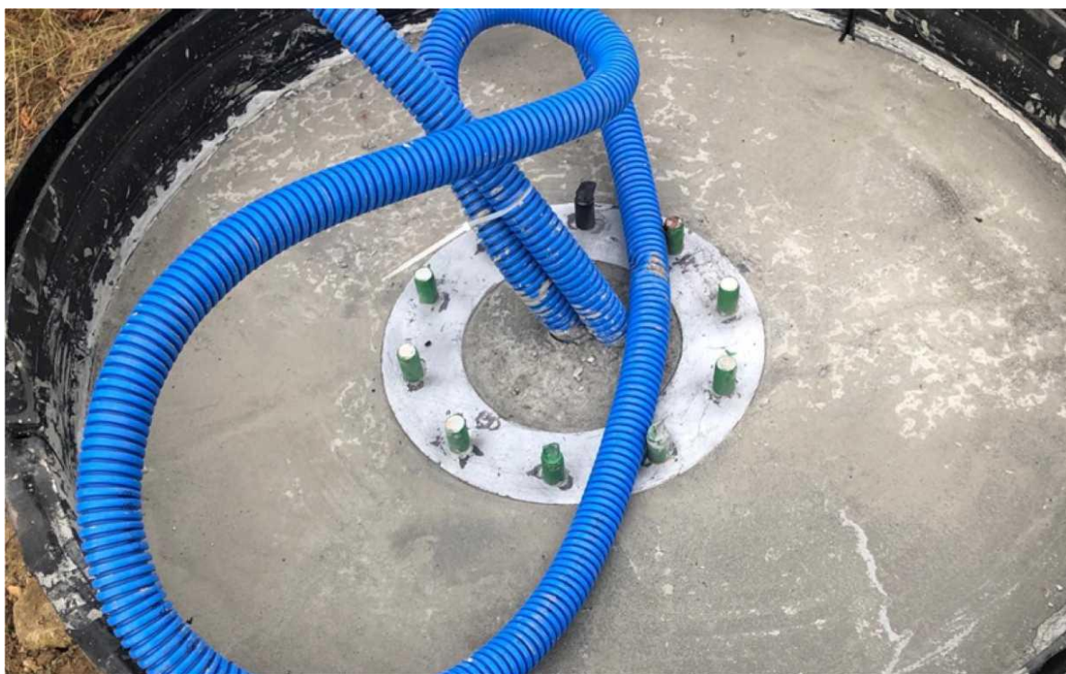
Rys.15 Fundament Trackera przygotowany do montażu stelaża z panelami i systemem nadążnym. .
