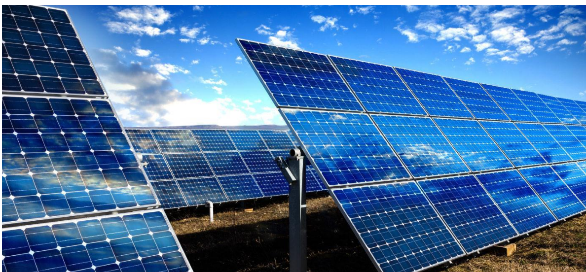
Rys.12 Moduły fotowoltaiczne – trackery o obrocie jednokierunkowym w osi pionowej.
