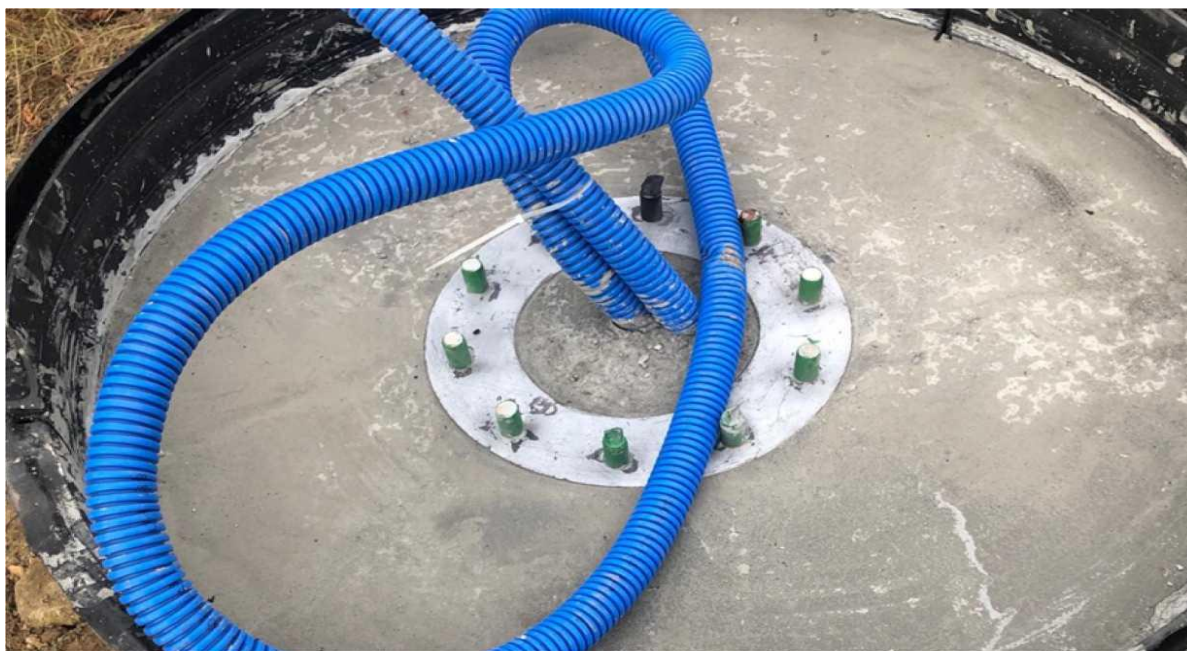
Rys.15 Fundament Trackera przygotowany do montażu stelaża z panelami i systemem nadążnym. .
