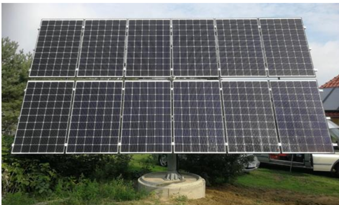
Rys.16 Tracker po montażu.
