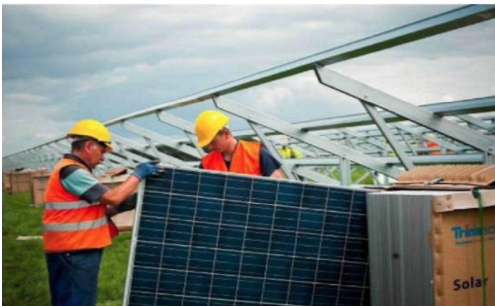
Rys.5 Montaż paneli EPV Bautzen przez Remor Solar- Recz
