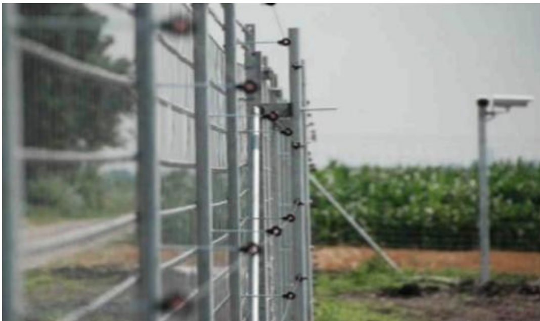
Rys.8 Przykładowe ogrodzenie wraz z systemem alarmowo – monitoringowym
