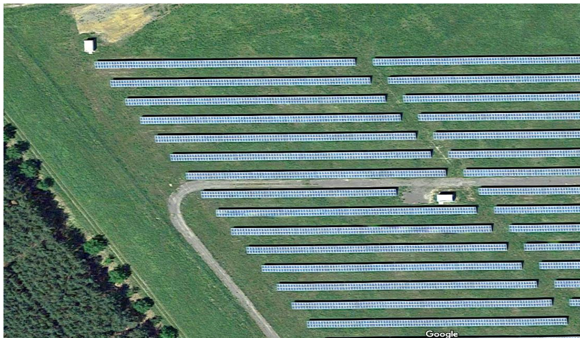
Rys.18 Sposób zagospodarowania terenu elektrowni fotowoltaicznej w miejscowości Seftengberg, Niemcy. Źródło: Google.pl/maps
