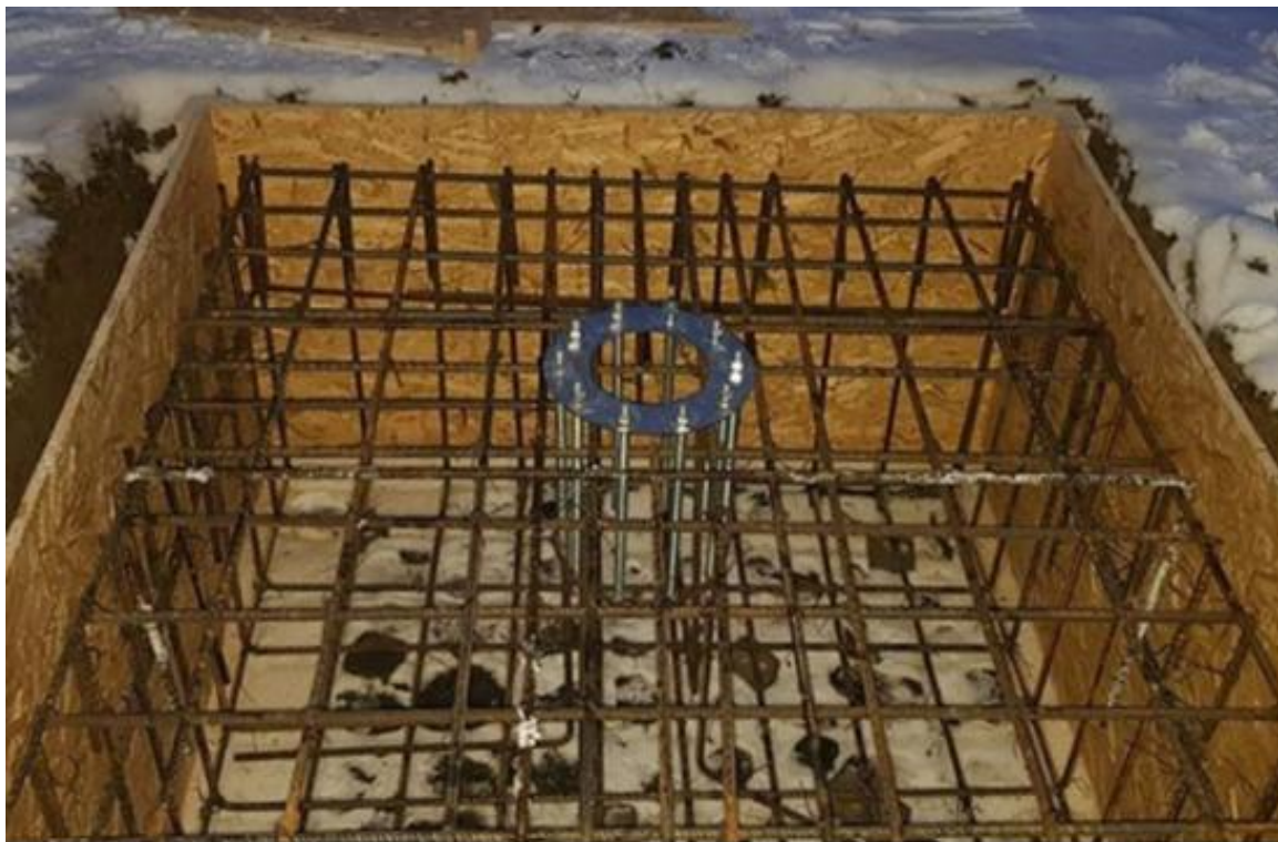
Rys.14 Fundamentowanie konstrukcji Trackera.
