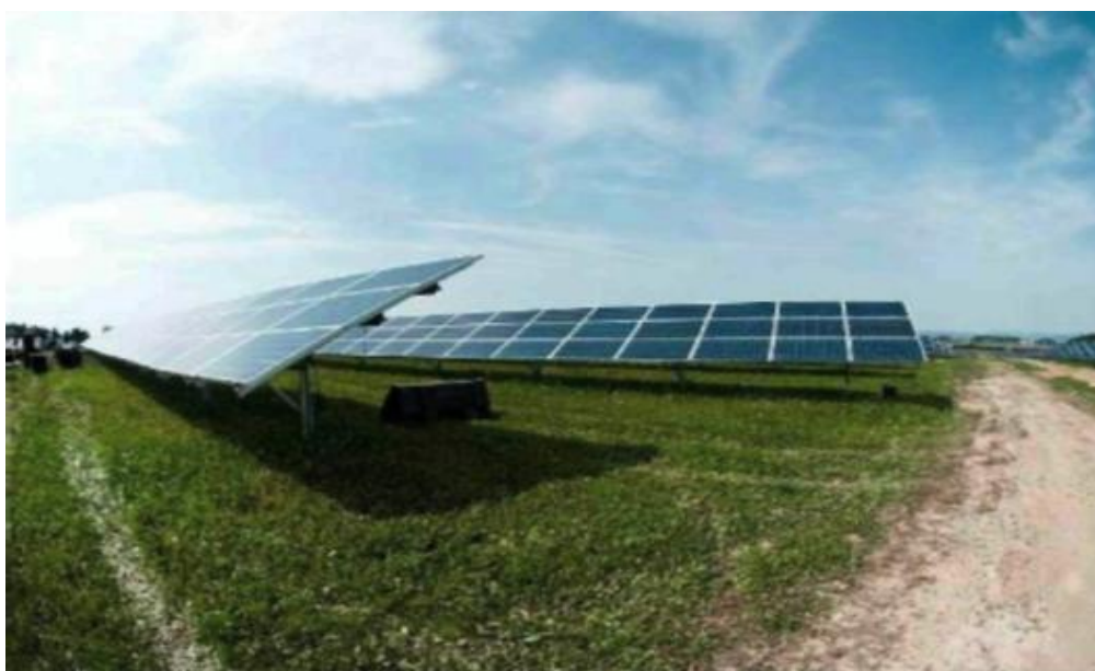
Rys.6 Nieutwardzona ścieżka techniczna wokół terenu inwestycji (EPV Bautzen. RemorSolar)
