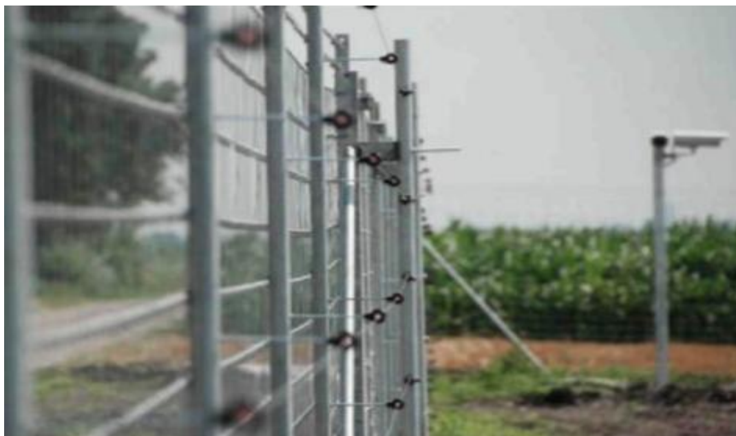
Rys.8 Przykładowe ogrodzenie wraz z systemem alarmowo – monitoringowym
