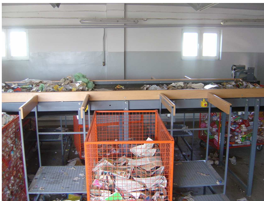
Fot. 2. Linia segregacji odpadów firmy „USKOM” w Mławie
