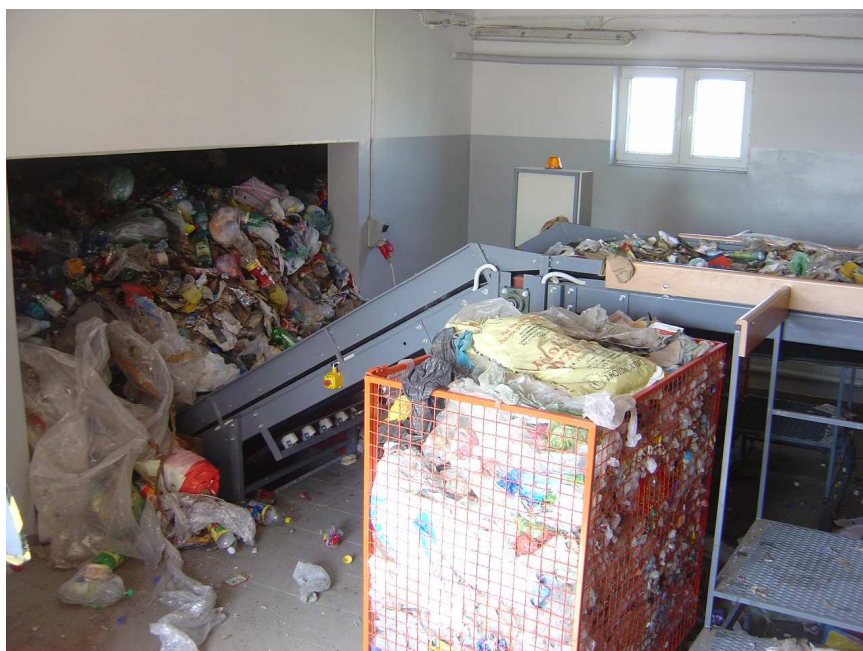
Fot. 1. Linia segregacji odpadów firmy „USKOM” w Mławie
